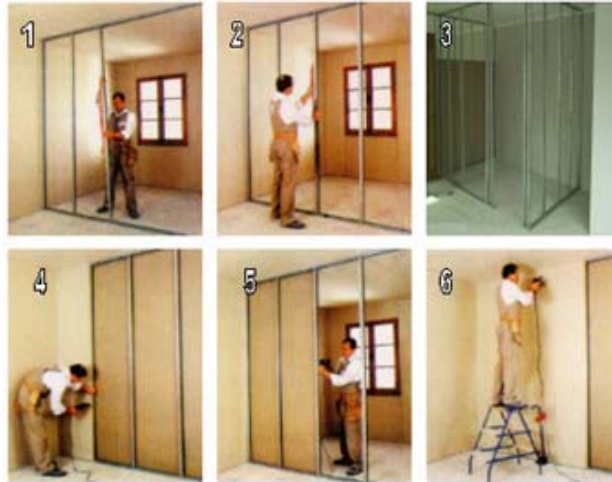
Figura 2.11 Montagem de divisórias em gesso acartonado
