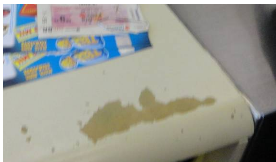
Figura 52 Detalhe do desgaste no tampo do novo balcão implantado.
