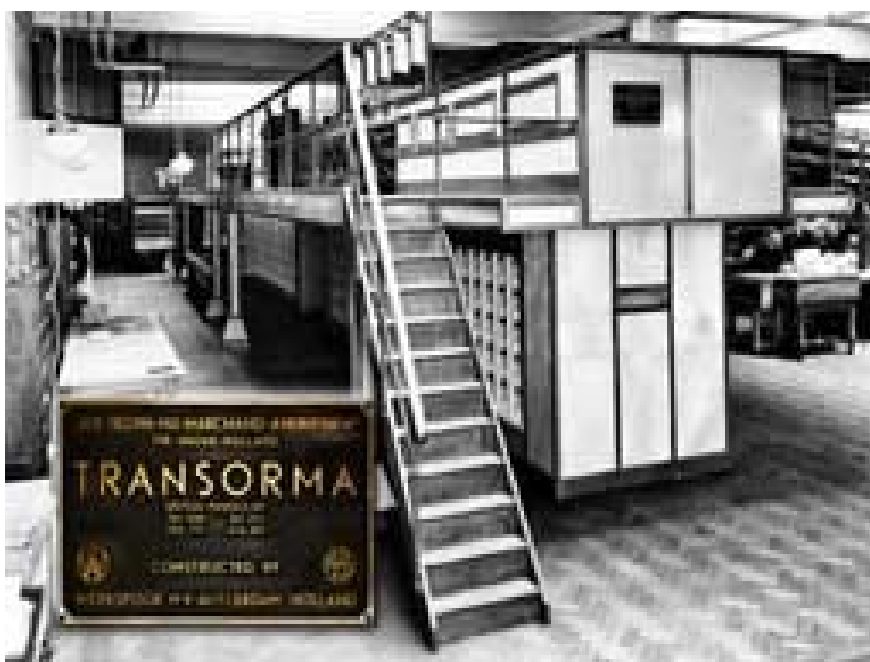
Figura 3.1: Máquina de classificação de cartas. Fonte: Semana da Engenharia, ECT (2005, p.5).
