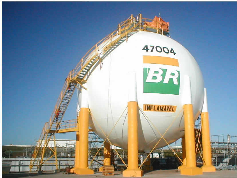
Figura 20: Esferas para área de Equipamentos de Processo
