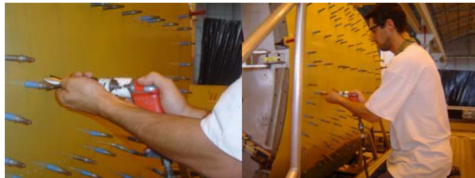
Figura 04: Fotos da Montagem Central II - avião para 40 passageiros – etapa 03.
