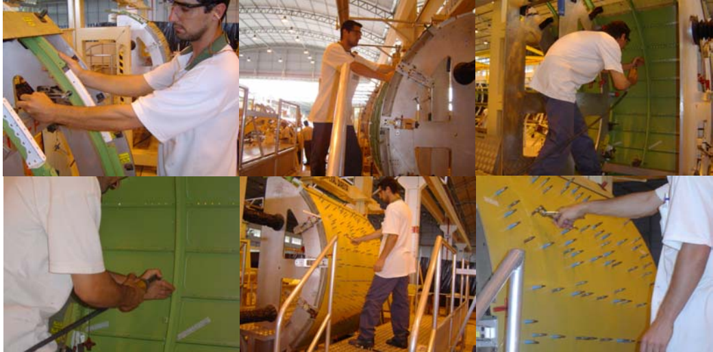
Figura 03: Fotos da Montagem Central II - avião para 40 passageiros – etapa 02.
