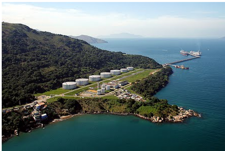
Figura 3.11 – Terminal localizado no estado do Rio de Janeiro.
