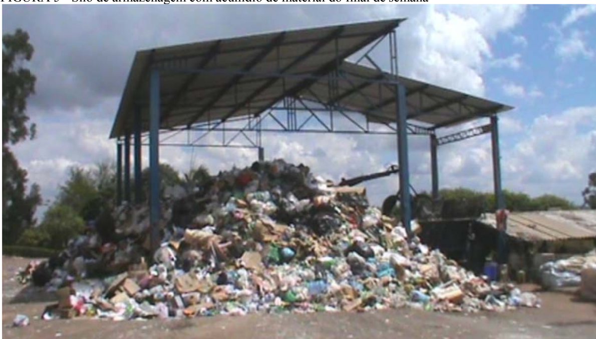
FIGURA 5 - Silo de armazenagem com acúmulo de material do final de semana
