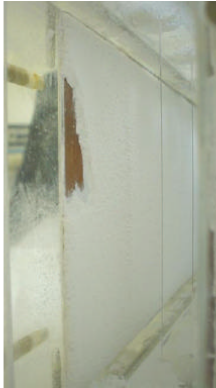
Figura 4.9 - Entrada do precipitador com L_{ne} = 0,30 cm, com ênfase para a espessura da camada de pó coletada.
