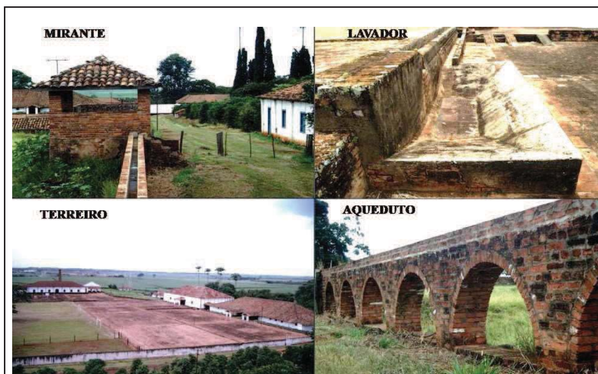
FIGURA 14. Edificações para a produção de café da fazenda Ibicaba (séculos XIX. E XX). Fonte: Fotos de Vladimir Benincasa, 2003.
