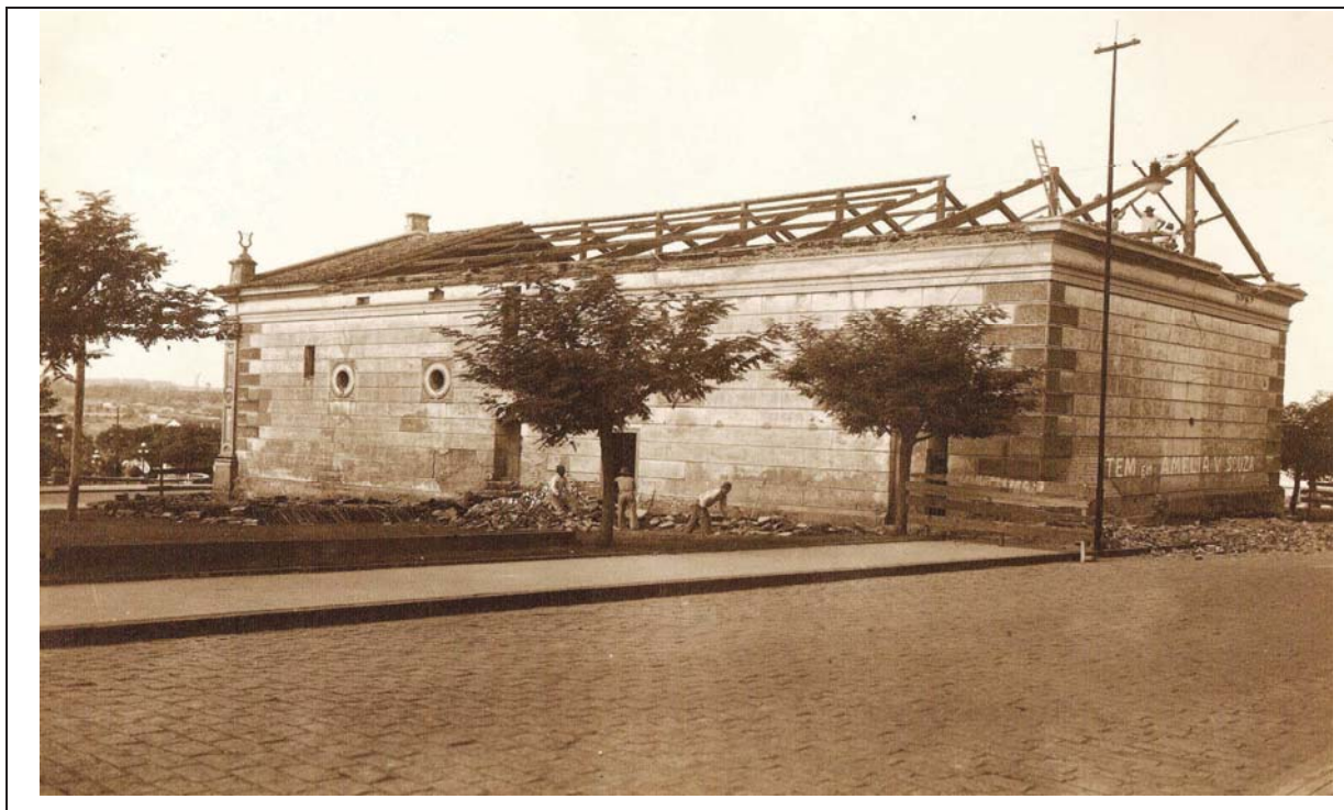
FIGURA 45. Demolição do Teatro da Paz em 1938. Fonte: ACERVO FOTOGRÁFICO, 1950.
