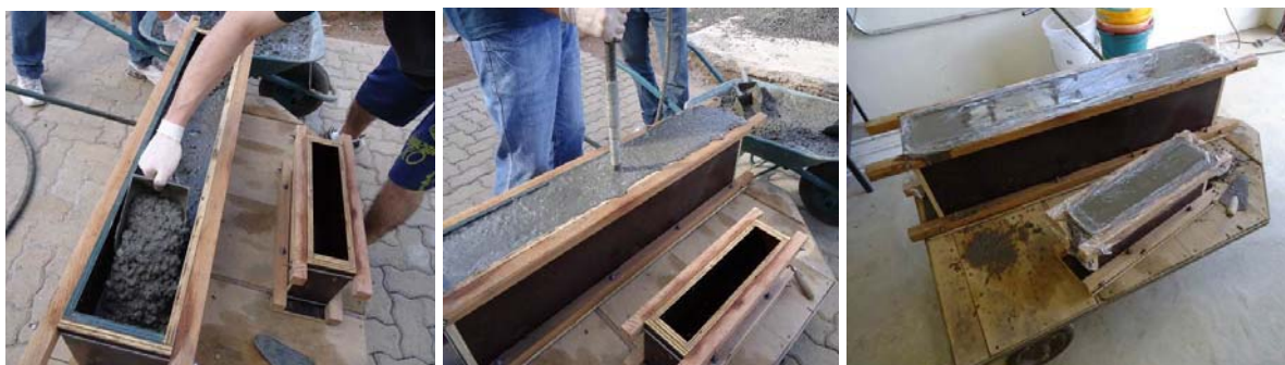
Figura 3.24. Etapa de moldagem e cura das guias de pavimentação
