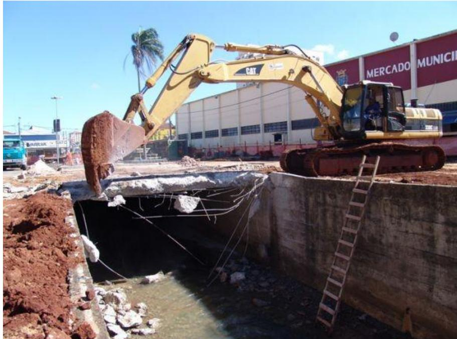
**Figura 30: Rebaixamento da calha do córrego do Gregório, em São Carlos/SP, visando minimizar as inundações na baixada do mercado municipal, 2010.**
