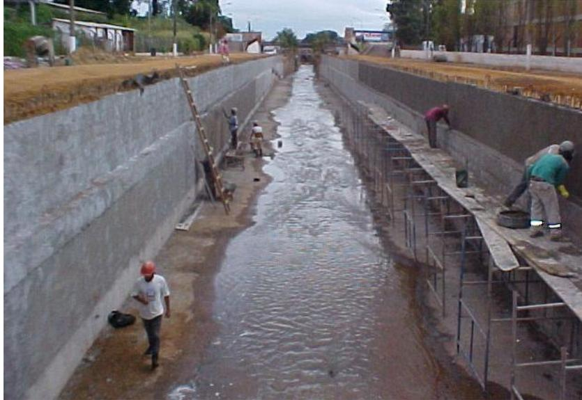
**Figura 12: Canalização e retificação do córrego dos Bagres. Franca/SP.**
