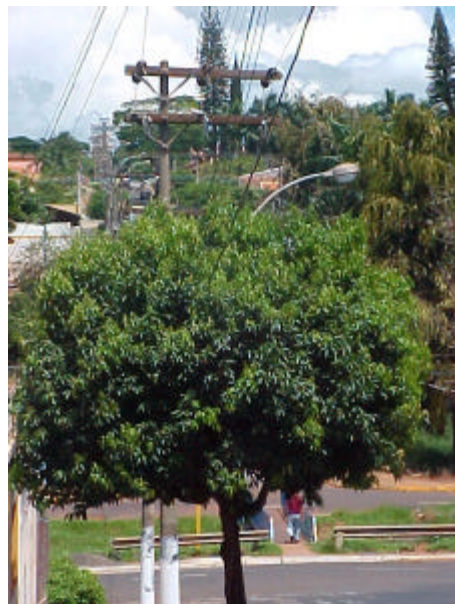
Figura 28 – Problemas na compatibilização da vegetação com a rede elétrica, Jaboticabal (SP) Autor: Autora (2004)
