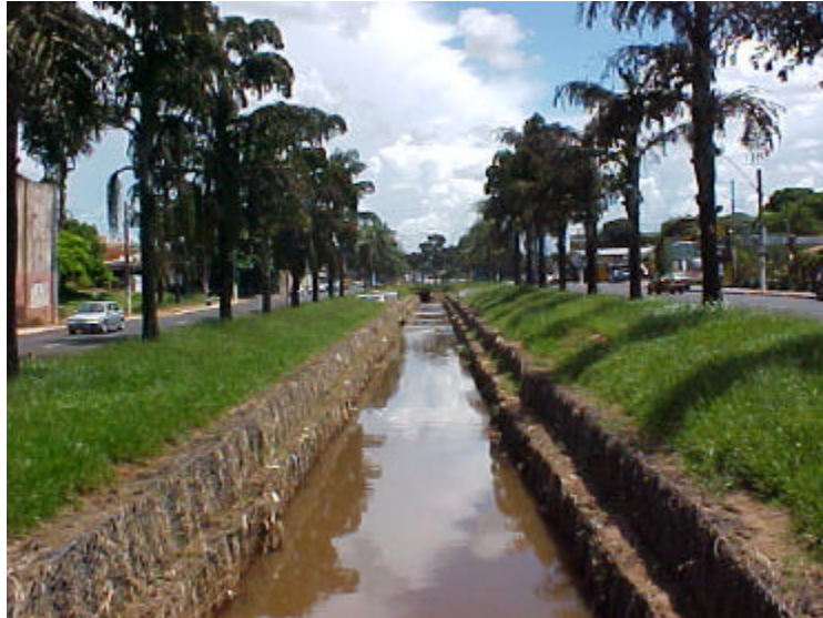
Figura 43 – Córrego Cerradinho canalizado – situação atual. Fonte: Autora (2004)
