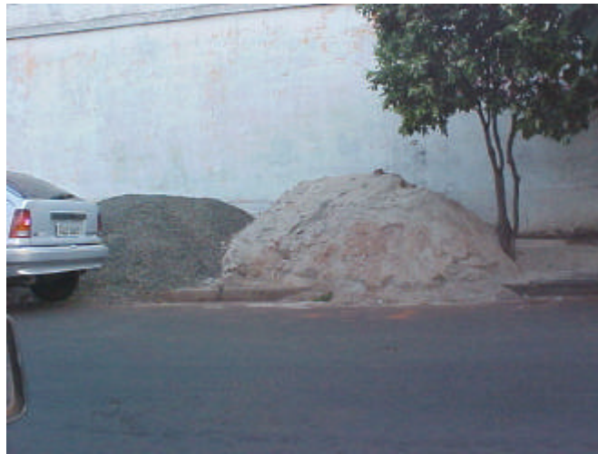
Figura 12 – Materiais de construção indevidamente acomodados impedindo a passagem de pedestres em Jaboticabal – SP Fonte: autora (2003).
