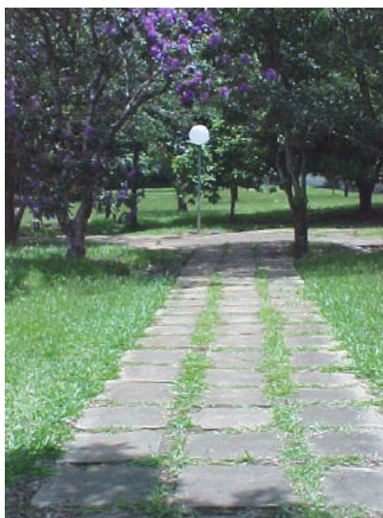
Figura 23 – Calçamento entremeado de grama - Universidade Federal de São Carlos – SP. Fonte: Autora (2004)
