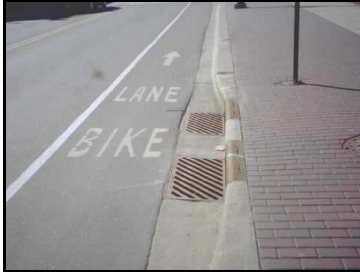
Figura 7.10: Grelha com redução de guia.
