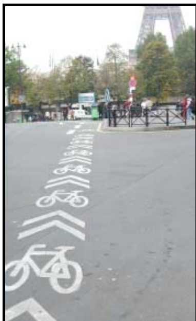
Figura 6.29: Tipo de marcação de interseção (1)
