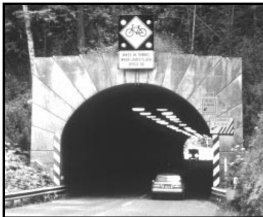
Figura 7.20: Túnel com sinalização de presença de ciclistas.
