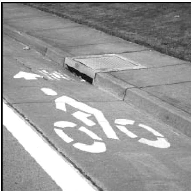
Figura 7.7: Substituição de grelha por boca-de-lobo.
