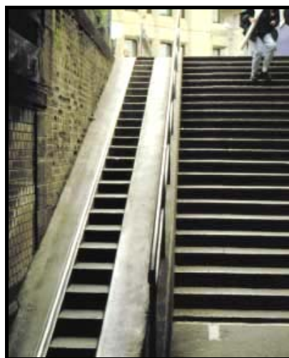
Figura 8.4: Rampa com sulco para bicicletas e carros de bebê e similares.
