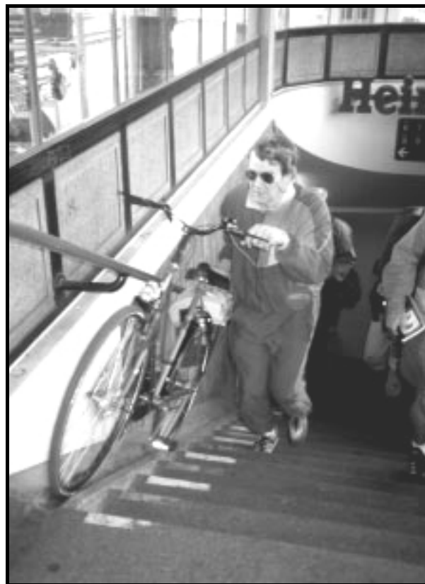
Figura 8.2: Rampa com sulco junto à parede.
