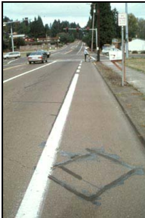
Figura 6.10: Sensor de presença de bicicleta instalado na área de aproximação de interseção.
