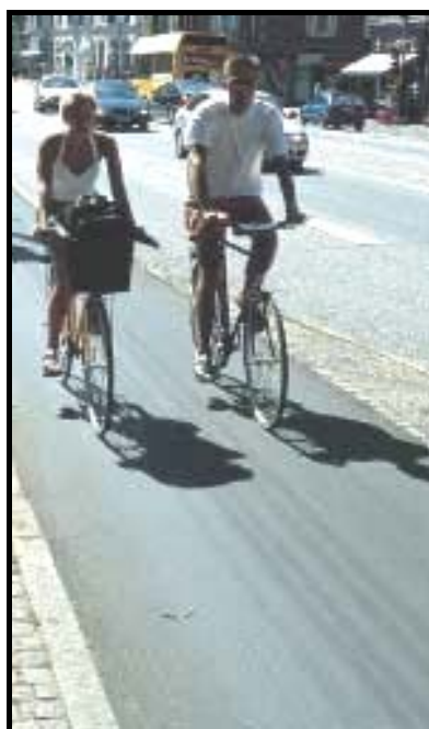
Figura 7.1: Ciclovia com pavimento asfáltico.
