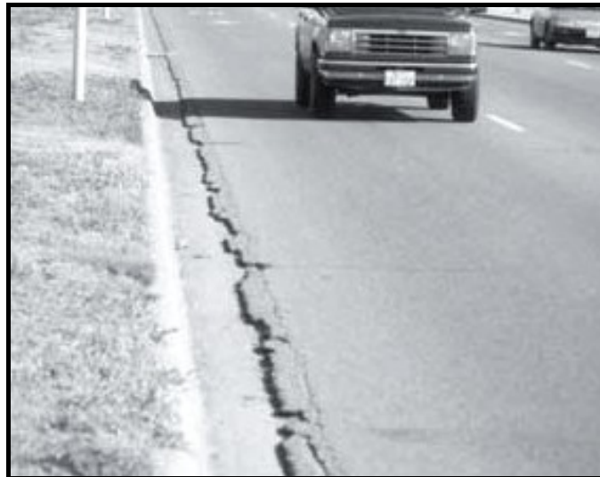
Figura 9.6: Recapeamento inadequado.
