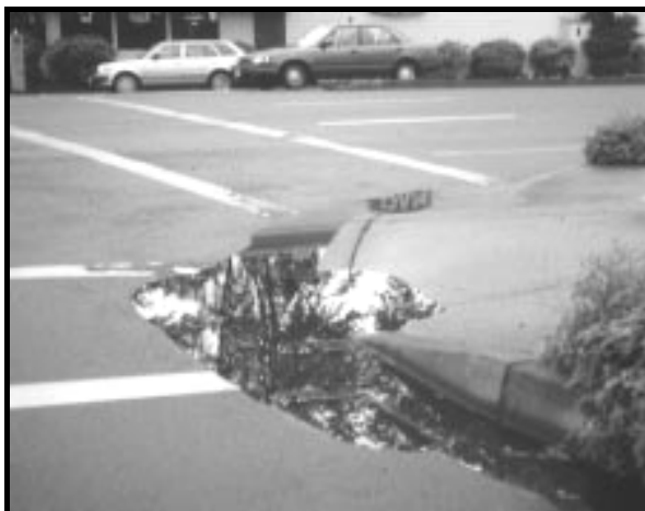
Figura 7.5: Drenagem inadequada.
