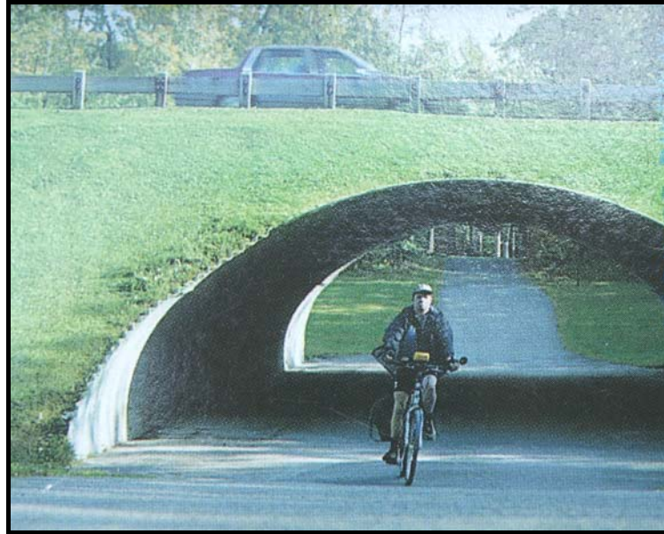
Figura 7.14: Túnel em arco.
