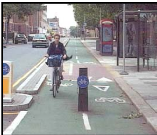
Figura 5.32: Ponto de parada de ônibus com ciclovias passando pela frente.
