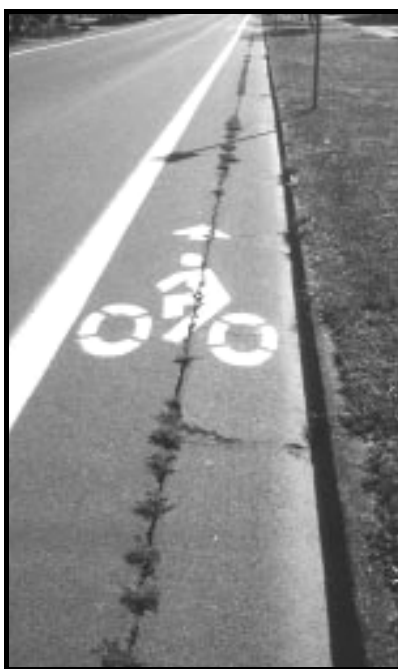
Figura 9.16: Trincas longitudinais
