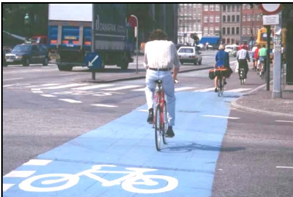
Figura 6.26: Marcação de interseção utilizando cor azul clara.
