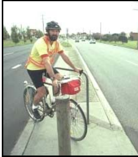
Figura 6.38: Apoio para condutor de bicicleta.
