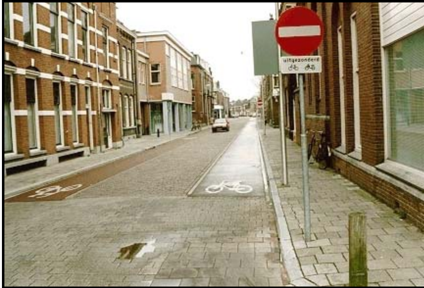
Figura 5.14: Ciclofaixa no sentido contrário ao do tráfego de veículos motorizados
