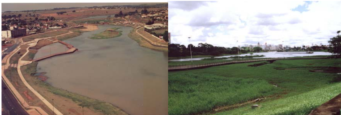
Figura 23 – Assoreamento da Represa de Abastecimento de Água Municipal
