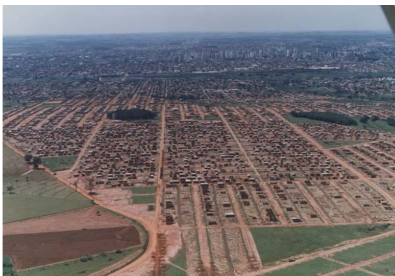
Figura 11 - Loteamento Popular Infra-Estruturado "Solo Sagrado" – fase inicial (Política Municipal de Desenvolvimento Habitacional, 1989)
