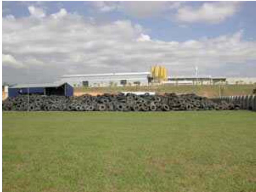
Figura 7: Centro de Trituração de Pneus Inservíveis da ANIP / CIMPOR, em Jundiaí/SP.
