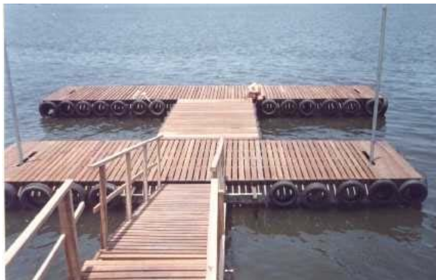
Figura 16: Reutilização de pneus inservíveis para proteção de píer na Ilha Guaraguatá, em Cubatão/SP. Fonte: Marina da Ilha, 2003.
