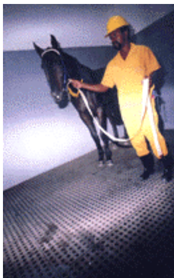
Figura 20: Estrado para baias, confeccionado com borracha de pneus inservíveis.
