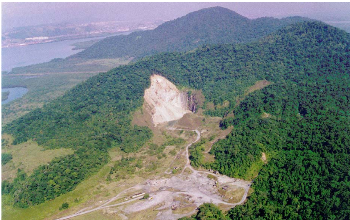
Figura C.7: Sítio da Neves em 1999 – Aterro Sanitário de Santos a partir de 2003
