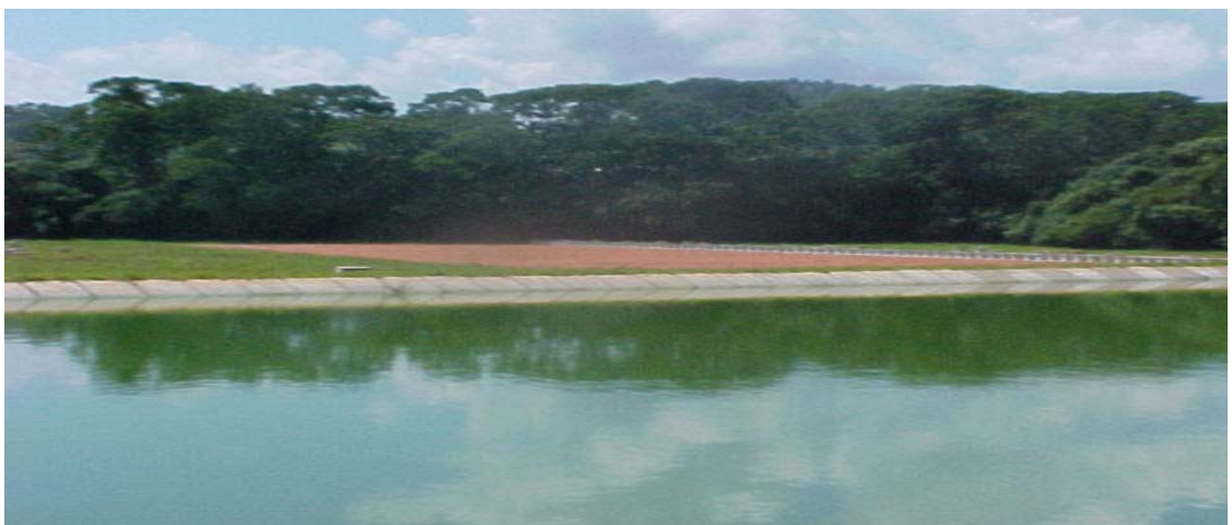
Figura 19 - Foto da lagoa facultativa da ETE Remédios Fonte: Sabesp, 2004.
