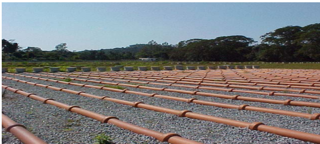
Figura 21 – Foto das valas de infiltração da ETE Remédios
