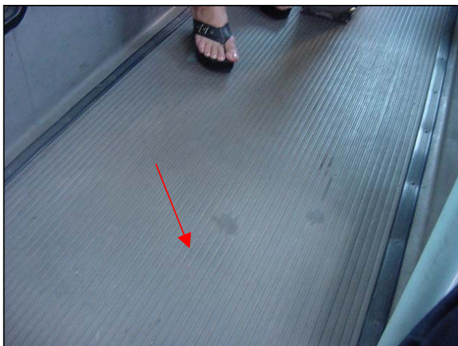
Foto nº 13 Detalhe do piso
