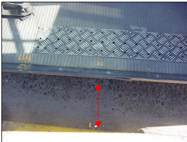
Foto nº 21 Detalhe da altura da plataforma
