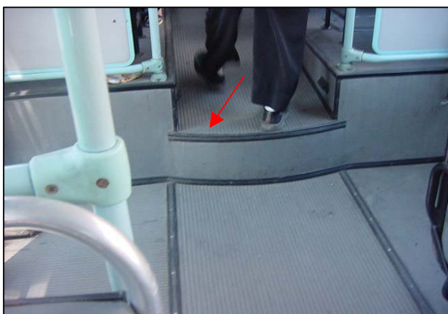
Foto nº 23 Detalhe do segundo piso
