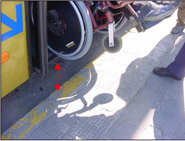
Foto nº 17 Detalhe da altura da altura da plataforma do ônibus em relação a calçada
