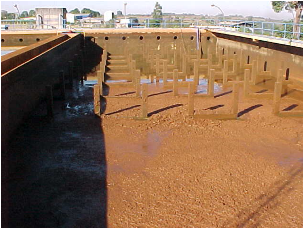
Figura 3.2 – Foto ilustrativa da limpeza dos decantadores de ETA
