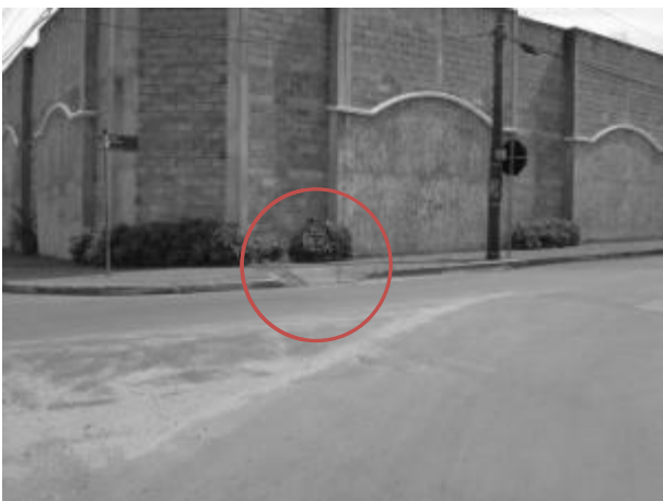
Foto E2-5 Rampa de acesso a calçada no entorno.
