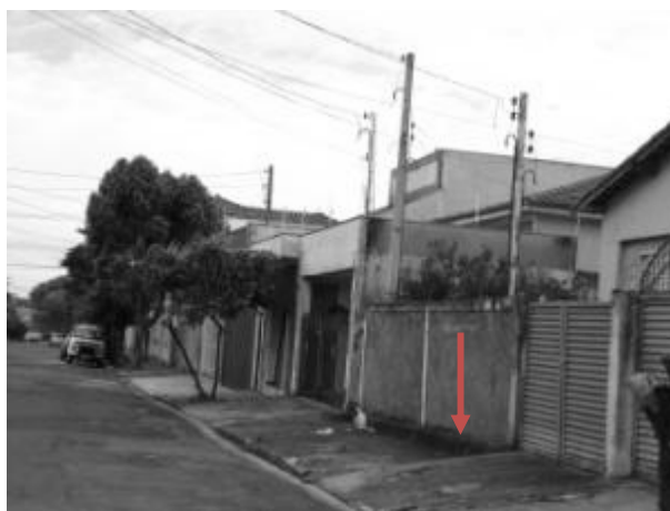
Foto E5-18 Calçada com degraus
