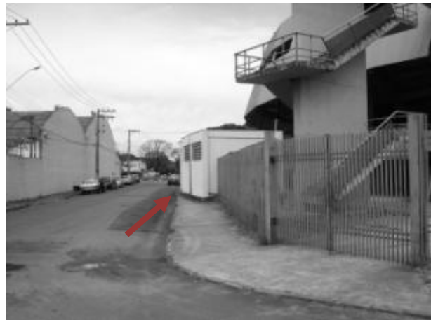
Foto E3-4 Inexistência de passeio junto ao Ginásio, em rua adjacente à entrada principal.
