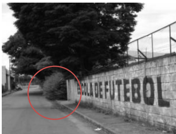
Foto E3-30 Plantio inadequado de vegetação, tornando a calçada intransitável.
