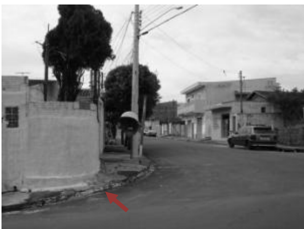
Foto E1-9 Estreitamento da calçada
