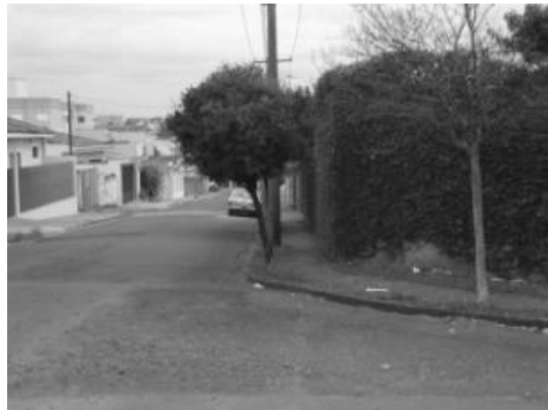
Foto E6-8 Calçamento em concreto e cobertura vegetal
