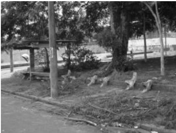
Foto E2-21 Praça em péssimo estado de conservação
