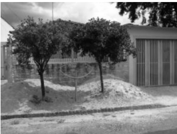
Foto E4-11 Utilização da calçada para depósito de material de construção.
