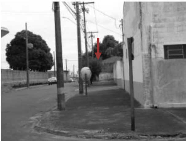
Foto E3-7 Padrão de via do entorno. Observar descontinuidade causada pela diminuição da largura da calçada.
