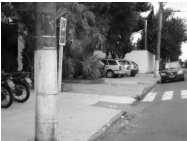
Foto E3-11 Rampa de acesso à calçada, sinalizada e em local adequado.
