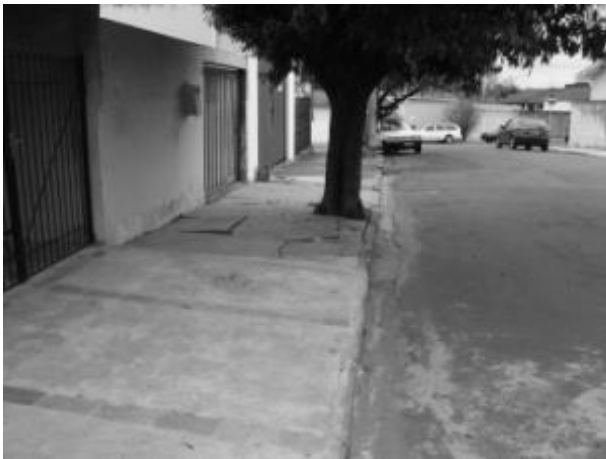
Foto E6-21 Passeio com diversos tipos de calçamento
