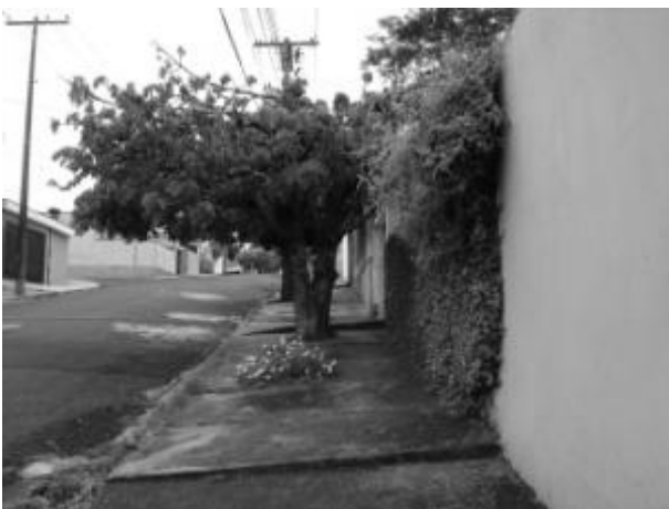
Foto E5-23 Plantio inadequado de vegetação.
