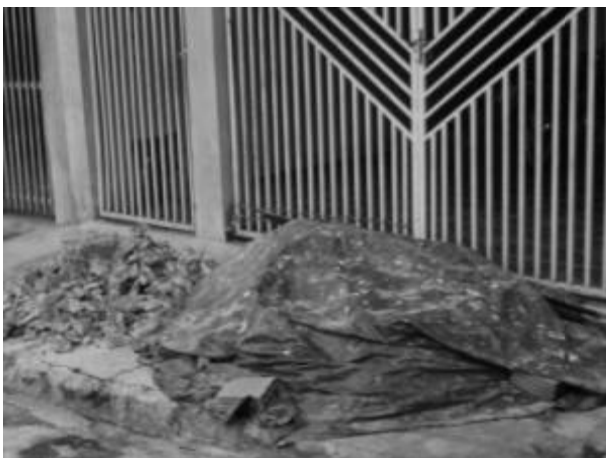
Foto E1-29 Utilização da calçada para depósito de entulho e material de construção.
