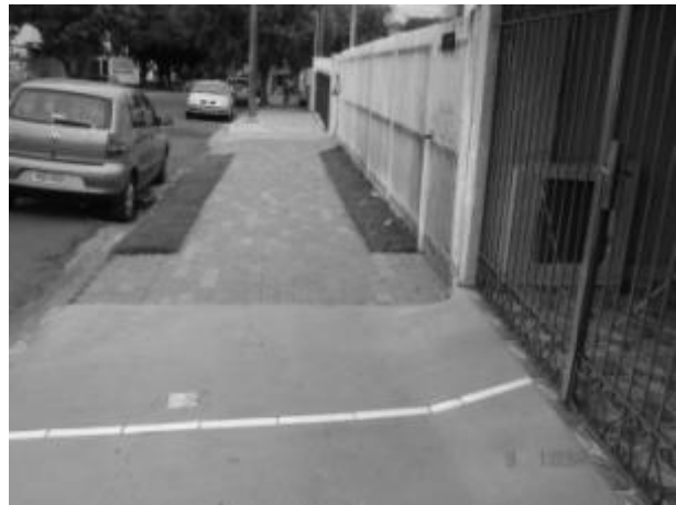
Foto E6-16 Calçamento em bom estado de conservação
