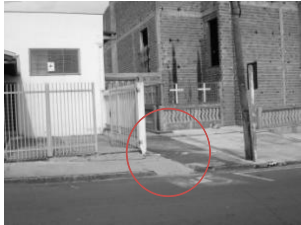
Foto E1-20 Rampa de acesso com sinalização adequada, implantada em local inadequado
