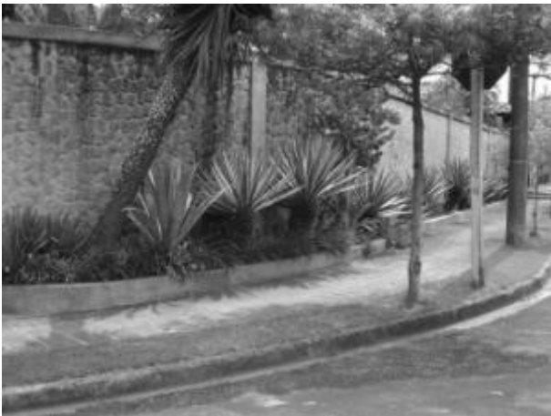
Foto E4-21 Calçada em ótimo estado de conservação, porém com plantio inadequado de vegetação.
