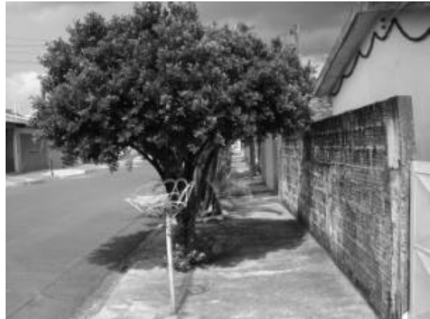
Foto E4-2 Calçada em concreto.
