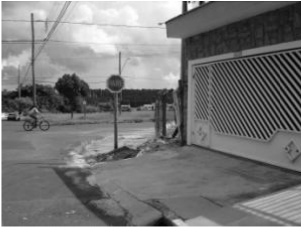
Foto E4-13 Entulho e material de construção sobre a calçada.
