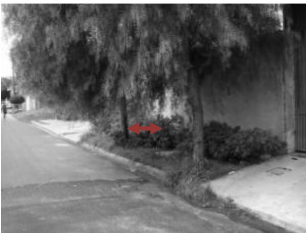
Foto E1-5 Plantio inadequado de árvore junto à calçada.
