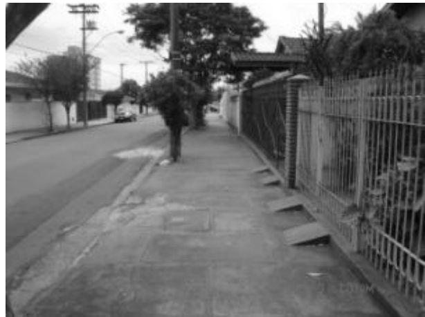
Foto E6-14 Calçamento em concreto
