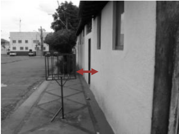
Foto E3-13 Posicionamento inadequado do mobiliário urbano.
