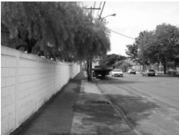
Foto E2-13 Padrão de calçada na Rua Cel Júlio Sales, próximo a Electrolux
