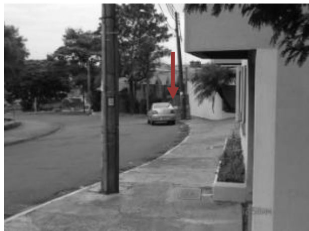
Foto E6-12 Obstrução no passeio – caçamba para lixo
