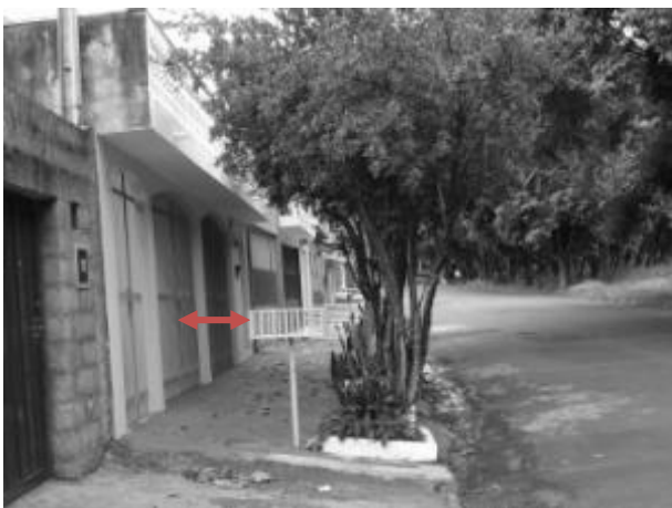
Foto E5-25 Estreitamento do passeio causado por posicionamento inadequado do mobiliário urbano.
