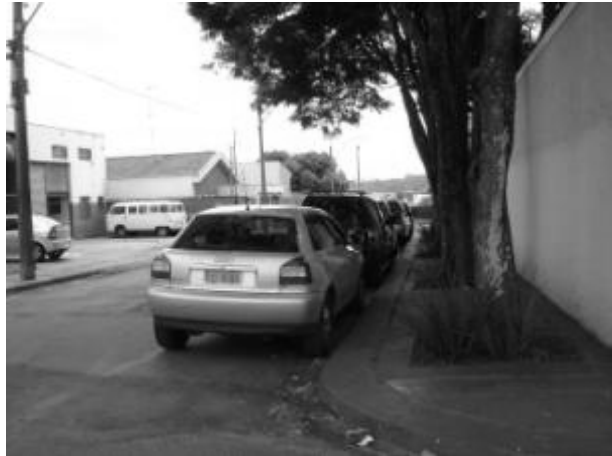
Foto E3-14 Calçadas estreitas e árvores plantadas em local inadequado.
