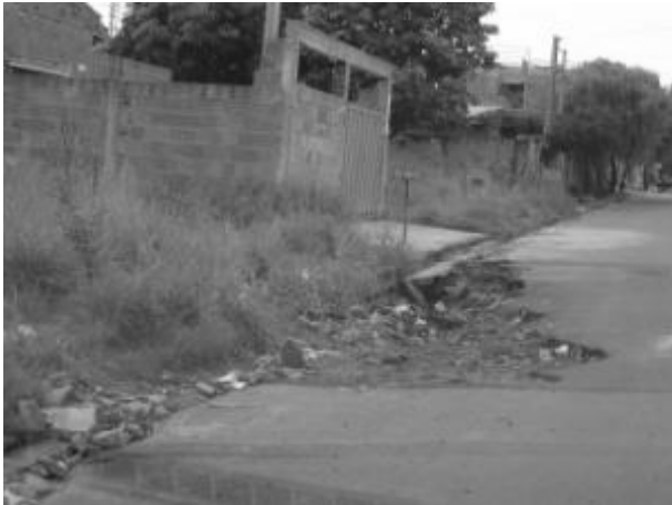
Foto E1-25 Área sem calçamento junto a lote vago e calçada em péssimo estado de conservação.
