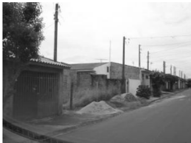
Foto E1-6 Utilização da calçada para depósito de material de construção..
