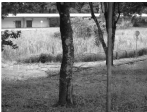
Foto E5-30 Manutenção deficiente na área interna do parque.
