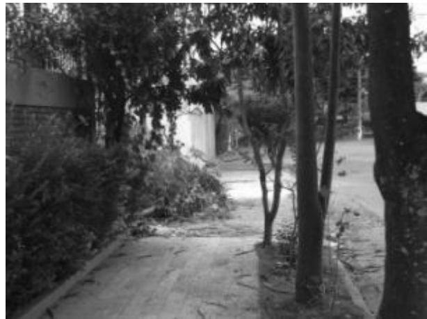
Foto E6-10 Obstrução no passeio
