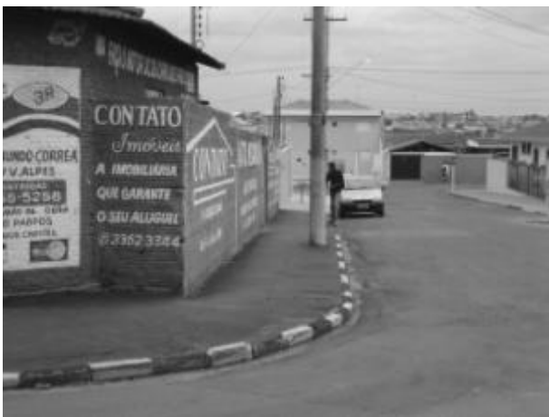
Foto E6-5 Calçamento em concreto, sem arborização.
