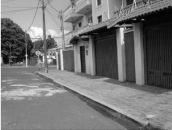
Foto E4-19 Calçada em bom estado de conservação.
