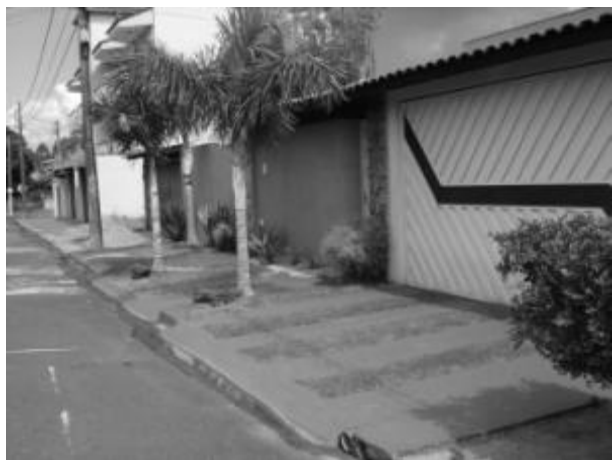
Foto E4-18 Calçada em ótimo estado de conservação, porém com plantio de vegetação inadequado.
