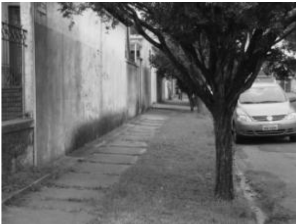
Foto E6-3 Calçamento em concreto e cobertura vegetal
