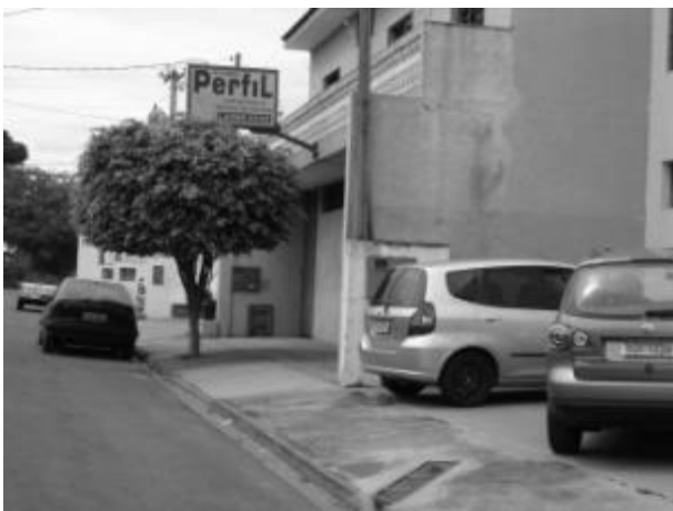
Foto E3-23 Estreitamento do passeio por arborização
