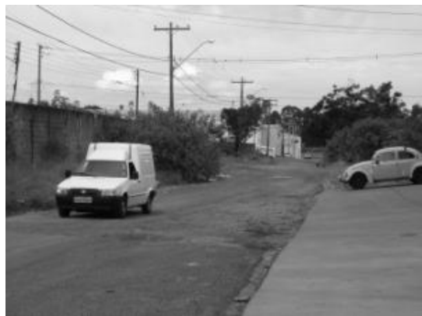
Foto E3-24 Área entorno sem vias asfaltadas.
