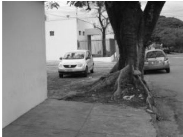
Foto E6-20 Obstrução do passeio por raízes de árvores
