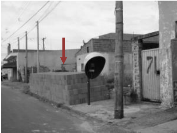
Foto E1-19 Utilização da calçada para depósito de material de construção.
