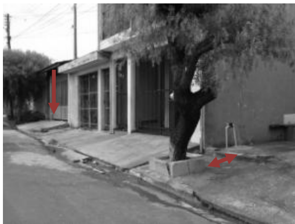
Foto E1-12 Degraus para acesso à garagem e plantio inadequado de árvore.
