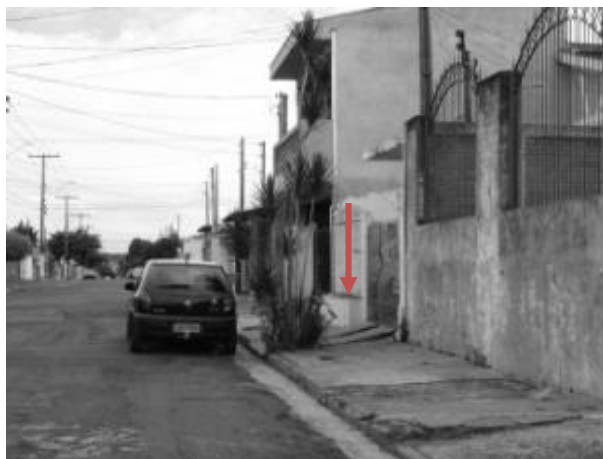
Foto E5-14 Obstruções no passeio.
