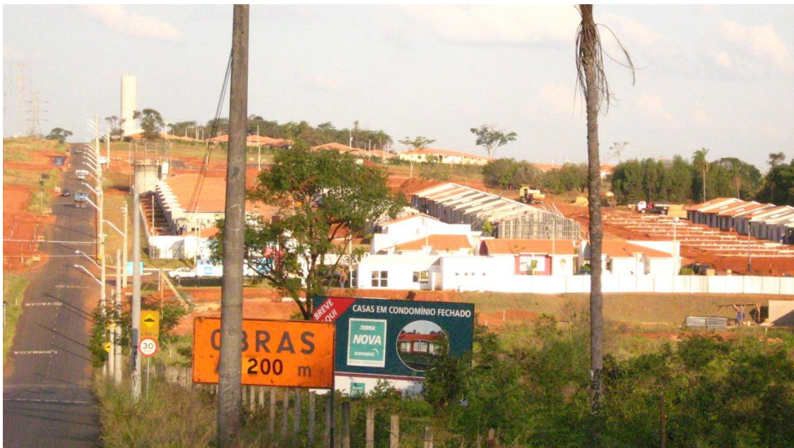
Figura 88 – Imagem da construção do Gardem Village
