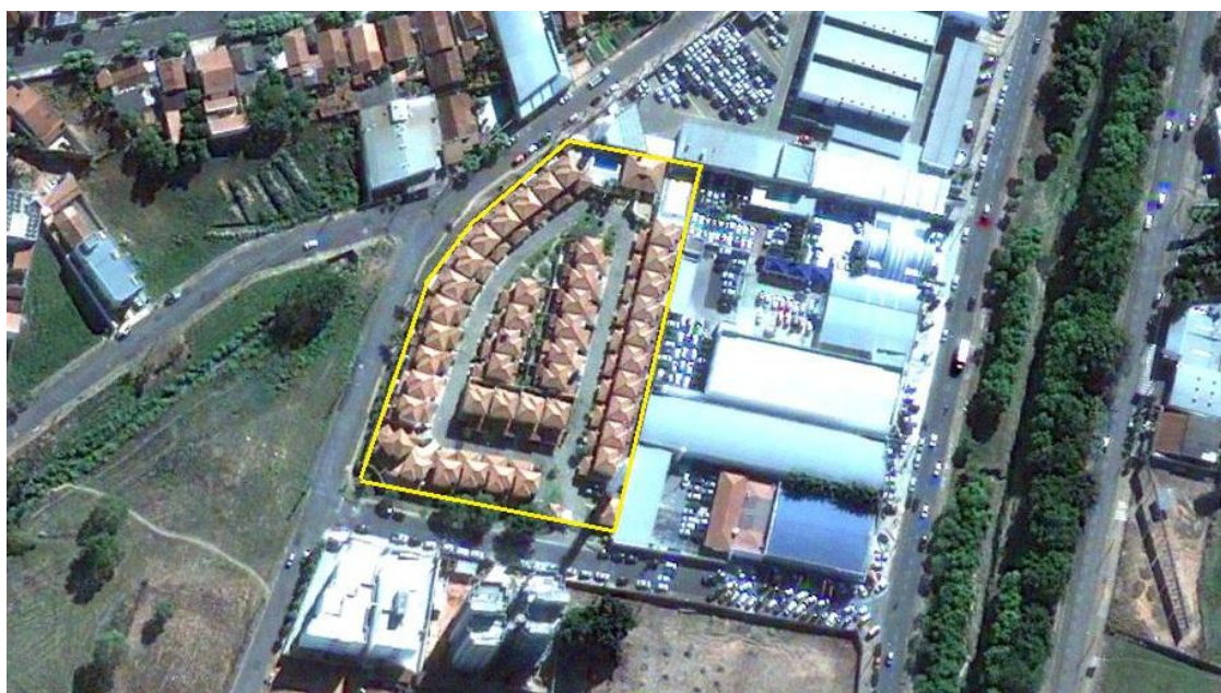
Figura 68 – Vista do Residencial Las Palmas
