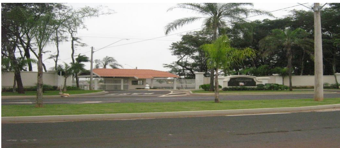
Figura 94 – Vista do portal de entrada – Cond. Amazonas
