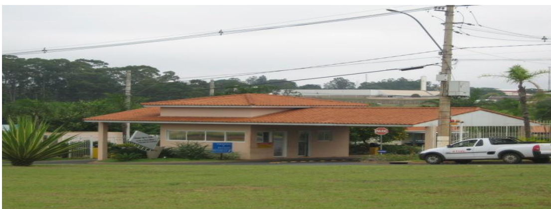
Figura 91 – Portal de entrada do condomínio Jardins de Athenas
