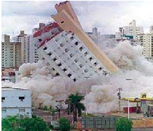
Figura 15 – Implosão das torres Protugal e Espanha
