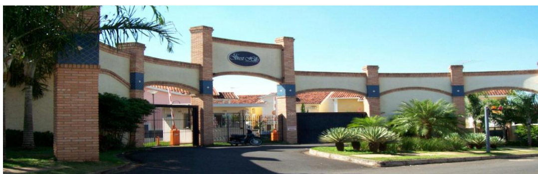
Figura 44 – Portal de entrada do Forest Hills
