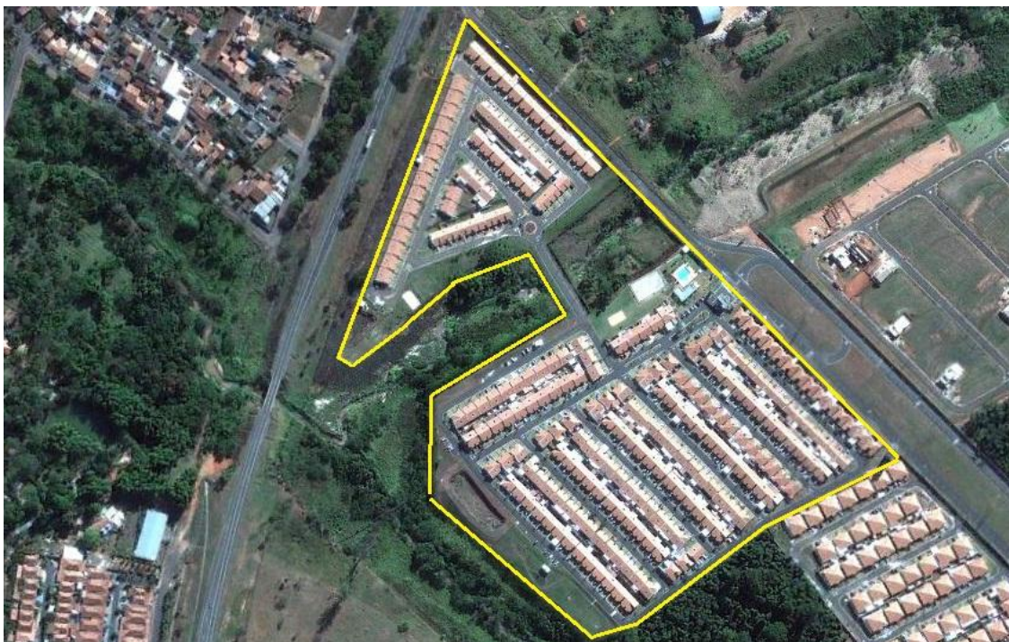
Figura 89 – Vista geral do Village Rio da Prata
