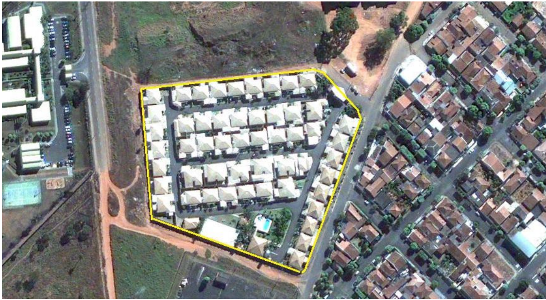
Figura 80 – Vista geral do Village Rio da Prata
