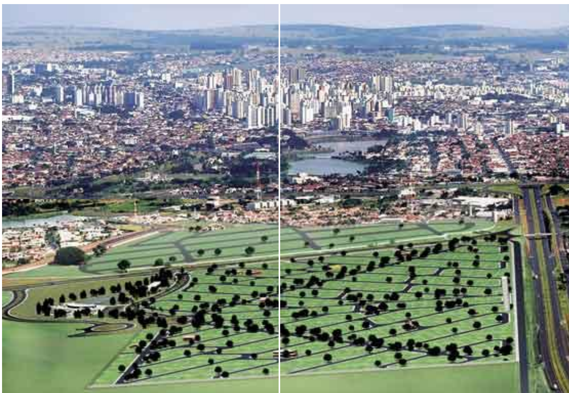
Figura 57 – Vista do Condomínio Figueira Fonte: Agroseta (2005).
