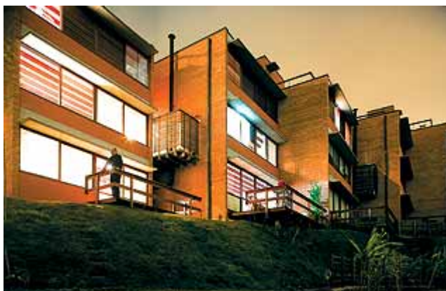
Figura 2-14 Conjunto Residencial Vila Butantã – Projeto de Marcos Acayaba.
