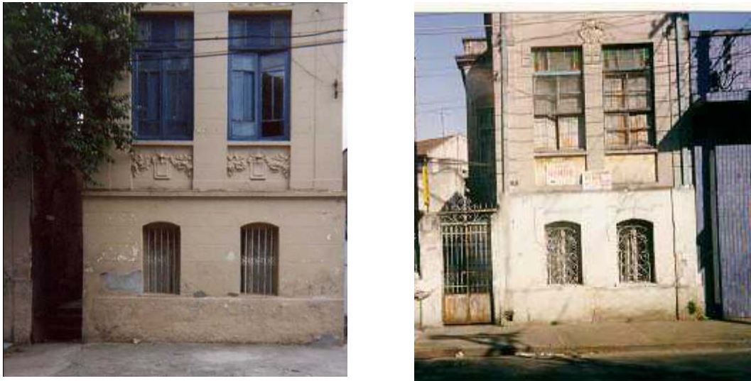
Figura 2-4 Casa com porão na Rua Teodoro – São Paulo
