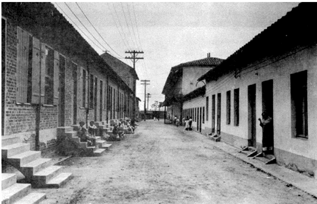
Figura 1-1 Vila Cia. Vidraria Santa Marina
