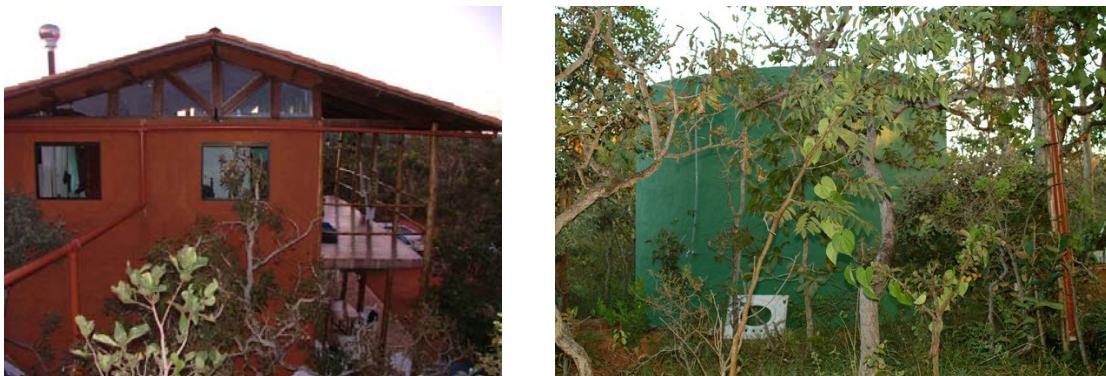
Figura 3-21 Coleta da água de chuva e reservatório da água de chuva.
