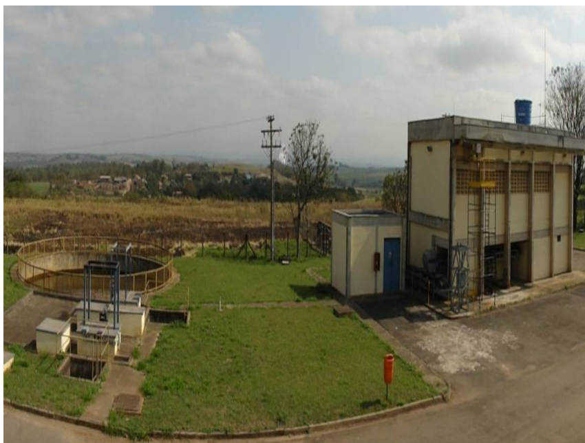
Figura 31 - Vista Geral da ETL Capim Fino em Piracicaba - São Paulo (área de disposição final do lodo ao fundo). Fonte: BioCiclo (2010).
