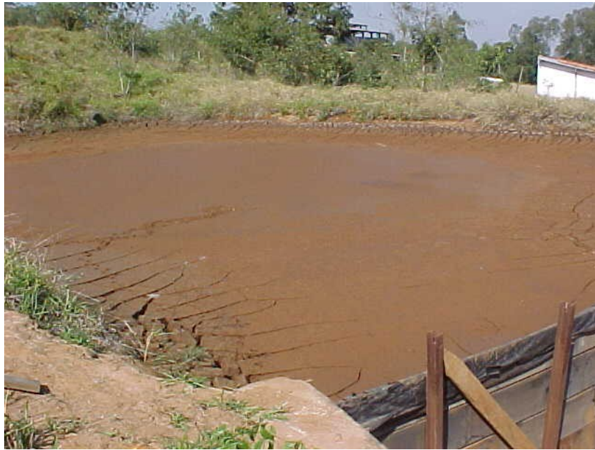
Figura 08 - Lagoa de lodo no início do processo de remoção de água - ETA Rio Claro - SP - Fonte: Achon (2008).
