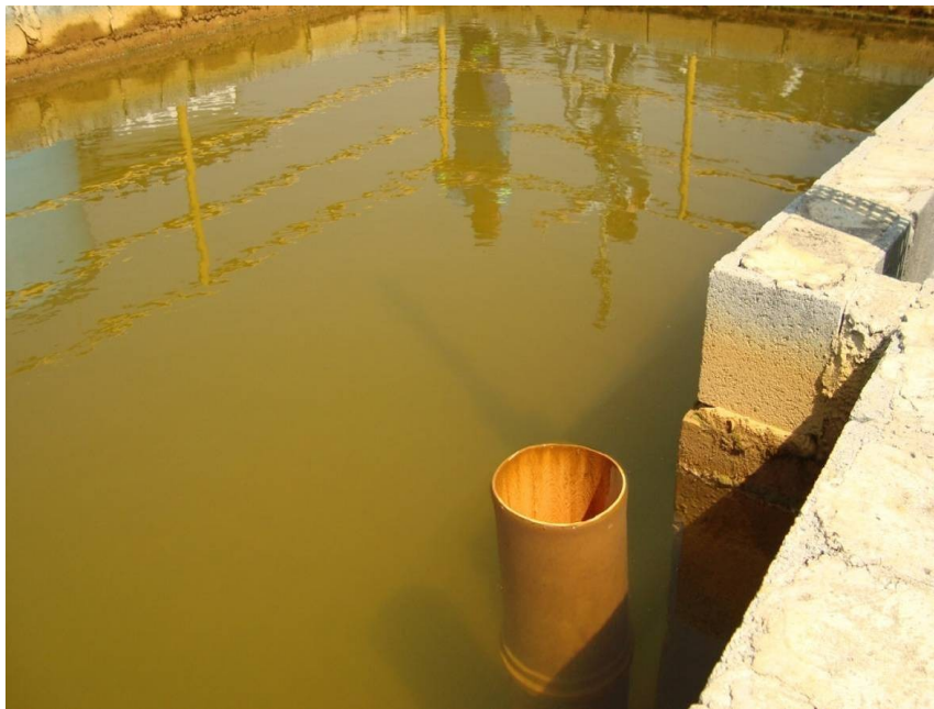
Figura 52 - Detalhe da saída do efluente sobrenadante que retorna ao tratamento. Fonte: SABESP (2010).
