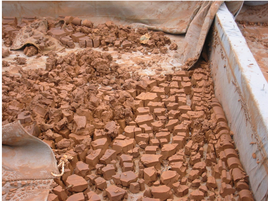
Figura 11 – Vista dos Sólidos e manta geotextil após a “drenagem” junto ao leito - ETA Cardoso - SP. Fonte: Fontana (2004)
