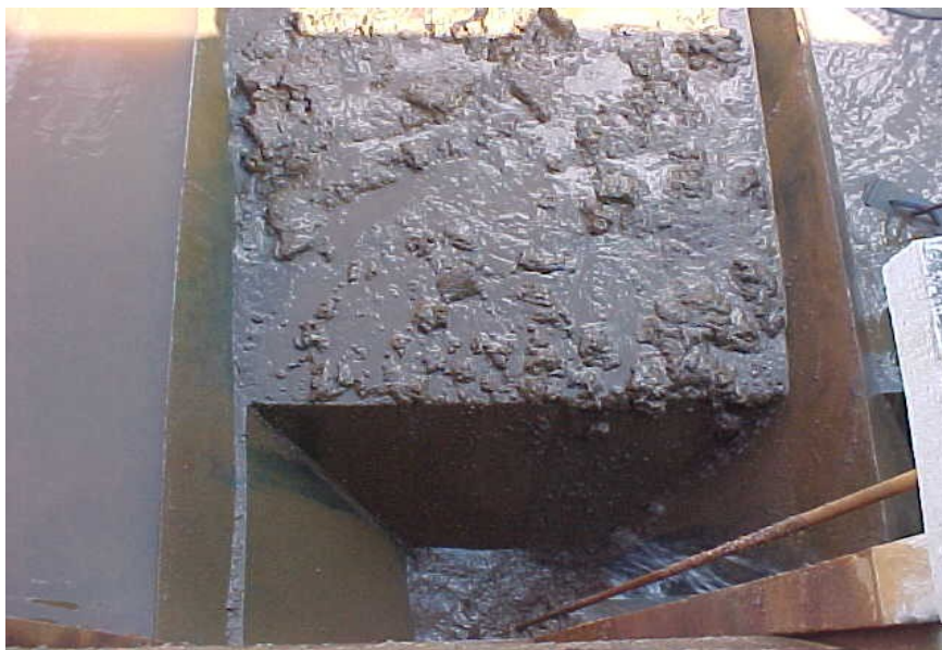
Figura 06 - Descarga do lodo no decantador na ETA - Rio Claro - Fonte: Achon (2008)
