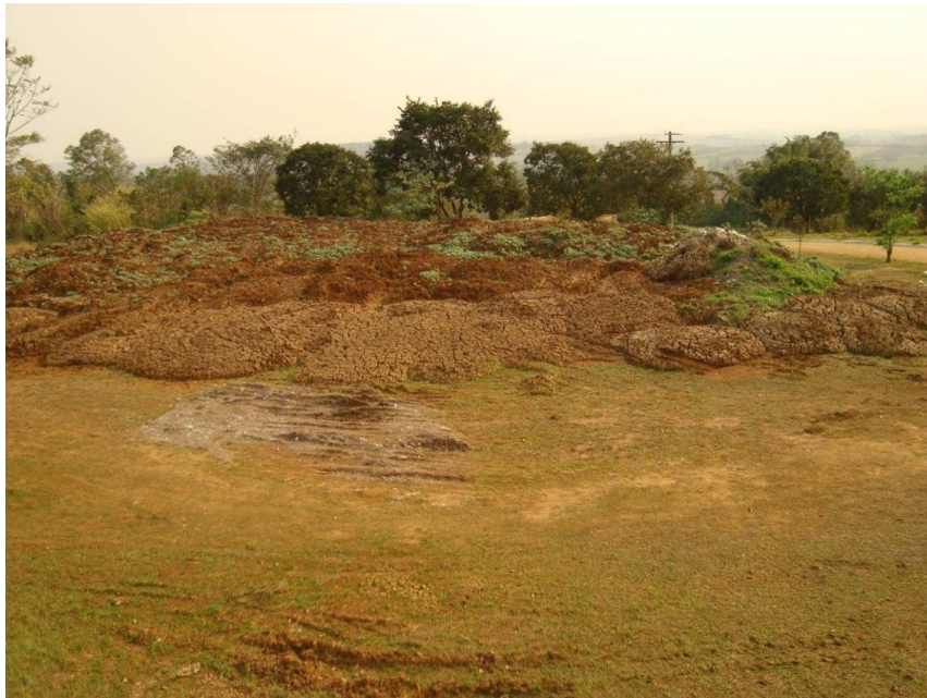
Figura 45 - Vista geral da secagem do lodo de ETA. Fonte: DAAE Rio Claro (2010).
