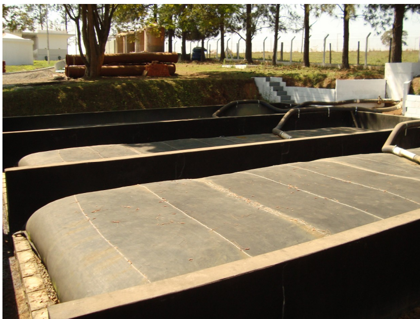
Figura 47 - Vista geral dos “bag”s instalados na ETA Monte Mor - SP. Fonte: SABESP (2010).
