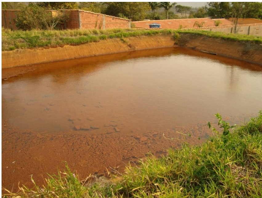
Figura 44 - Vista parcial da lagoa de decantação com material decantado. Fonte: DAAE Rio Claro (2010).
