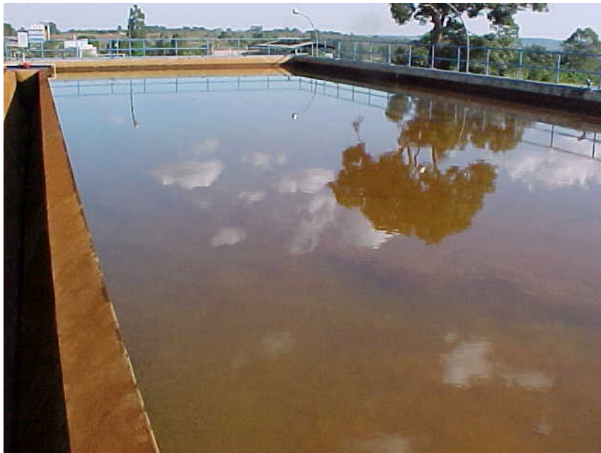
Figura 04 - Decantadores da ETA em funcionamento no município de Rio Claro - SP - Fonte: ACHON (2008)
