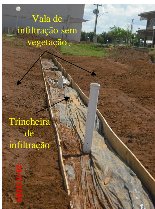
Figura 33: Transporte de sedimento para a trincheira de infiltração, protegida por lona e contenção de madeira.
