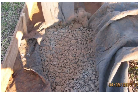
Figura 34: Sedimentos transportados para o interior da trincheira que se acumularam na brita. (ponto P6 da Figura 18). Fonte: Gutierrez et al., 2010.
