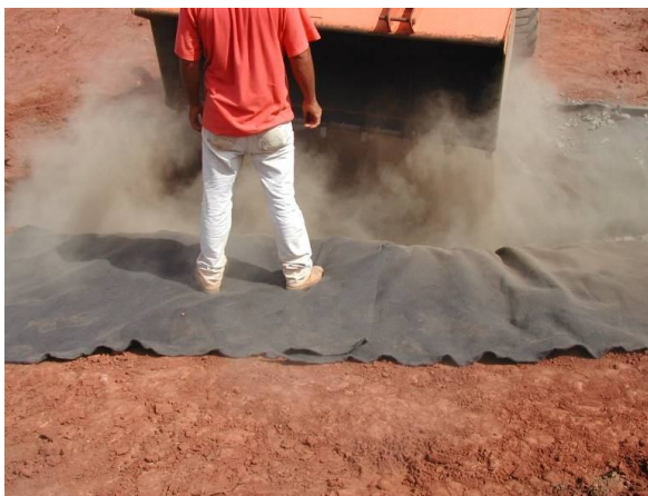
Figura 32: Lançamento da brita de preenchimento na trincheira de infiltração. Fonte: Gutierrez et al., 2010.
