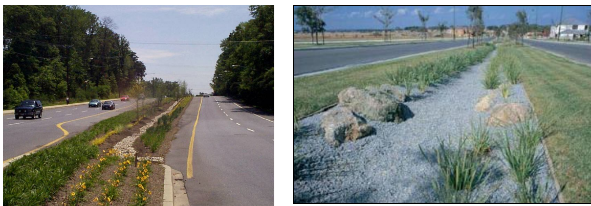
Figura 4: A) Exemplo de trincheira e vala de infiltração. Fonte: LID Center, 2011. B) Exemplo de trincheira de infiltração. Fonte: Tomaz, 2005.
