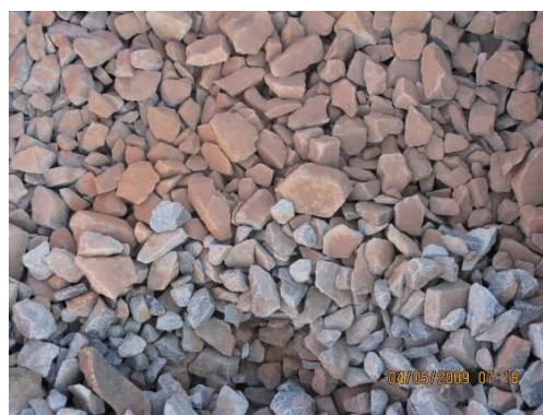
Figura 34: Sedimentos transportados para o interior da trincheira que se acumularam na brita. (ponto P6 da Figura 18). Fonte: Gutierrez et al., 2010.
