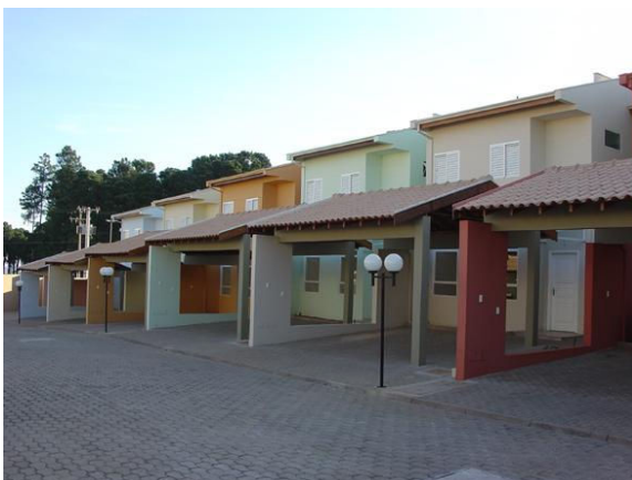
Figura 05. Condomínio de pequeno porte Villa Della Riviera. Fonte: Autora.
