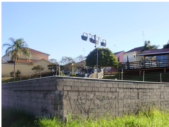
Figura 28. Muro de fechamento do Condomínio Parque dos Ypês. Fonte: Autora.
