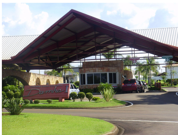
Figura 30. Guarita de condomínio fechado Dahma I. Fonte: Autora.
