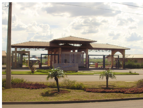
Figura 31. Guarita de condomínio fechado Village Dahma II. Fonte: Autora.
