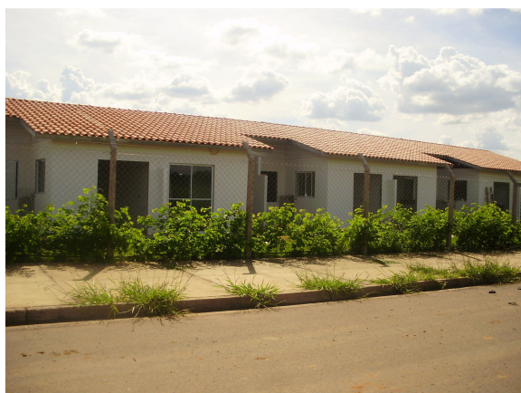
Figura 39. Condomínio Moradas São Carlos – residências prontas. Fonte: Autora.
