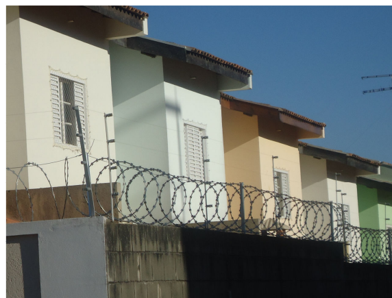
Figura 35. Condomínio Villa Della Riviera. Fonte: Autora.
