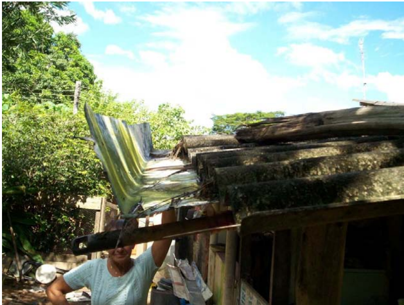
FIGURA 4.1.5 - Sistema rudimentar de calhas em chapa de alumínio para captação de água de chuva, apresentado no assentamento (arquivo da pesquisa)
