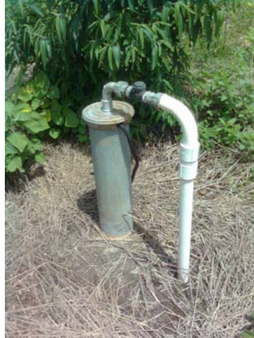
FIGURA 4.1.3 - Modelo de poço semiartesiano implantado no assentamento (arquivo da pesquisa)
