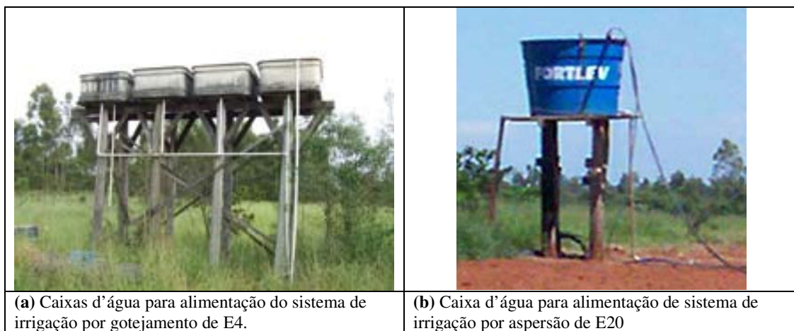
FIGURA 4.1.8 - Reservatórios individuais de alimentação de sistemas de irrigação (arquivo da pesquisa)
