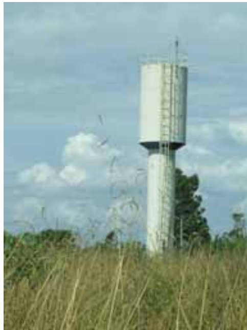
FIGURA 4.1.7 - Modelo de reservatório coletivo, com capacidade para 20 mil litros, implantado no assentamento (arquivo da pesquisa)
