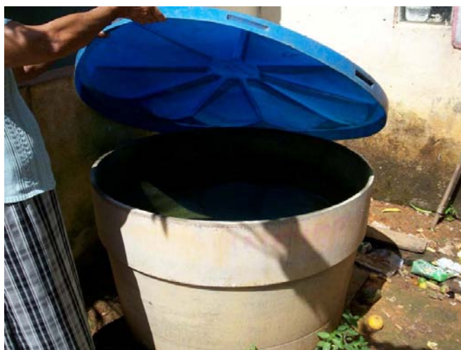
FIGURA 4.1.11 - Cisterna de E14 e E15, utilizada para reservação de água de chuva (arquivo da pesquisa)
