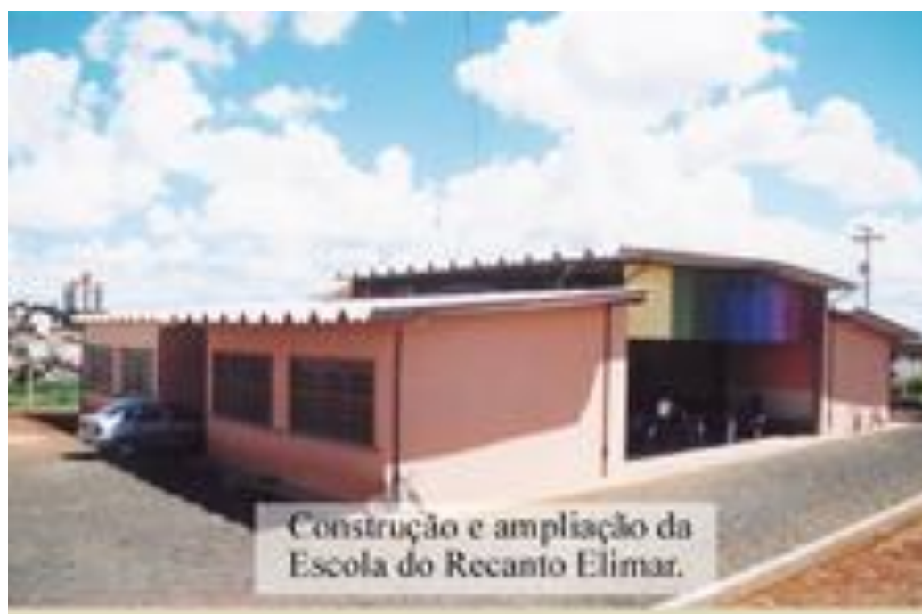
Fotografia 4.14 – Construção e ampliação da Escola Municipal do Recanto Elimar. (ID=11 – Tabela 4.11.A)
