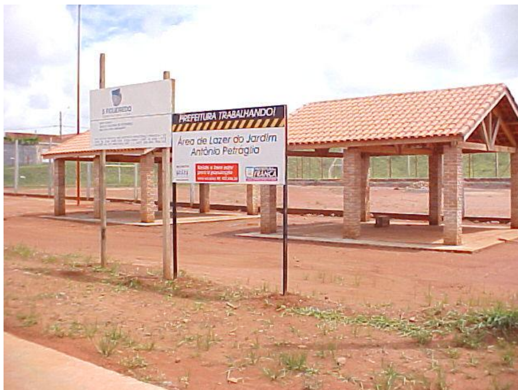
Fotografia 4.5 – Construção de centros esportivos – Jd. Petraglia. (ID=22 – Tabela 4.12.A)
