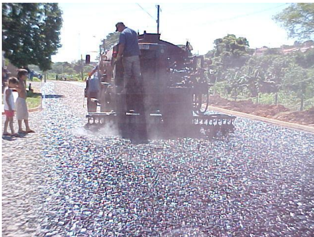
Fotografia 4.4 – Pavimentação do Jardim Luiza. (ID=27 – Tabela 4.12.A)
