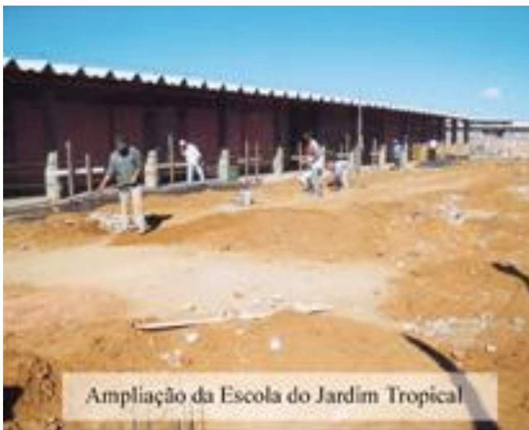
Fotografia 4.16 – Ampliação da Escola do Jd. Tropical. (ID=5 – Tabela 4.11.A)
