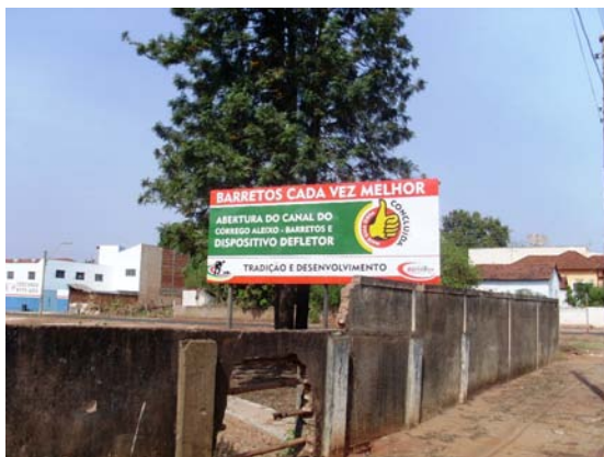
Figura 181 – Ponto de encontro – Córrego do Aleixo e Córrego São Sebastião. (Elaboração e foto: Watanuki Filho, A., Ago, 2008)
