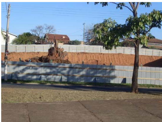
Figura 72 – Área a ser implantado o “Residencial Vista do Lago”
