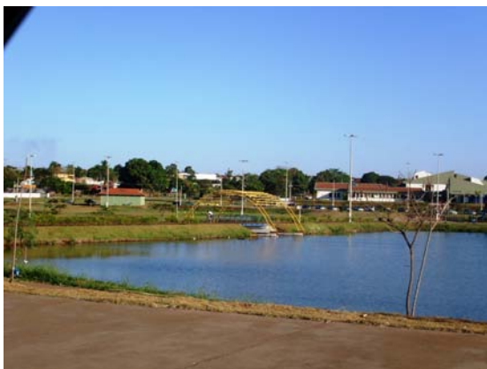
Figura 95 – Vertedouro de controle de vazão (Elaboração e foto: Watanuki Filho, A., Ago, 2008)
