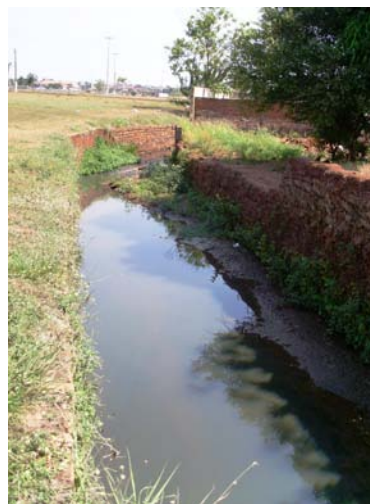
Figura 129 – Assoreamento do corpo d’água. (Elaboração e foto: Watanuki Filho, A., Ago, 2008).
