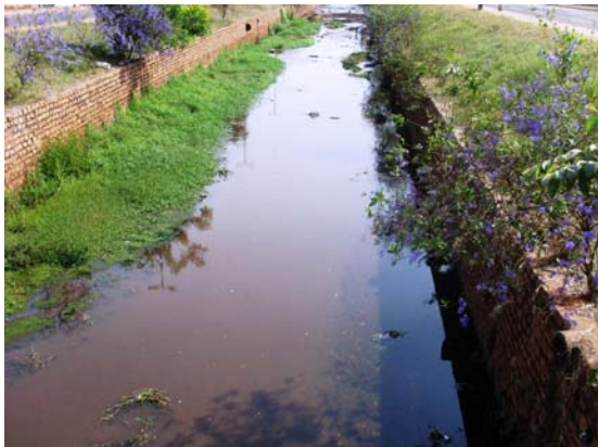
Figura 203 – Calha do córrego alargada e mais profunda (Elaboração: Watanuki Filho, A., Ago, 2008)
