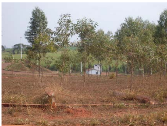
Figura 216 – Vista interna da ETE Neste ponto o corpo d'água que recebe o efluente tratado é o Ribeirão Pitangueiras. (Elaboração: Watanuki Filho, A., Ago, 2008)
