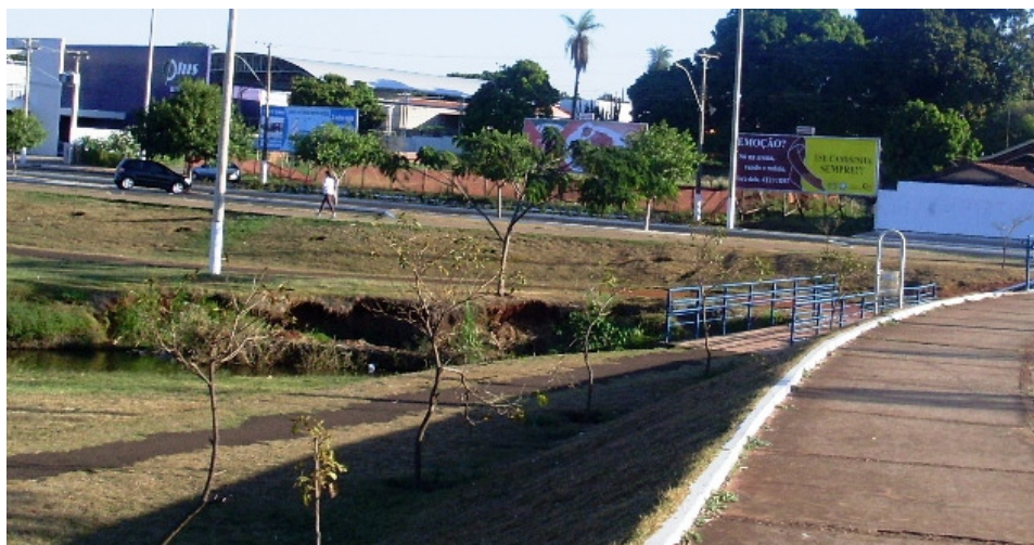
Figura 94 – Processo erosivo das margens da represa. Uma das propostas para tentar conter o processo erosivo das fronteiras foi o plantio de grama, porém tal medida paliativa não alcançou os resultados esperados. (Elaboração e foto: Watanuki Filho, A., Ago, 2008).
