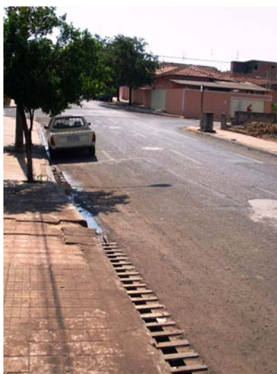
Figura 140 – Rua 28 – detalhe boca de lobo. (Elaboração e foto: Watanuki Filho, A., Ago, 2008).
