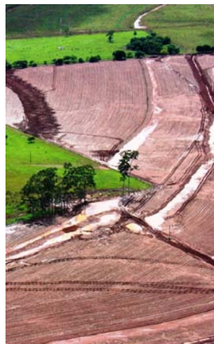
Figura 59 – Detalhe dos estragos ocasionados pela ação da água.
