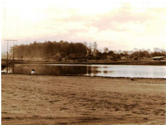
Figura 68 – Primeira represa – Construção das vias de acesso
