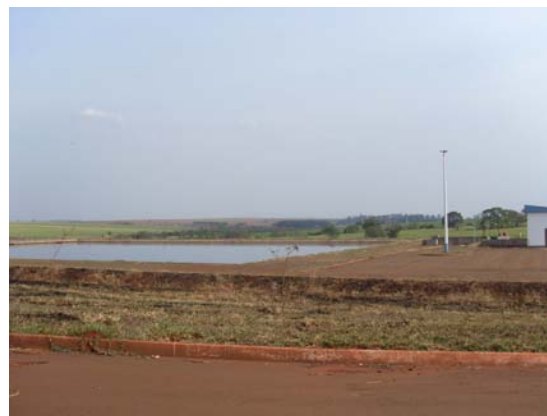
Figura 215 – Lagoas de tratamento da ETE III/SAAE (Elaboração: Watanuki Filho, A., Ago, 2008)
