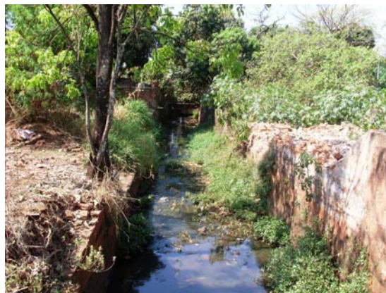
Figura 137 – Córrego atravessando quadra entre as ruas 28 e 26 Trecho onde a proliferação de vegetação como gramíneas no interior do córrego e mamona ( Ricinus Communis L. ), nas fronteiras, além de algumas árvores frutíferas cultivadas pelos moradores. (Elaboração e foto: Watanuki Filho, A., Ago, 2008).
