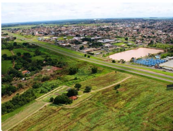
Figura 56 – Encontro do córrego com o meio urbano.
