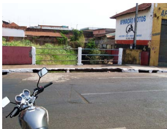
Figura 171 – Rua 18 – Ponte sobre o córrego Uso misto do solo: residências, comércio e ‘vazios’. (Elaboração e foto: Watanuki Filho, A., Ago, 2008)
