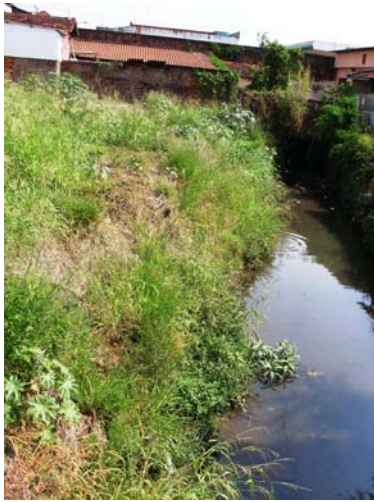
Figura 185 – Vegetação dificulta o fluxo da água do córrego. (Elaboração e foto: Watanuki Filho, A., Ago, 2008)
