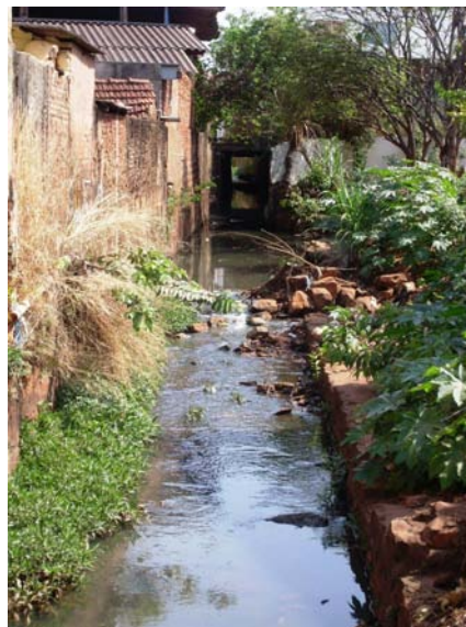
Figura 161 – Vegetação e entulho junto ao corpo d'água. (Elaboração e foto: Watanuki Filho, A., Ago, 2008)
