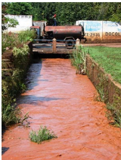
Figura 148 – Rua 30 – situação do córrego após chuva (Elaboração: Watanuki Filho, A., Ago, 2008, Foto: SAAE/Barretos, Fev, 2007)
