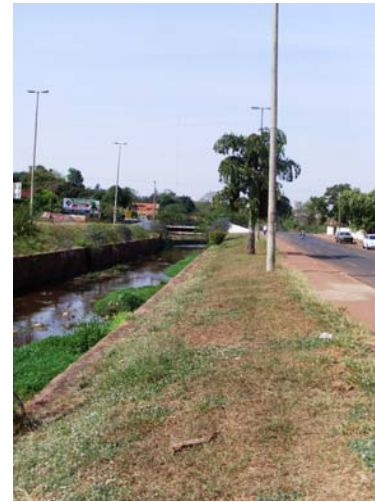
Figura 210 – Trecho com vegetação desenvolvendo dentro da água (Elaboração: Watanuki Filho, A., Ago, 2008)
