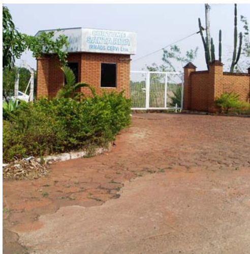
Figura 201 – Entrada do Curtume Santa Rita Córrego passa no interior de seu lote. (Elaboração: Watanuki Filho, A., Ago, 2008)
