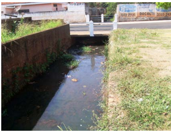
Figura 131 – Retificação intensificada Rua 30 (Elaboração e foto: Watanuki Filho, A., Ago, 2008)
