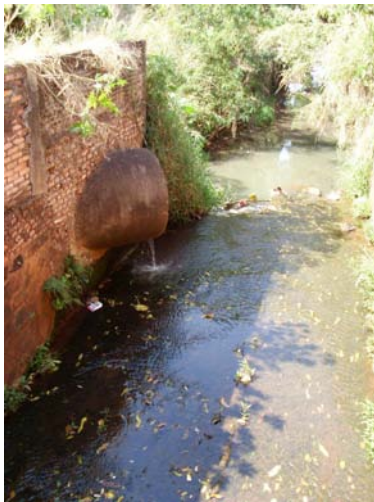
Figura 187 – Sistema de drenagem que deságua no córrego (Rua 26) (Elaboração e foto: Watanuki Filho, A., Ago, 2008)
