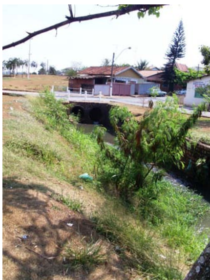
Figura 124 – Início da retificação do canal. (Elaboração e foto: Watanuki Filho, A., Ago, 2008)
