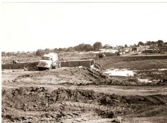
Figura 83 – Obras da segunda represa, trecho Avenida 19.
