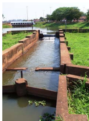
Figura 98 – Canal de captação de água (Elaboração e foto: Watanuki Filho, A., Ago, 2008).
