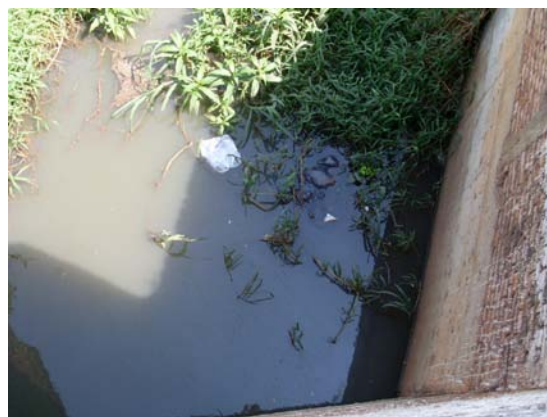
Figura 102 – Situação do corpo d'água – Rua 34. (Elaboração e foto: Watanuki Filho, A., Ago, 2008).
