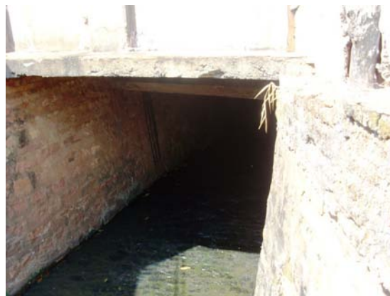
Figura 165 – Entrada da galeria (Rua 20) (Elaboração e foto: Watanuki Filho, A., Ago, 2008)
