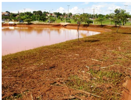
Figura 108 – Nível d'água atingido após chuva.
