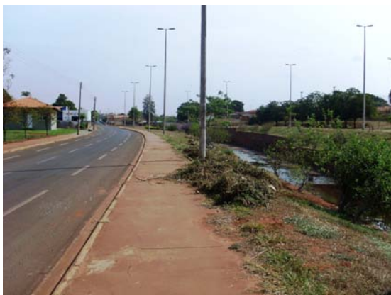
Figura 205 – Córrego modificado para amenizar as enchentes na região. (Elaboração: Watanuki Filho, A., Ago, 2008)
