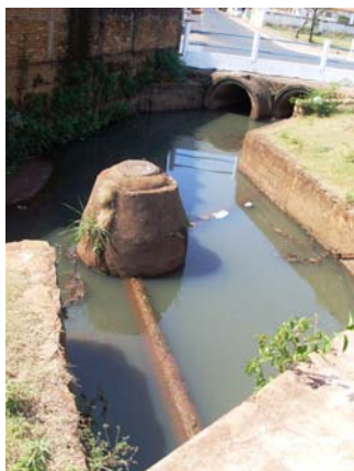
Figura 122 – Poço de visita no interior do corpo d'água (Elaboração e foto: Watanuki Filho, A., Ago, 2008)
