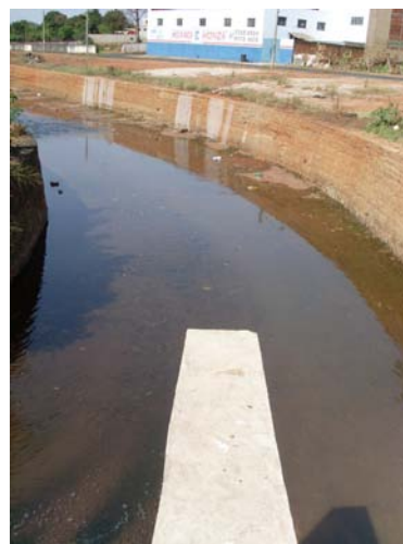
Figura 184 – Confluência dos córregos e formação do Córrego Barretos. (Elaboração e foto: Watanuki Filho, A., Ago, 2008)
