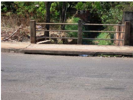
Figura 136 – Ponte sobre córrego Rua 28 Existência de uma residência que está abandonada e se deteriorando com o tempo. (Elaboração e foto: Watanuki Filho, A., Ago, 2008)
