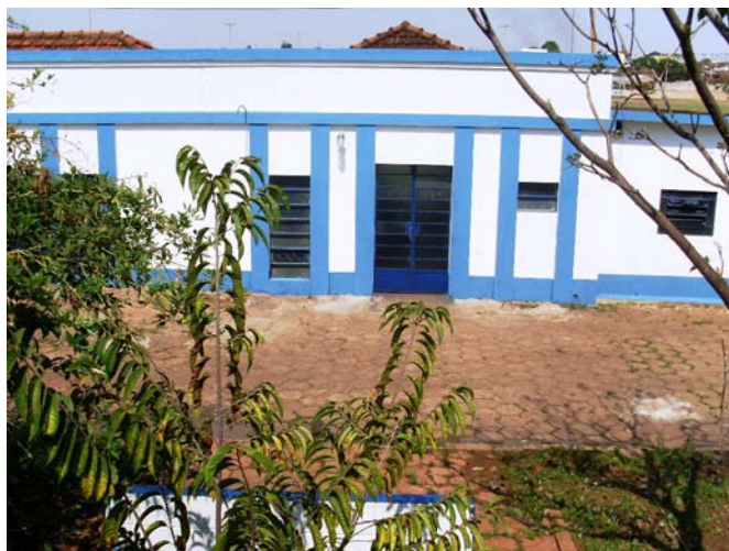
Figura 44 – Captação de água do Córrego do Aleixo (Elaboração e foto: Watanuki Filho, A., Ago, 2008).
