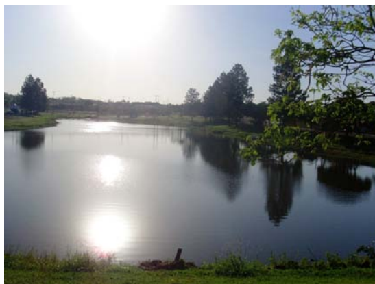
Figura 86 – Represa formada após aprisionamento do córrego.
