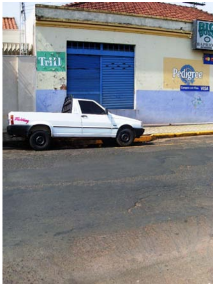
Figura 162 – Estabelecimento comercial (Rua 22) Prédio totalmente construído sobre o córrego. (Elaboração e foto: Watanuki Filho, A., Ago, 2008)
