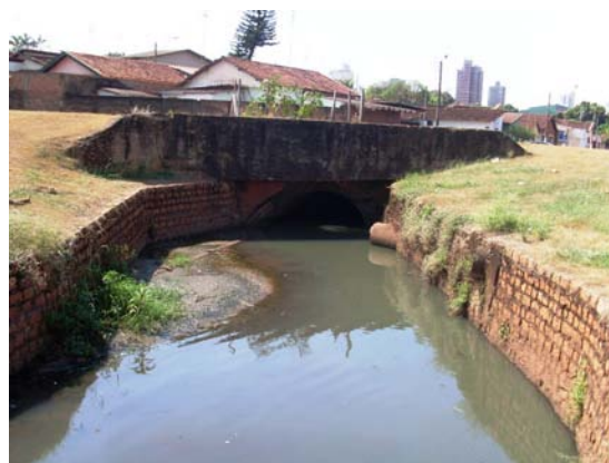
Figura 123 – Início dos trechos tamponados O tamponamento deste trecho ainda é de pequena extensão, mas por estar em área livre porque não deixa-lo livre também. (Elaboração e foto: Watanuki Filho, A., Ago, 2008)
