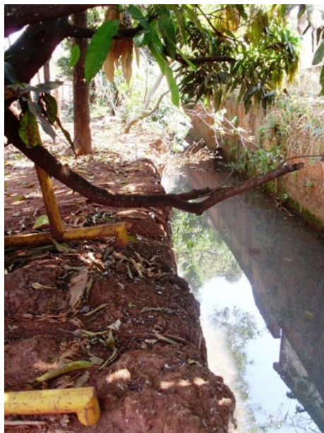
Figura 141 – Córrego dentro de um dos lotes. Fronteiras ocupadas indevidamente, observar vegetação que substitui a original e a coloração da água. (Elaboração e foto: Watanuki Filho, A., Ago, 2008)
