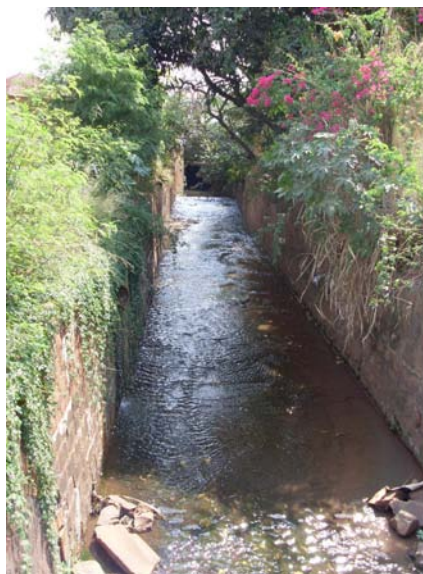
Figura 178 – Retificação do córrego (Av.11) A vegetação impede o acesso a água. (Elaboração e foto: Watanuki Filho, A., Ago, 2008)
