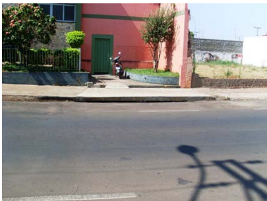
Figura 158 – Sede do CPP sobre o córrego (Rua 24)
