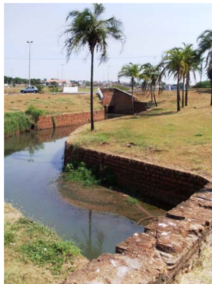
Figura 121 – Córrego do Aleixo – início das canalizações
