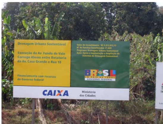
Figura 212 – Início da implantação da Avenida Fundo de Vale Financiado pelo Programa de Drenagem Urbana Sustentável do Governo Federal. (Elaboração: Watanuki Filho, A., Ago, 2008)
