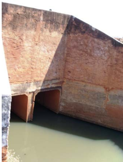
Figura 117 a – Galeria sob a Rua 34
