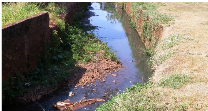
Figura 130 – Entulho no corpo d’água.
