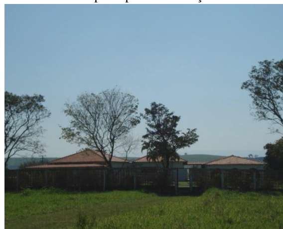
Edificações de diversos padrões.
