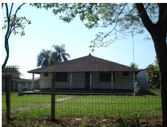
Edificações de diversos padrões.
