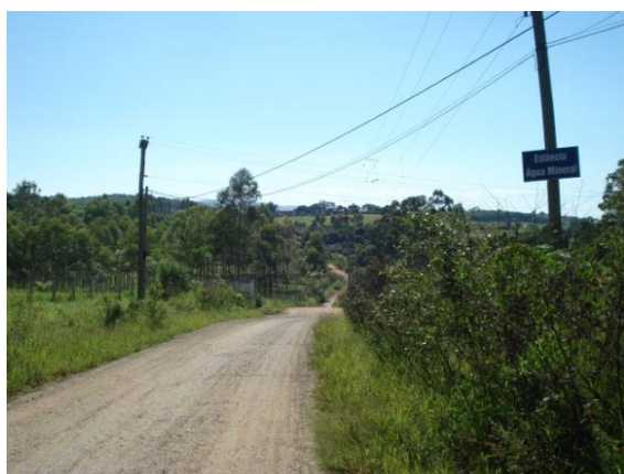
Via principal de acesso, baixa acessibilidade ao bairro.
