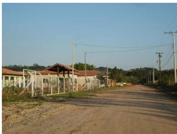
Via principal de circulação, ausência da maioria das infraestruturas urbanas previstas por lei para o parcelamento do solo.
