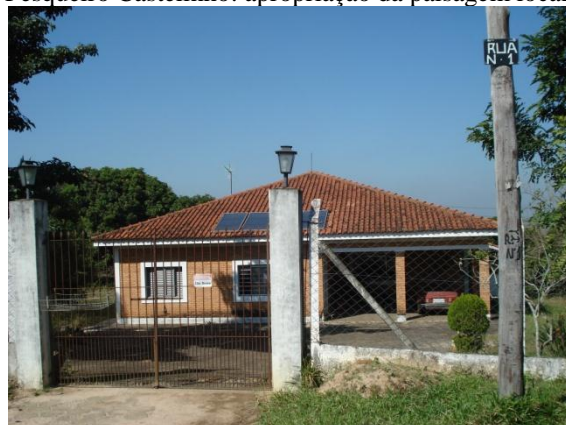
Edificações de diversos padrões.
