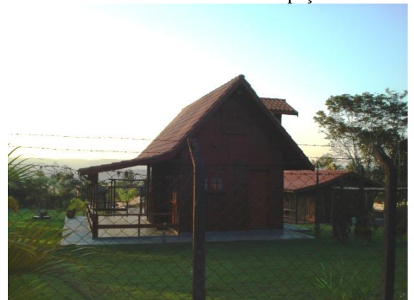
Edificação tipo chalé, usos turísticos.
