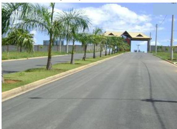
Avenida principal, com à presença de infraestruturas urbanas básicas.
