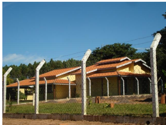
Edificações de diversos padrões.
