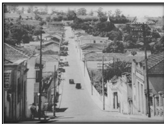
Figura 8. Rua Veríssimo Prado, ao fundo Estação Ferroviária. Fonte: SANTOS, 2009.
