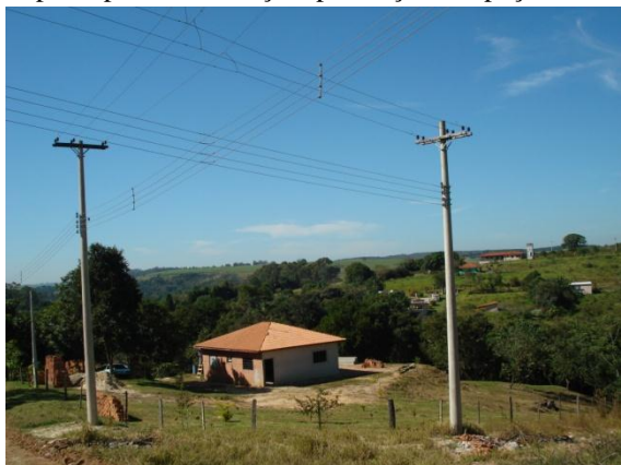
Edificações em construção, inserção da Desconstrução Espacial .
