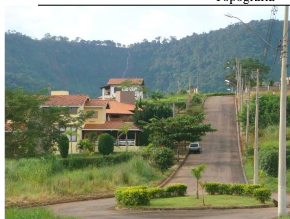
Via principal de circulação não adequada à topografia local.
