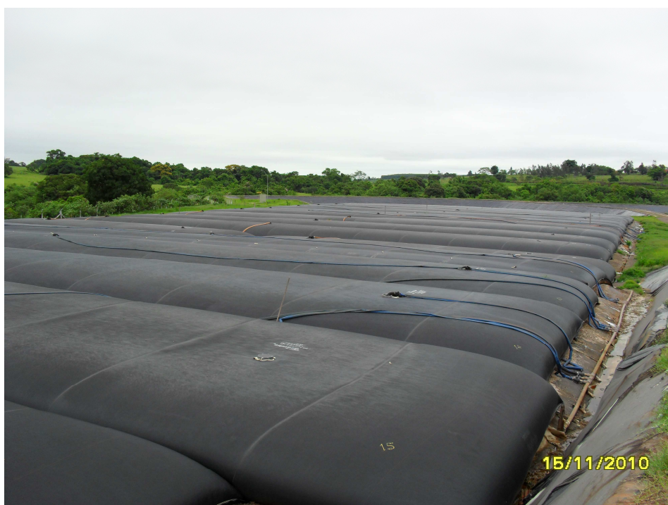
Figura 11 - BAG de manta geotêxtil (Allonda Geotube - ETE-Limoeiro / Presidente Prudente-SP)
