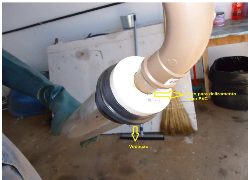
Figura 21 – Vedação e passagem do cano de PVC (SABESP, ETE-Limoeiro / Presidente Prudente-SP)
