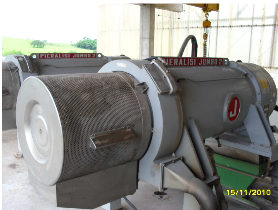
Figura 04 - Centrifuga (Centrifuga Pieralise Jumbo 2 Tipo Decantador, ETE-Limoeiro / Presidente Prudente-SP)
