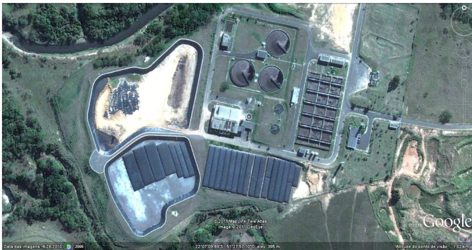
Figura 17 – Vista aérea da ETE Limoeiro
