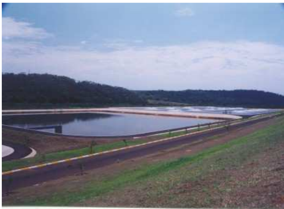
Figura 08 - Lagoa de lodo – ETE Araraquara Fonte: DAAE - Departamento Autônomo de Água e Esgoto de Araraquara
