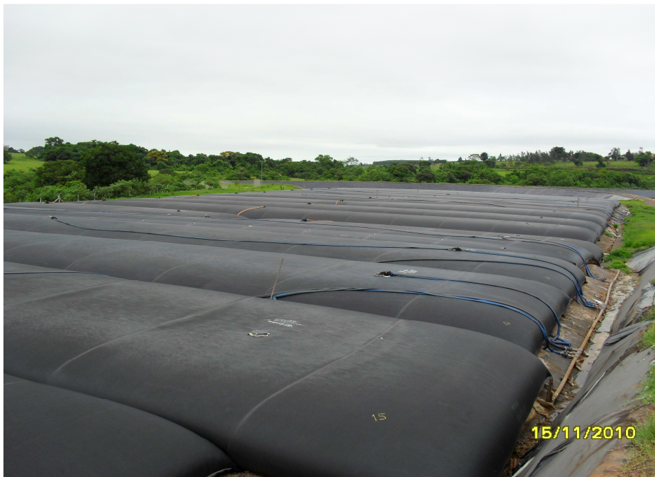
Figura 16 – BAG's de manta geotêxtil – ETE Limoeiro (SABESP, ETE-Limoeiro / Presidente Prudente-SP)
