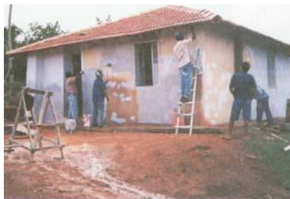
Figura 63: Habitação construída em taipa de pilão. Construções Ecológicas no Brasil.
