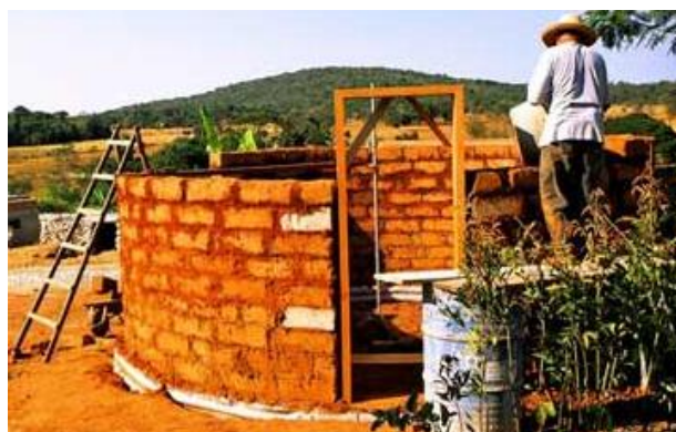
Figura 65: Canteiro de obra, parede curvilínea em terra moldada (tijolos de adobe). Construções Ecológicas no Brasil.
