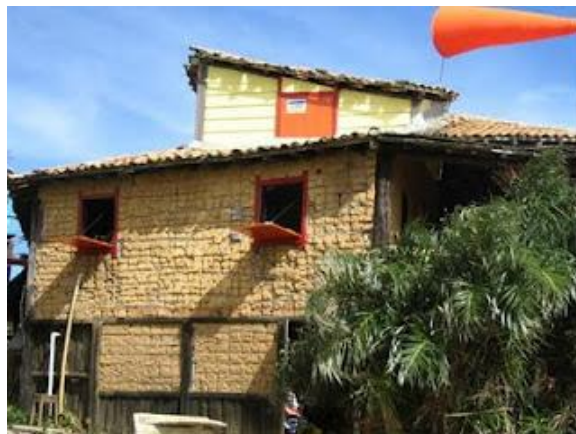
Figura 58: Habitação construída com a técnica de pau a pique . Construções Ecológicas.
