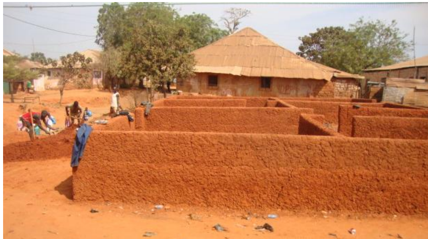
Figura 39: Canteiro de obra. Taipa de mão de 6 cômodos (casa geminada), 2ª fiada pronta (seca).
