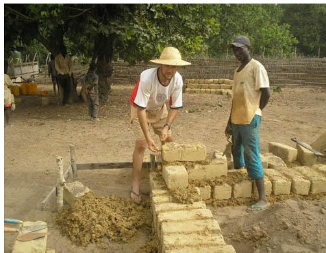
Figura 6: Início da obra com tijolos de adobe, Guiné-Bissau, 2011.
