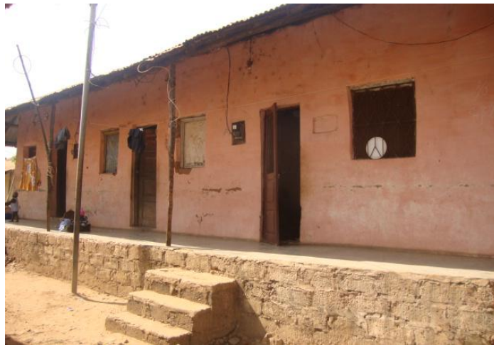
Figura 44: Habitação construída com o sistema misto de “baixa eficácia”.
