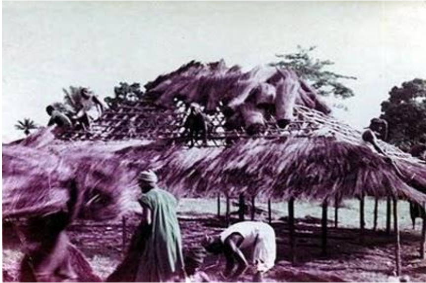
Figura 12: Palhas secas longas e delgadas para cobertura.
