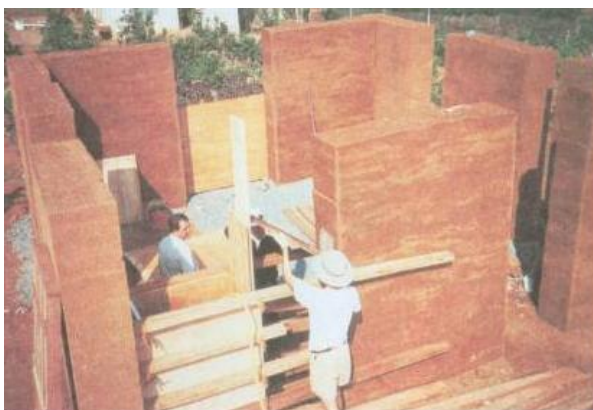
Figura 62: Paredes em taipa de pilão e as aberturas. Construções Ecológicas no Brasil.
