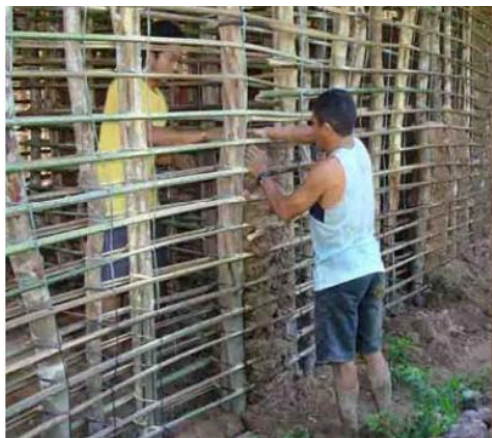
Figura 57: Barramento (preenchimento do entramado) da parede pau a pique .
