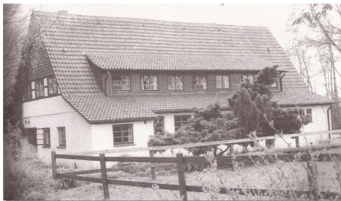
Figura 17: Vivenda com alvenaria de terra crua em Dünner, Alemanha.
