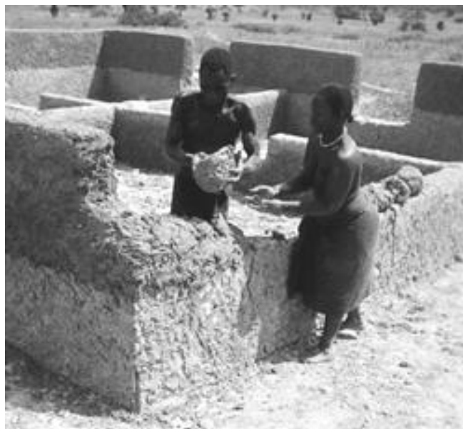
Figura 38: Família modelando as paredes com a terra crua. Guiné-Bissau nos anos 1965-67.
