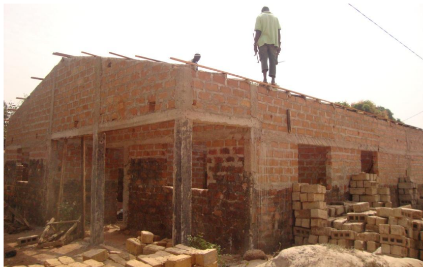
Figura 47: Habitação do sistema misto de “alta eficácia” em construção. Vigas e pilares aprentes.
