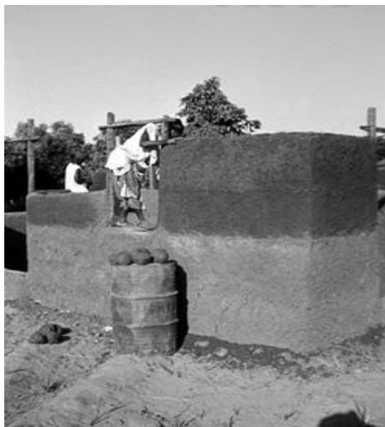
Figura 5: Manipulação das paredes com a terra crua, Guiné-Bissau 1960.
