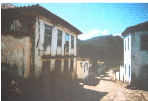
Figura 64: Construção do final do século XVIII, em adobe revestido, com reforços em pedras sabão. Tiradentes – MG/Brasil.
