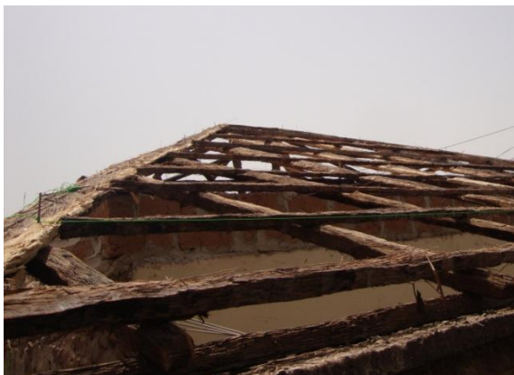
Figura 42: Madeiramento (estrutura da cobertura totalmente construída com barras de cibe ). Cobertura de quatro águas.
