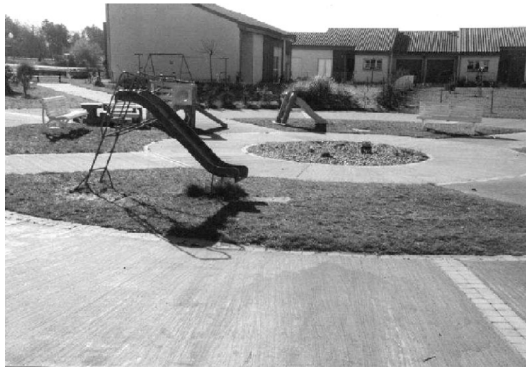
Figura 39: Poço de Infiltração integrado a uma área de lazer infantil (região de Lyon, França). Fonte: Baptista et.al., 2005.
