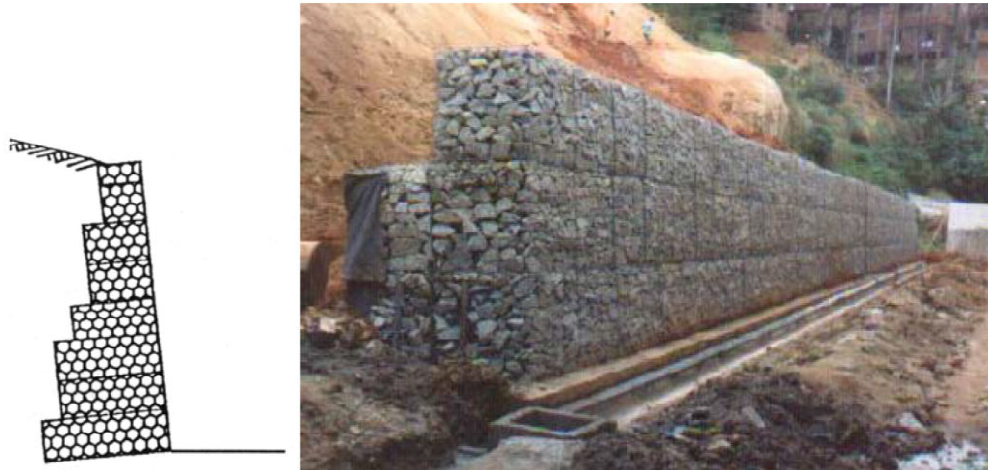
Figura 81: Muro de arrimo de gabião caixa. Fonte: Gerscovitch, 2010.
