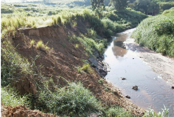
Figura 127: Processos erosivos e escorregamentos na margem fluvial, Campinas-SP. Fonte: Vertical Green, 2008.
