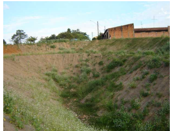
Figura 87: Vegetação em processo de crescimento. Fonte: Silva Leme Engenharia, 2008.
