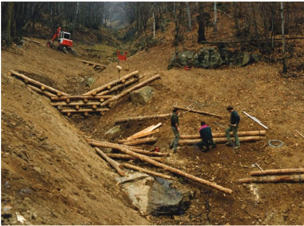
Figura 98: Escada hidráulica de madeira e pedra em fase de implantação - Forno Canavese, Itália. Fonte: Vertical Green, 2010.
