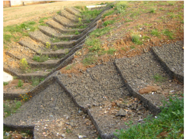
Figura 95: Encontro de duas linhas de escadas hidráulicas. Fonte: Silva Leme Engenharia, 2008.
