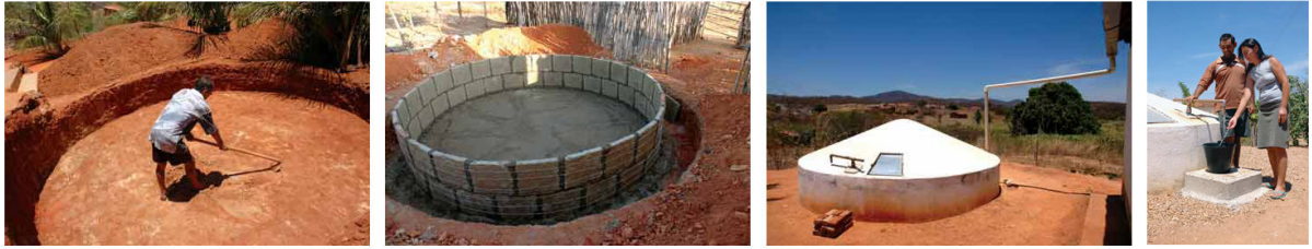
Figura 31: Processo de construção e utilização de uma cisterna do Programa 1 Milhão de Cisternas (P1MC) – ASA Brasil. Fonte: almanaquebrasil.com.br .
