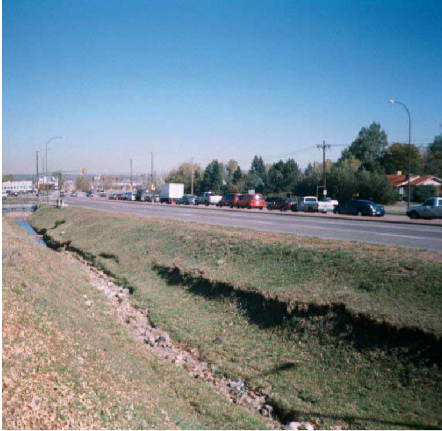
Figura 49: Vala de Infiltração. Fonte: Tucci, 2004
