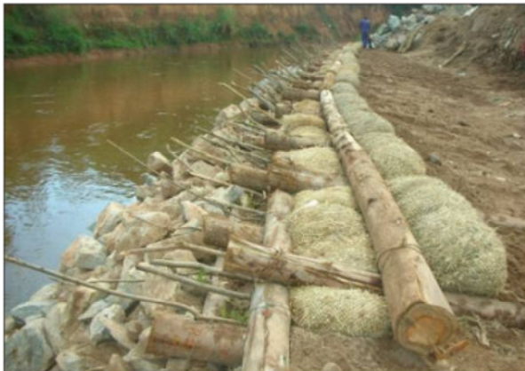
Figura 117: Desenvolvimento da construção da Crib-Wall. Fonte: Deflor, 2007.
