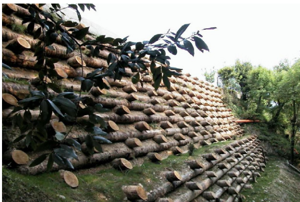
Figura 108: Parede Palificada. Fonte: Vertical Green, 2008.
