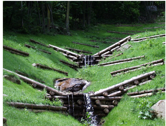
Figura 99: Escada hidráulica de madeira e pedra 60 dias após o término da obra - Forno Canavese, Itália. Fonte: Vertical Green, 2010.
