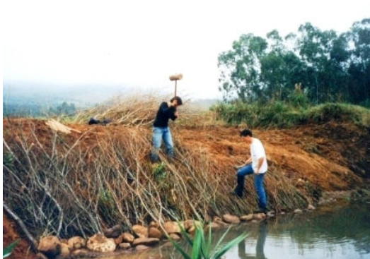
Figura 121: Construção da esteira viva (set/2002). Fonte: Sutuli, 2007.
