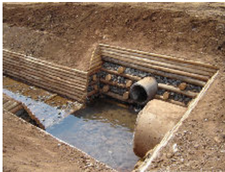
Figura 140: Caixa de dissipação. Fonte: Silva Leme Engenharia, 2006.
