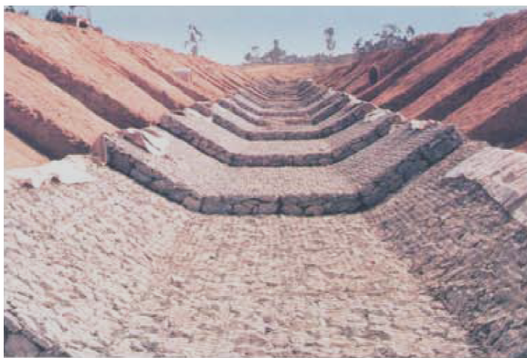
Figura 92: Escada hidráulica de gabião-manta. Fonte: Maccaferri, 2010.
