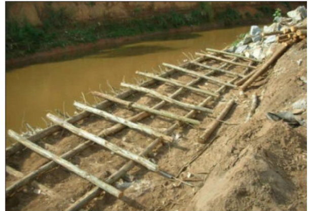
Figura 116: Início da execução da Crib-Wall. Fonte: Deflor, 2007.
