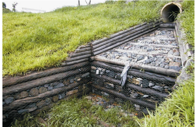
Figura 103: Dissipador de energia de madeira roliça, pedras e tela metálica em Alexânia-GO. Fonte: Vertical Green, 2009.
