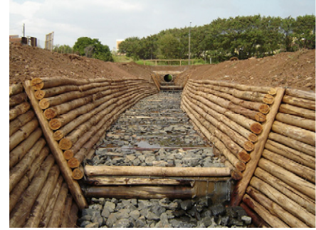
Figura 139: Paredes, fundo e degraus de dissipação. Fonte: Silva Leme Engenharia, 2006.
