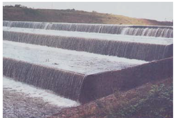
Figura 93: Escada hidráulica de gabião-manta. Fonte: Maccaferri, 2010.
