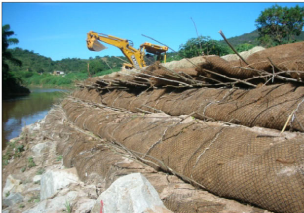
Figura 125: Início da construção do Solo Envelopado Verde, após a aplicação da terceira camada. Fonte: Pereira, 2007.
