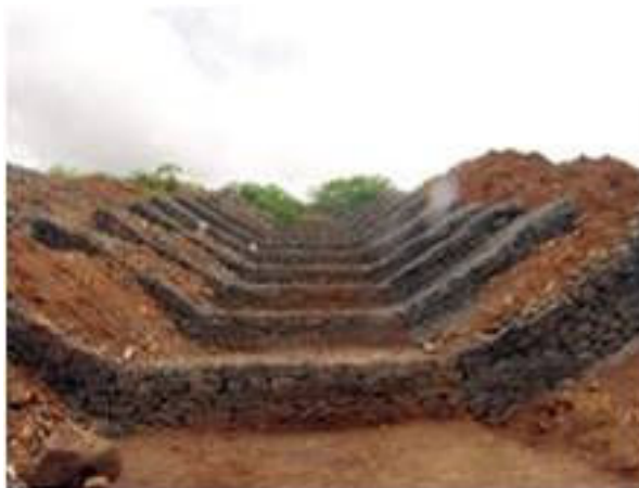
Figura 96: Escada hidráulica de gabião manta recém-concluída. Fonte: Silva Leme Engenharia, 2008.
