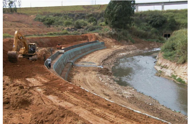
Figura 128: Início da obra, Campinas-SP. Fonte: Vertical Green, 2008.
