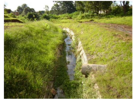
Figura 145: Crescimento vegetal sobre biomanta. Fonte: Silva Leme Engenharia, 2006.
