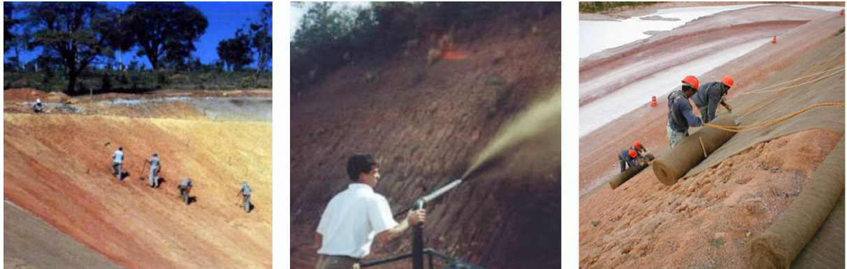
Figura 85: Etapas de obra: microcoveamento, hidrossemeadura e aplicação da biomanta. Fonte: Deflor.
