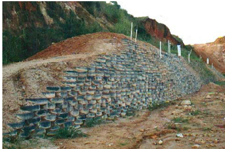
Figura 80: Contenção de encosta com pneus. Fonte: Gerscovitch, s/ data.
