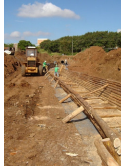
Figura 138: Compactação do solo ao longo do canal. Fonte: Silva Leme Engenharia, 2006.
