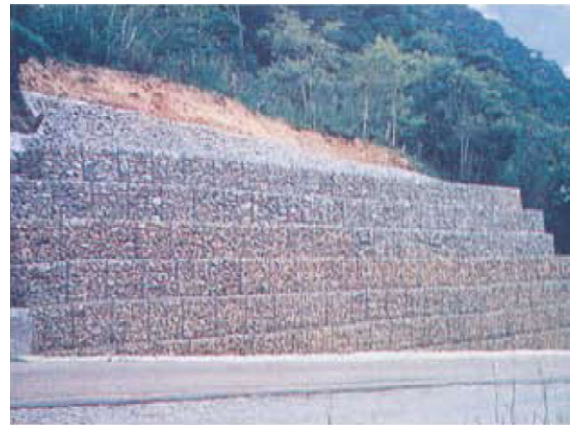
Figura 83: Muro de arrimo de gabião caixa. Fonte: Maccaferri, 2008.
