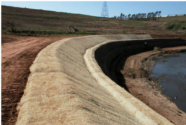
Figura 129: Aplicação de Biomanta Antierosiva, Campinas-SP. Fonte: Vertical Green, 2008.
