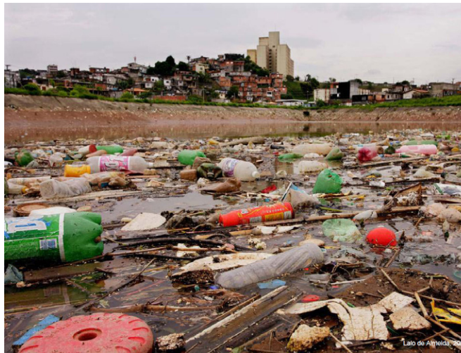
Figura 68: Bacia de detenção impactada pela poluição difusa, São Paulo. Fonte: Almeida, 2007 in Franco, 2008.
