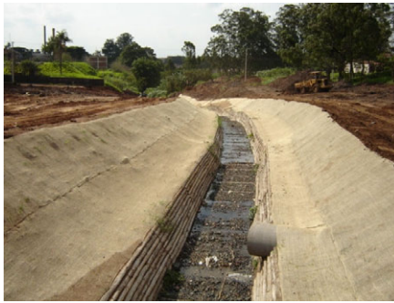
Figura 143: Instalação da biomanta. Fonte: Silva Leme Engenharia, 2006.
