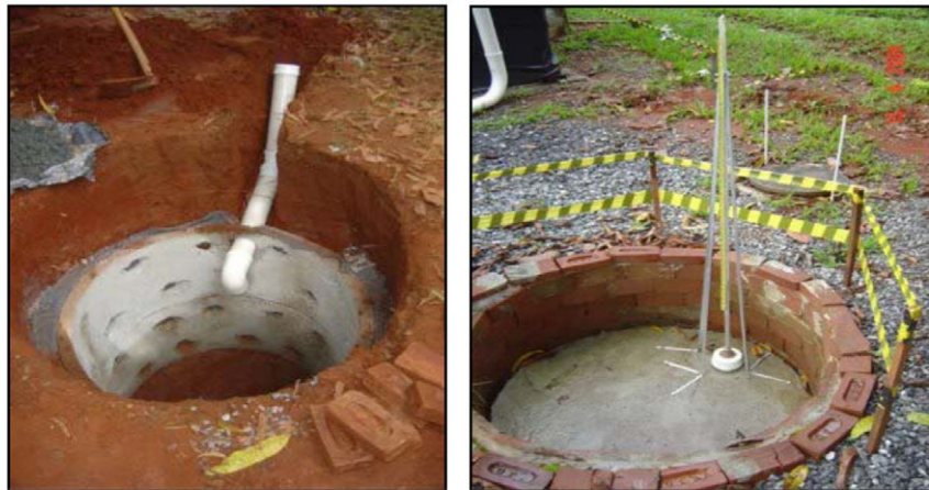
Figura 33: Construção de um Poço de Infiltração de 1,0 m 3 para estudo e análise de desempenho, LSP-EEC-UFG . Fonte: Reis, 2005.
