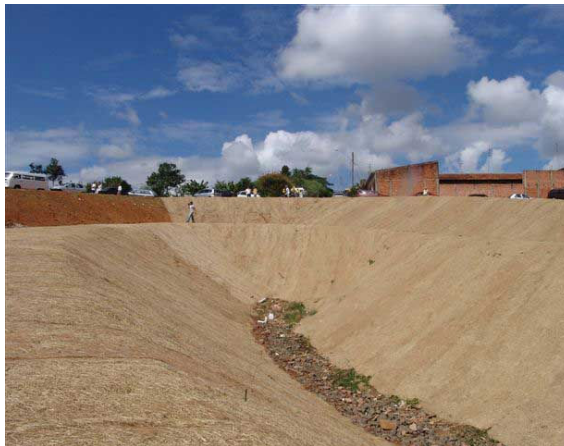
Figura 86: Biomanta recém aplicada. Fonte: Silva Leme Engenharia, 2008.
