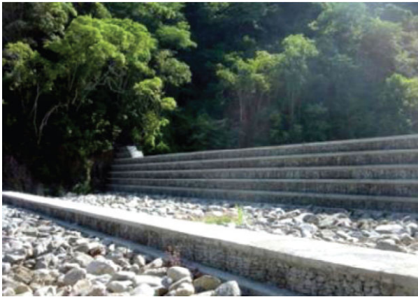
Figura 82: Muro de arrimo de gabião caixa. Fonte: Maccaferri, 2008.
