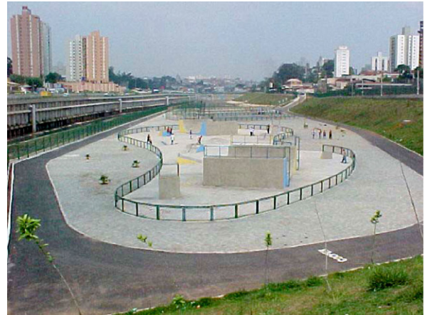
Figura 65: Reservatório de retenção com uso para lazer / playground. Fonte: Tucci, 2004.
