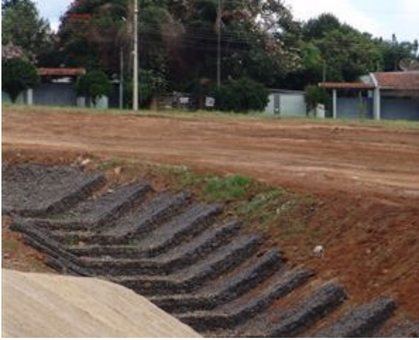
Figura 94: Escada hidráulica de gabião manta. Fonte: Silva Leme Engenharia, 2008.
