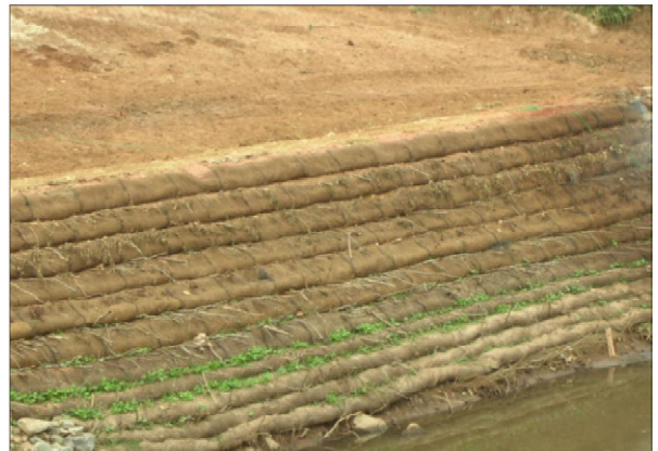
Figura 126: Vista geral do Solo Envelopado Verde após a construção, recuperando totalmente o talude que estava instável e erodido. Fonte: Pereira, 2007.
