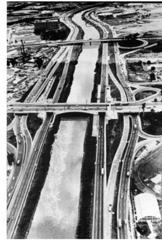
Figura 5: Marginais do rio Tietê, na época de sua construção, junto à Ponte das Bandeiras, 1942. Fonte: Agência Estado, 2008.
