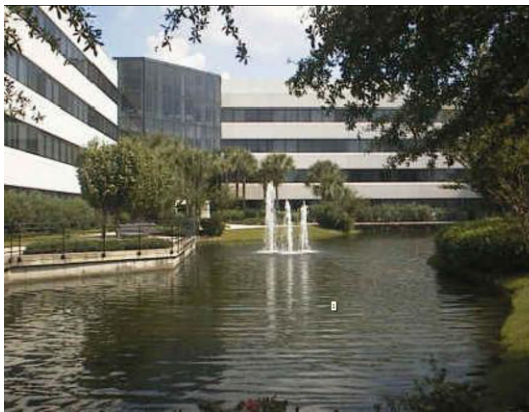
Figura 61: Reservatórios de retenção. Fonte: Amanthea, 2008.
