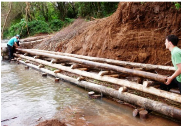
Figura 111: Construção da parede-Krainer dupla (set/2005). Fonte: Sutili, 2007.
