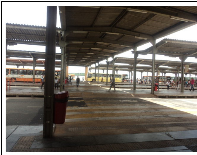
Figura 8 - Área interna do terminal Praia Grande Fonte: autor, 2011.
