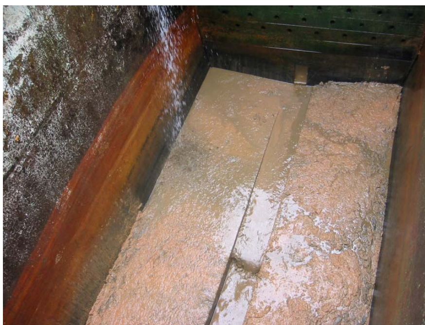
FIGURA 6.17 Descarga da camada de lodo e limpeza final do decantador
