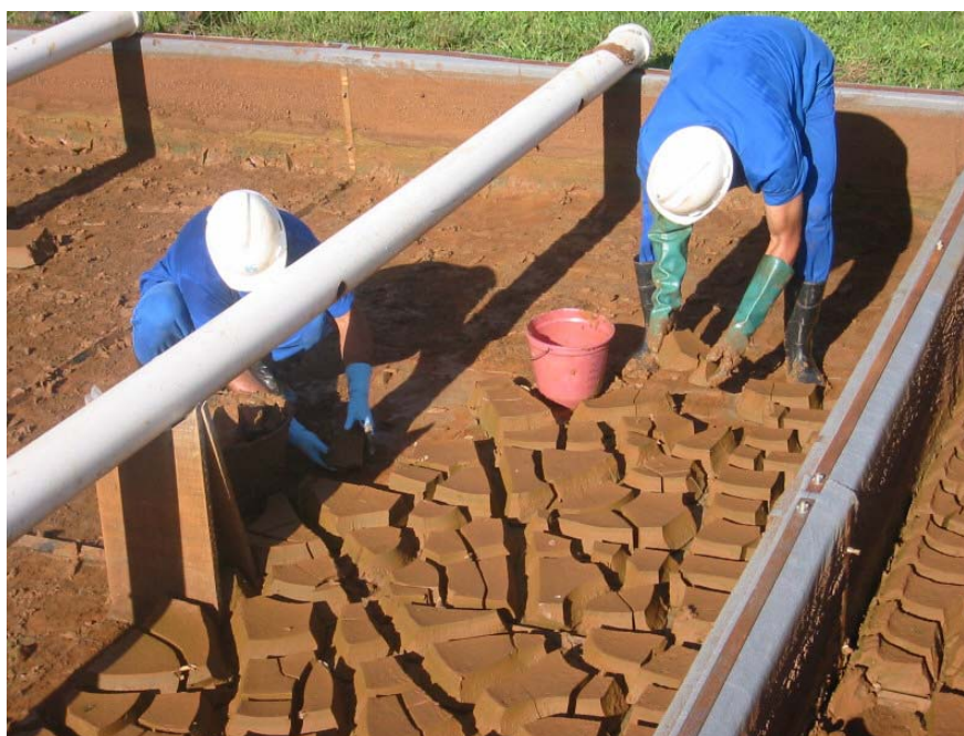
FIGURA 6.22 Operação de retirada manual dos sólidos do Leito de Drenagem
