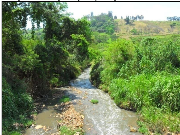
Figura 29 – Córrego com presença de algumas árvores na APP
