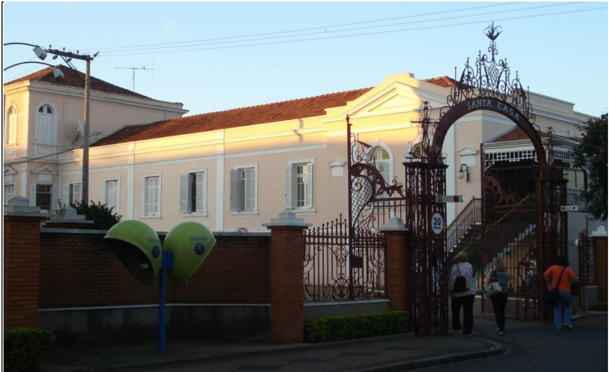
Figura 7 – Hospital Santa Casa Saúde de Rio Claro
