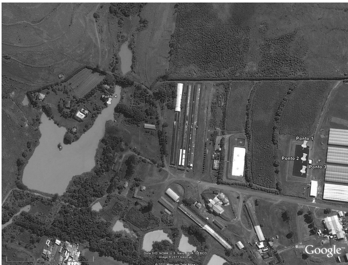
Imagem 1: Vista Geral do reservatório, dos telhados de captação e dos pontos de coleta. Fonte: Google Earth (2011).
