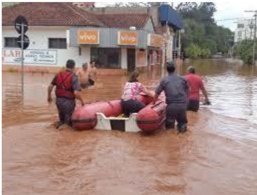
Figura - Anexo. 3 - Transbordamento do rio na rua Quintino Bocaiúva Fonte: Defesa Civil de Jahu
