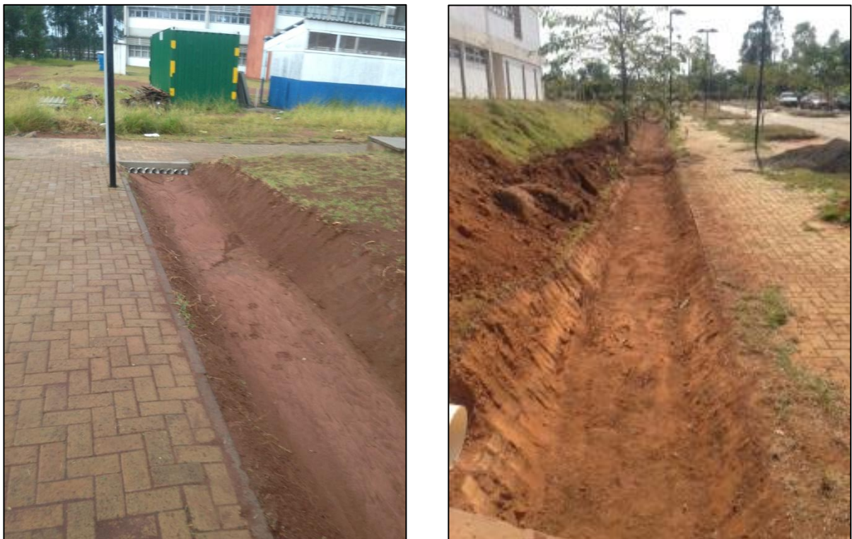
Figura 23 – Corte do terreno nas dimensões de projeto.
