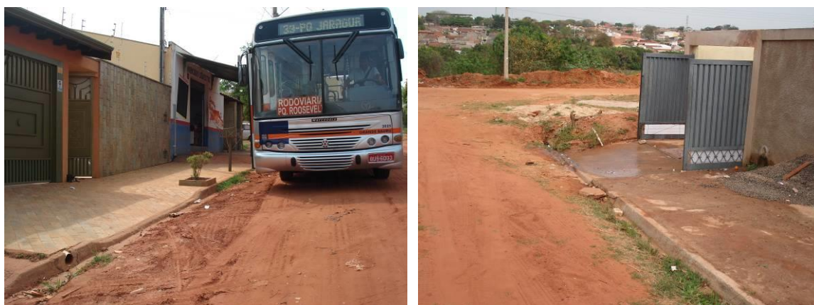
FOTOS B.3.8. e B.3.9. A acessibilidade não é garantida na execução dos passeios. O sistema viário implantado segue, na maioria das vias, transversal às curvas de níveis do terreno, o que propicia grandes inclinações. Este fator prejudica as obras de drenagem e não favorece modos de transportes não motorizados (foto do autor).
