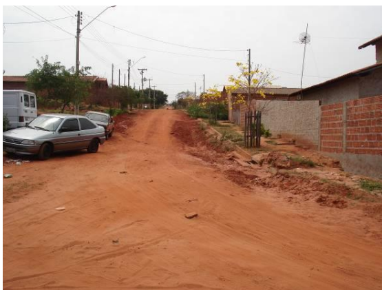
FOTOS B.3.27. e B.3.28. Guias e sarjetas cobertas com terra proveniente de assoreamento e manutenção das ruas não pavimentadas. Pode-se observar que a sarjeta se encontra acima do greide da rua, o que inviabiliza o escoamento das águas pluviais e de lavagem das residências (foto do autor).
