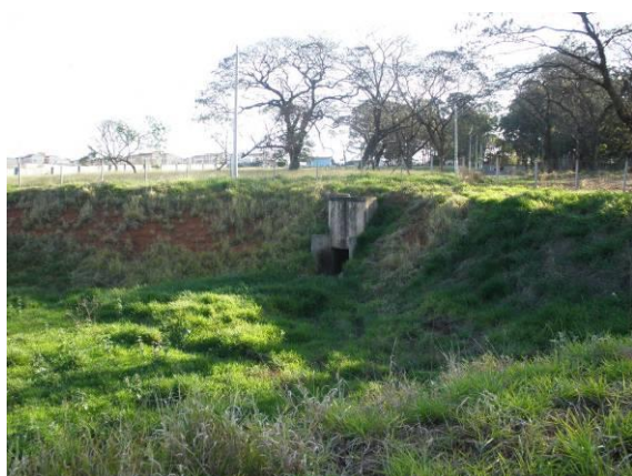
FOTOS B.1.41., B.1.42., B.1.43. B.1.44., B.1.45. e B.1.46. Área verde externa do empreendimento utilizada como bacia de retenção do sistema de drenagem urbana (foto do autor).
