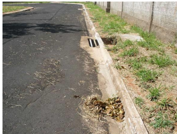
FOTOS B.1.61. e B.1.62. Bocas de lobo necessitando de limpeza e manutenção no Residencial Quinta Ranieri Blue (foto do autor).
