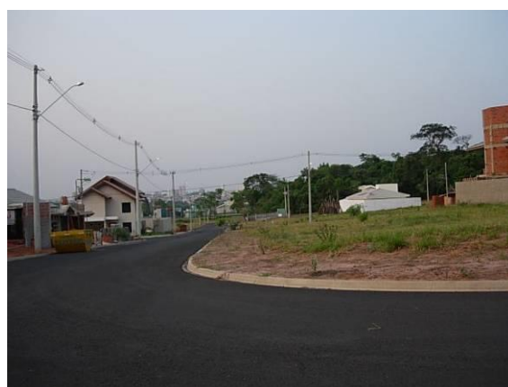
FOTOS B.5.91., B.5.92., B.5.93. e B.5.94. Sistema viário implantado no loteamento. Observa-se a inclinação das ruas, raios e passeios ainda não pavimentados (fotos do autor).
