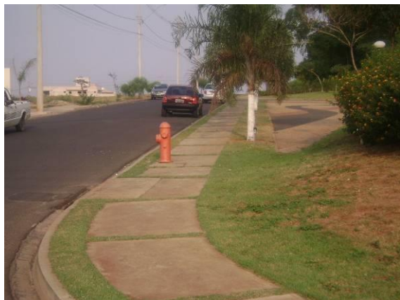
FOTO B.5.61.e B.5.62. Rede de hidrante de passeio solicitados pelo DAE e executados pelo empreendedor, na rede de distribuição de água (foto do autor).
