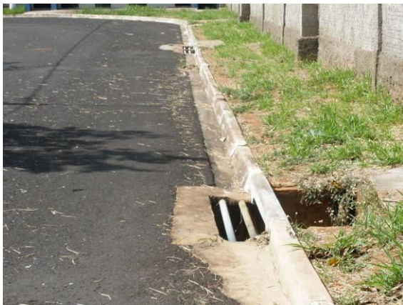
FOTOS B.1.61. e B.1.62. Bocas de lobo necessitando de limpeza e manutenção no Residencial Quinta Ranieri Blue (foto do autor).
