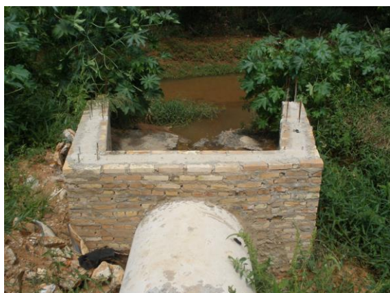
FOTOS B.7.64. e B.7.65. Dissipador de energia localizado às margens do Córrego da Ressaca. Observa-se que trata-se de obra nova, executada recentemente (foto do autor).
