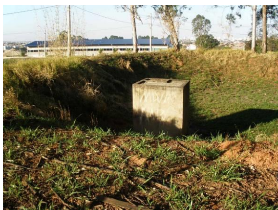
FOTOS B.1.54. e B.1.55. Bacia de retenção de águas pluviais executada na área verde, junto ao bosque de eucaliptos (foto do autor).
