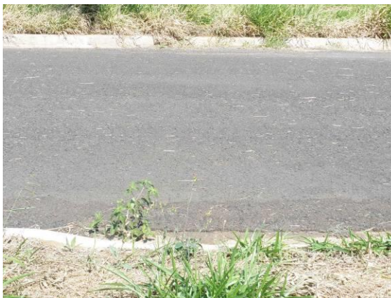
FOTOS B.1.21., B.1.22. e B.2.23. Instalação no passeio das rampas de acessibilidade. Não há continuidade do outro lado da rua. Também, não há pavimentação dos passeios (foto do autor).
