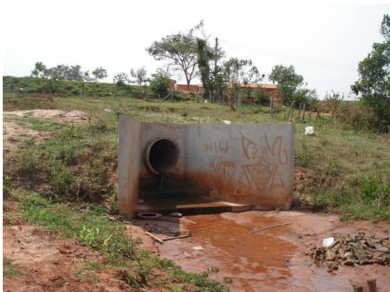
FOTOS B.4.20. e B.4.21. Obra da saída do dissipador de energia executado. Não foram executadas as demais obras de dissipação de energia que devem levar a água pluvial até o córrego (foto do autor).
