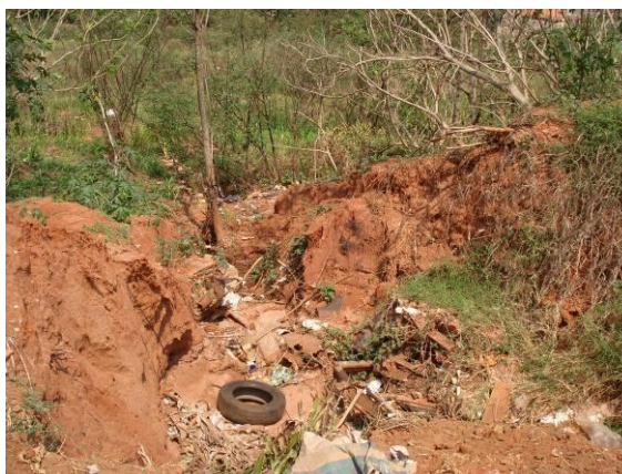
FOTOS B.3.31., B.3.32. e B.3.33. Erosão causada na área verde e APP devido a água não captada pela galeria de águas pluviais através das guias e sarjetas e bocas de lobo. Nota-se também a presença de lixo e entulho jogado no local pela população (foto do autor).
