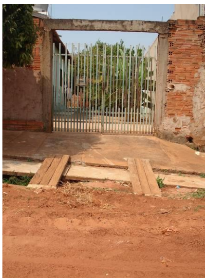
FOTOS B.3.25. e B.3.26. Acesso à edificação fica comprometido pela erosão ao lado da guia (foto do autor).
