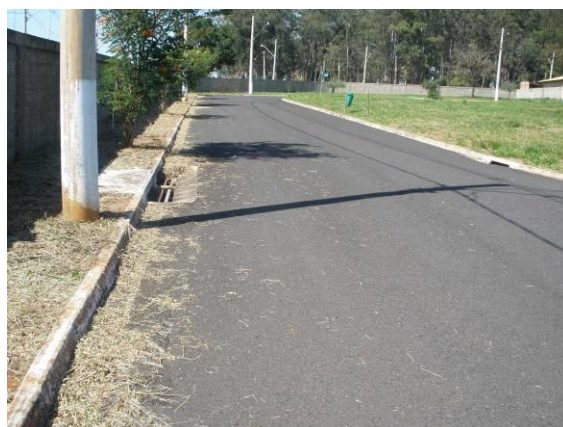
FOTOS B.1.63., B.1.64., B.1.65. B.1.66., B.1.67. e B.1.68. Bocas de lobo necessitando de limpeza e manutenção no Residencial Quinta Ranieri Green (foto do autor).
