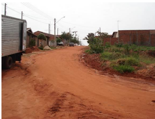
FOTOS B.3.27. e B.3.28. Guias e sarjetas cobertas com terra proveniente de assoreamento e manutenção das ruas não pavimentadas. Pode-se observar que a sarjeta se encontra acima do greide da rua, o que inviabiliza o escoamento das águas pluviais e de lavagem das residências (foto do autor).
