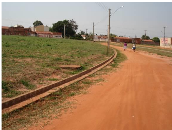
FOTO B.3.7. O arruamento está executado com guias e sarjetas e passeios sem pavimentação. Verifica-se que no Jardim Silvestri II ainda não foi executada esta obra de infra-estrutura (foto do autor).
