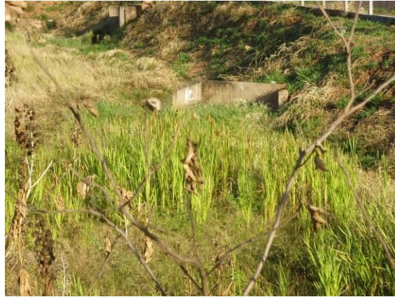
FOTOS B.1.57., B.1.58., B.1.59. e B.1.60. Bacia de retenção de águas pluviais ligado a rede de galeria do Loteamento Quinta Ranieri, executado em área comercial do empreendedor, doada ao Município para compensação de área impermeabilizada (foto do autor).
