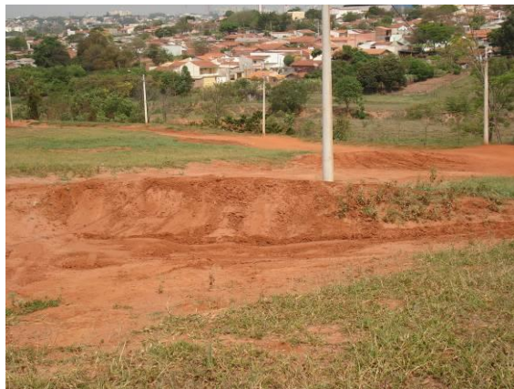
FOTO B.4.32. Obras provisórias para contenção de águas pluviais durante a execução das obras do SDU (foto do autor).
