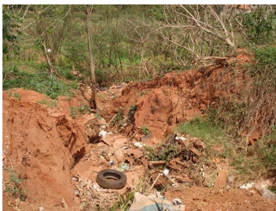
FOTO B.4.31. Jardim Silvestri. Erosão causada na área verde, devido ao escoamento das águas pluviais. A população contribui com a degradação jogando lixo (foto do autor).
