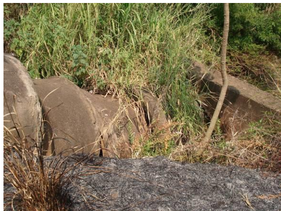
FOTOS B.3.21. e B.3.22. A tubulação de concreto do sistema de drenagem urbana que leva a água até o dissipador esta rompida (foto do autor).
