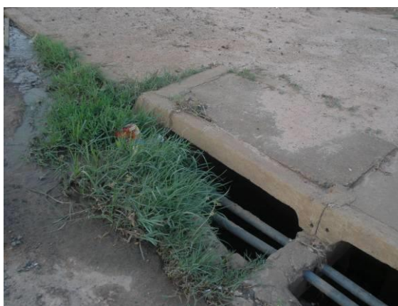
FOTOS B.2.10., B.2.11. e B.2.12. Obras de drenagem executadas no empreendimento. Dissipador, caixas de passagem e boca de lobo implantadas no local (foto do autor).
