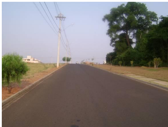
FOTOS B.5.30., B.5.31. B.5.32., B.5.33. e B.5.34. Ruas implantadas no loteamento. As ruas não seguiram regras para sua implantação quanto ao posicionamento das curvas de níveis (fotos do autor).
