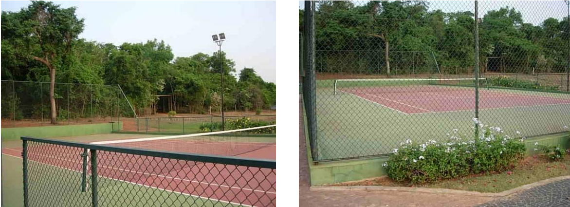
FOTOS B.5.111., B.5.112., B.5.113., B.5.114., B.5.115., B.5.116., B.5.117 e B.5.118. Área verde impermeabilizada no Residencial Loteamento Residencial Villaggio III (foto do autor).
