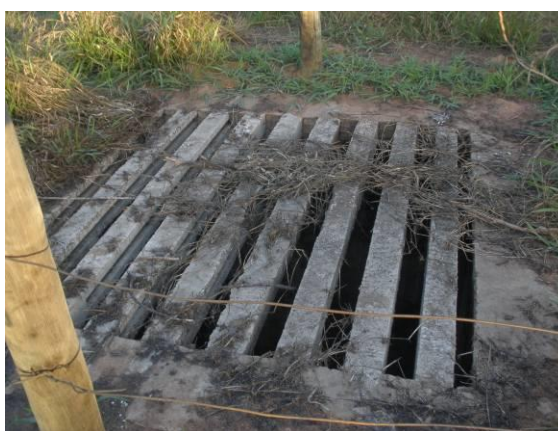
FOTOS B.2.8. e B.2.9. Obras de drenagem para controle da erosão na região do empreendimento (foto do autor).
