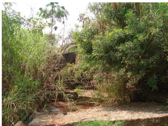
FOTOS B.3.23. e B.3.24. Dissipador de energia do SDU completamente destruído (foto do autor).
