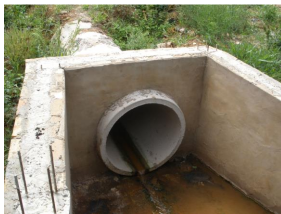
FOTOS B.7.64. e B.7.65. Dissipador de energia localizado às margens do Córrego da Ressaca. Observa-se que trata-se de obra nova, executada recentemente (foto do autor).
