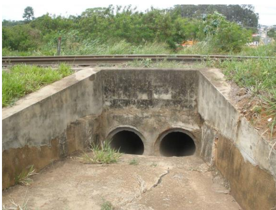
FOTOS B.7.73. Passagem da rede de galerias sob os trilhos da ferrovia (foto do autor).
