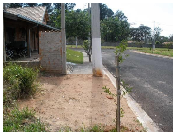
FOTOS B.1.24. e B.2.25. Passeios executados pelos proprietários dos lotes com inclinação excessiva e colocação posteamento, dificultando a passagem de pedestres (foto do autor).
