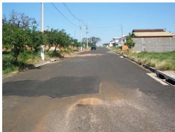
FOTOS B.1.83., B.1.84. B.1.85., B.1.86., B.1.87., B.1.88., B.1.89. e B.1.90. Pavimentação do empreendimento apresentado diversos problemas de execução e com manutenção nas porções internas executadas pelo empreendedor (foto do autor).
