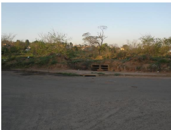
FOTO B.2.35. Dispositivo para captação de águas pluviais para correção de processo erosivo (foto do autor).
