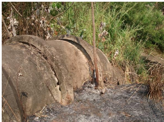
FOTOS B.3.21. e B.3.22. A tubulação de concreto do sistema de drenagem urbana que leva a água até o dissipador esta rompida (foto do autor).
