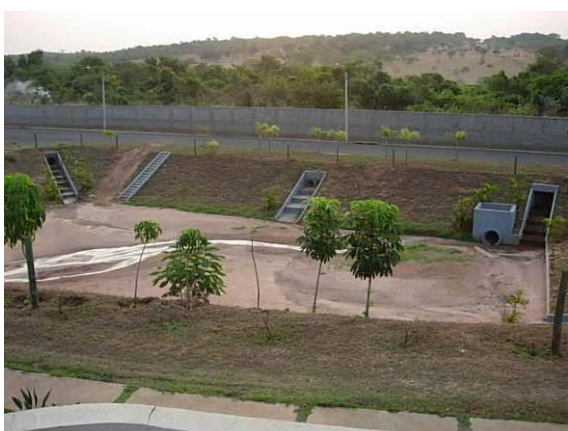
FOTO B.5.129., B.5.130., B.5.131., B.5.132., B.5.133., B.5.134., B.5.135. e B.5.136. Bacia de Retenção executada no Residencial Villaggio III, com captação de águas pluviais do Residencial Villaggio II (foto do autor).
