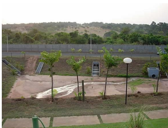
FOTO B.5.129., B.5.130., B.5.131., B.5.132., B.5.133., B.5.134., B.5.135. e B.5.136. Bacia de Retenção executada no Residencial Villaggio III, com captação de águas pluviais do Residencial Villaggio II (foto do autor).
