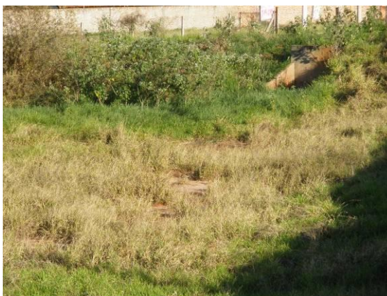
FOTO B.1.78. Dissipador de uma das bacias de retenção (foto do autor).
