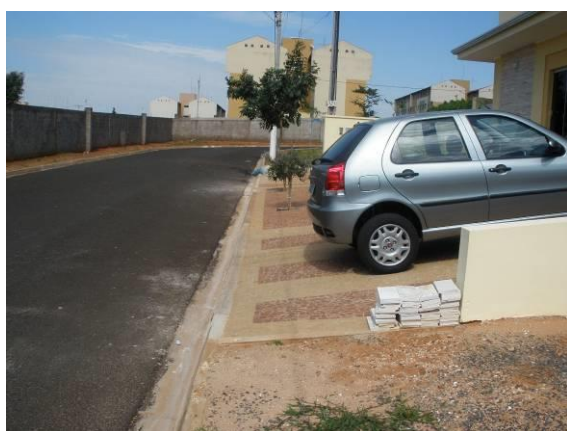
FOTOS B.1.24. e B.2.25. Passeios executados pelos proprietários dos lotes com inclinação excessiva e colocação posteamento, dificultando a passagem de pedestres (foto do autor).
