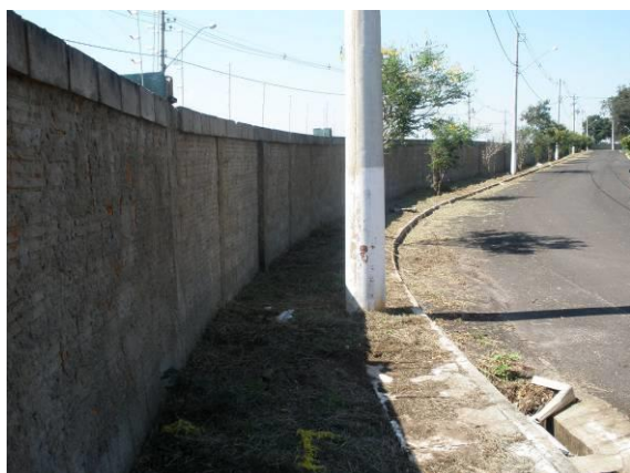
FOTOS B.1.63., B.1.64., B.1.65. B.1.66., B.1.67. e B.1.68. Bocas de lobo necessitando de limpeza e manutenção no Residencial Quinta Ranieri Green (foto do autor).
