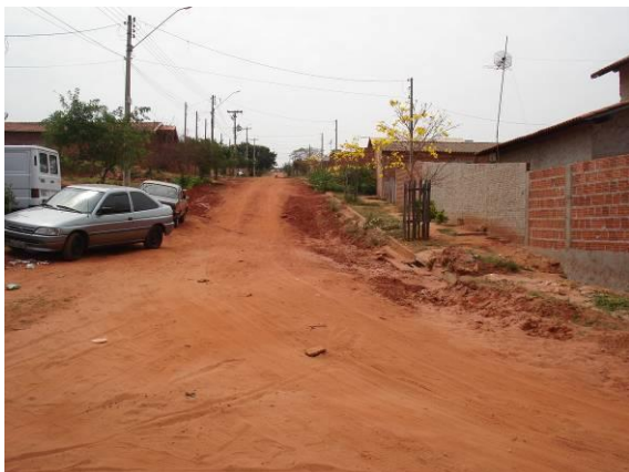
FOTOS B.4.25. e B.4.26. Jardim Silvestri. As guias e sarjetas estão acima do greide da rua e as bocas de lobo não captam as águas pluviais (foto do autor).
