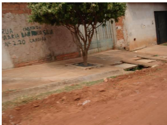
FOTOS B.3.25. e B.3.26. Acesso à edificação fica comprometido pela erosão ao lado da guia (foto do autor).
