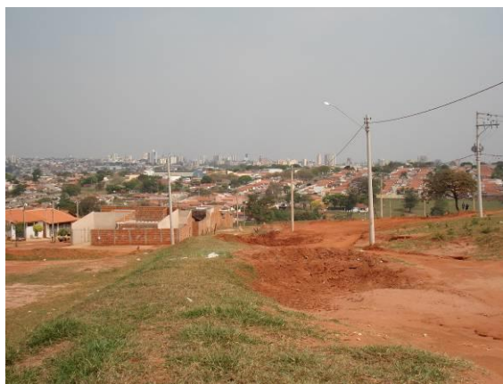
FOTO B.4.33. Sistema de iluminação pública. As obras de guias e sarjetas não foram iniciadas (foto do autor).
