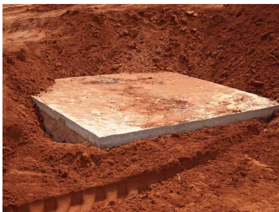
FOTOS B.4.29. e B.4.30. Obras do SDU – caixas de centro sendo executadas pelo empreendedor (foto do autor).
