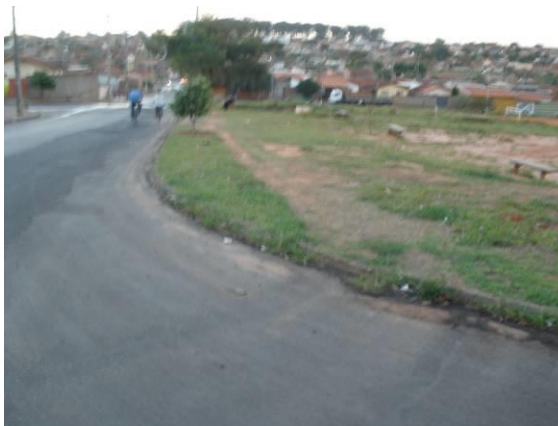
FOTO B.2.16. Área Institucional do empreendimento. Não há execução de passeio, sistemas de acessibilidade e equipamentos institucionais destinados à população. (foto do autor).
