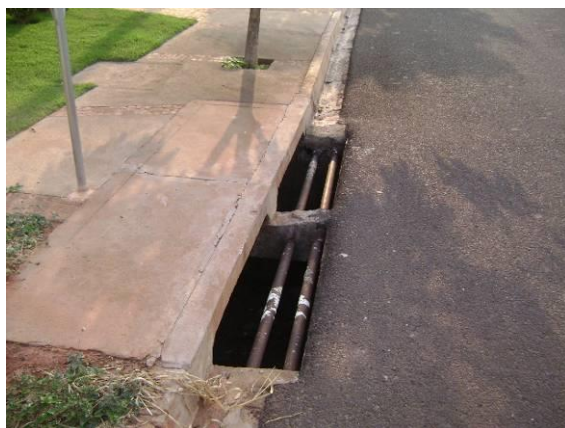
FOTOS B.5.63., B.5.64., B.5.65., B.5.66., B.5.67., B.5.68., B.5.69., B.5.70., B.5.71. B.5.72., B.5.73., B.5.74. e B.5.75. Bocas de lobo do loteamento Residencial Villaggio II (foto do autor).
