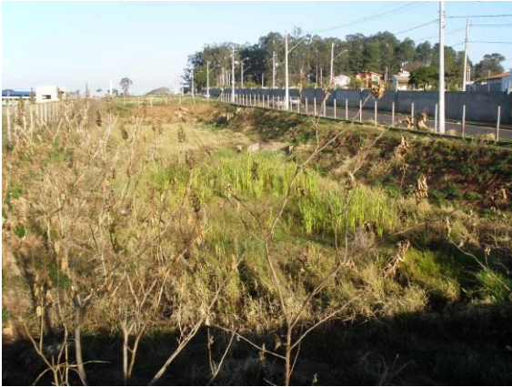
FOTOS B.1.57., B.1.58., B.1.59. e B.1.60. Bacia de retenção de águas pluviais ligado a rede de galeria do Loteamento Quinta Ranieri, executado em área comercial do empreendedor, doada ao Município para compensação de área impermeabilizada (foto do autor).
