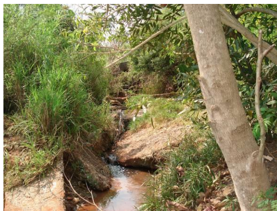
FOTOS B.3.23. e B.3.24. Dissipador de energia do SDU completamente destruído (foto do autor).
