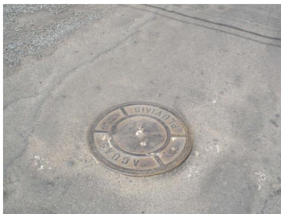
FOTOS B.7.63. Tampa de caixa de centro das galerias de águas pluviais (foto do autor).
