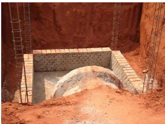
FOTOS B.4.29. e B.4.30. Obras do SDU – caixas de centro sendo executadas pelo empreendedor (foto do autor).
