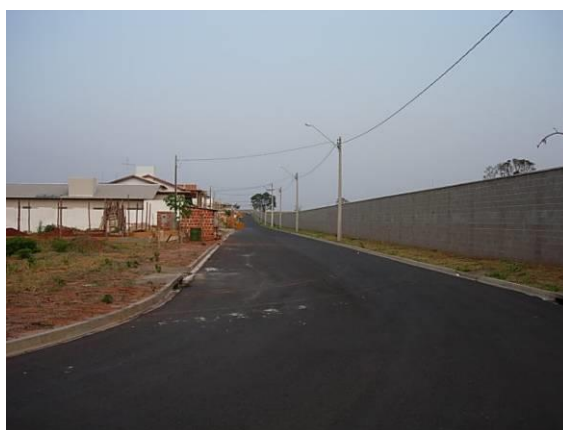
FOTOS B.5.84., B.5.85., B.5.86., B.5.87., B.5.88., B.5.89. e B.5.90. Sistema viário implantado no loteamento. Observa-se a presença dos muros interrompendo as ruas (fotos do autor).
