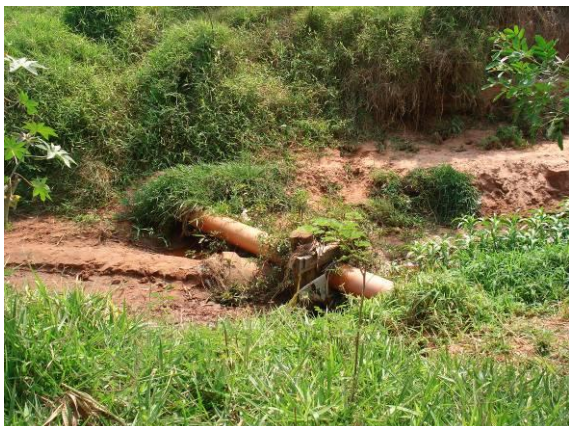
FOTOS B.4.18. e B.4.19. Interceptores e poços de visitas executados pelo DAE para a coleta do esgoto dos loteamentos cuja bacia de contribuição é o Córrego Barreirinho (foto do autor).
