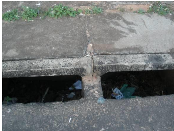
FOTOS B.2.39., B.2.40., B.2.41., B.2.42., B.2.43. e B.2.44. Bocas de lobo que necessitam de limpeza e manutenção (foto do autor).
