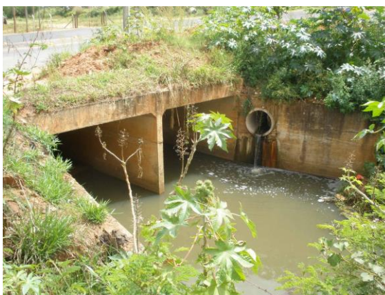
FOTOS B.7.74. Passagem da rede de galerias sob os trilhos da ferrovia (foto do autor).
