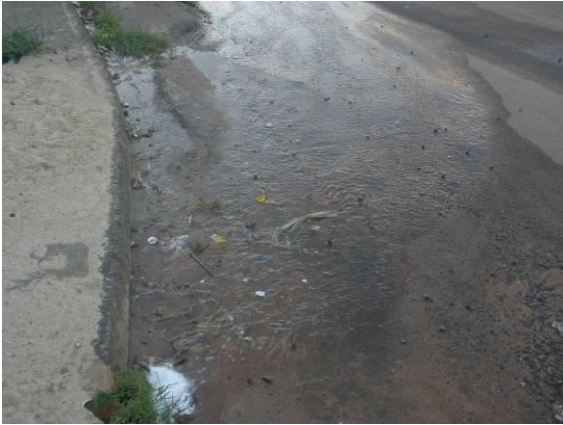
FOTOS B.2.48., B.2.49., B.2.50. e B.2.51. Água escorrendo sobre a pavimentação asfáltica, não captada pelas bocas de lobo (foto do autor).
