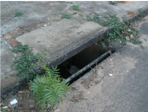
FOTOS B.2.39., B.2.40., B.2.41., B.2.42., B.2.43. e B.2.44. Bocas de lobo que necessitam de limpeza e manutenção (foto do autor).
