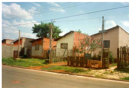
Figura 9 - Casas construídas no Jardim Oriente, através do convênio entre EMDHAP e MISERIOR (Dezembro de 2003) Fonte: Silvia Maria Morales Funes
