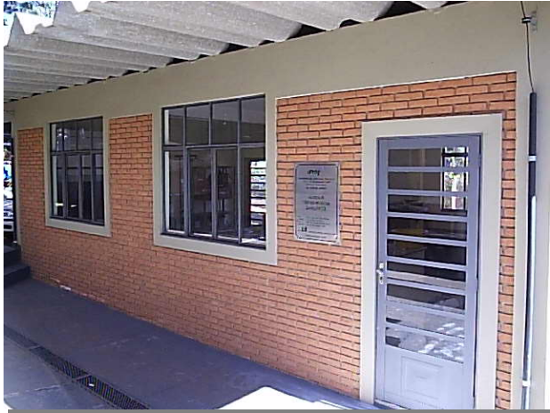
Figura 10: Vista geral – Laboratório de tratamento de resíduos – IQ – UNESP
