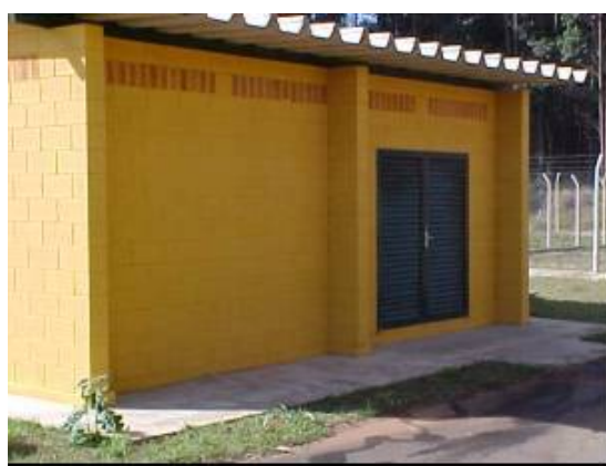
Figura 20: Prédio de estocagem de resíduos químicos.
