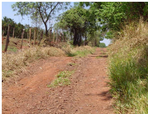
Figura 6.6: Exemplo de estrada não pavimentada classificada como ruim. Fonte: Acervo pessoal
