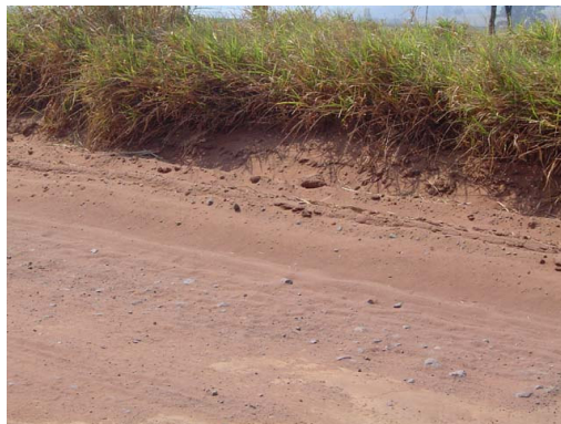
Figura 5 : Exemplo de trilha de roda. Estrada Água Vermelha, São Carlos/SP. Fonte: Acervo pessoal
