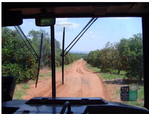
Figura 7: Exemplo de depressões na estrada. Estrada Água Vermelha, São Carlos/SP. Fonte: Acervo pessoal
