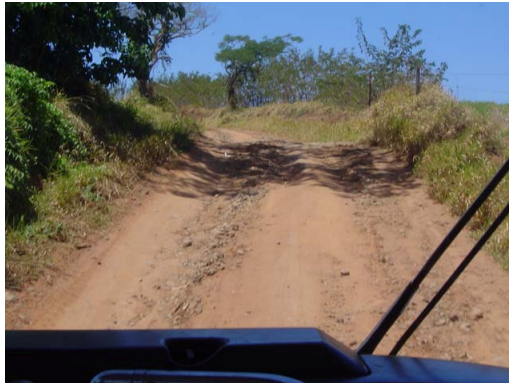
Figura 4 : Exemplo de buracos. Estrada Água Vermelha, São Carlos/SP. Fonte: Acervo pessoal.
