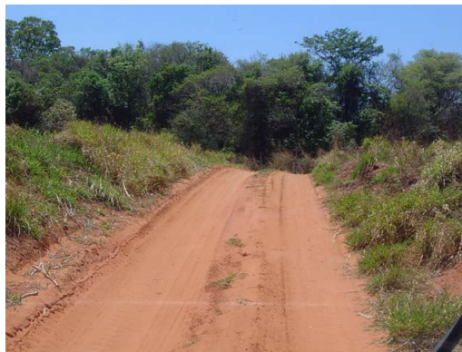
Figura 5 : Exemplo de trilha de roda. Estrada Água Vermelha, São Carlos/SP. Fonte: Acervo pessoal
