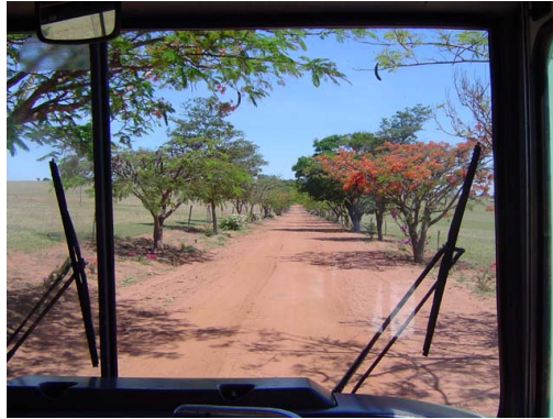
Figura 6.4: Exemplo de estrada não pavimentada classificada como boa. Fonte: Acervo pessoal
