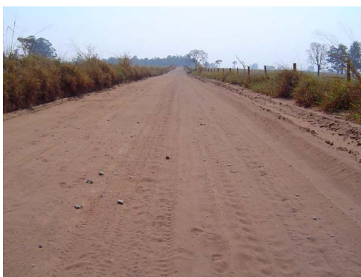
Figura 2: Exemplo de drenagem lateral inadequada. Estrada Represa 29, São Carlos/SP. Fonte: Acervo pessoal
