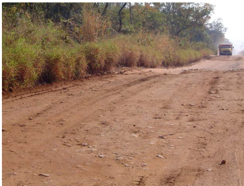
Figura 1: Exemplo de sessão transversal inadequada. Estrada Represa 29, São Carlos/SP. Fonte: Acervo pessoal
