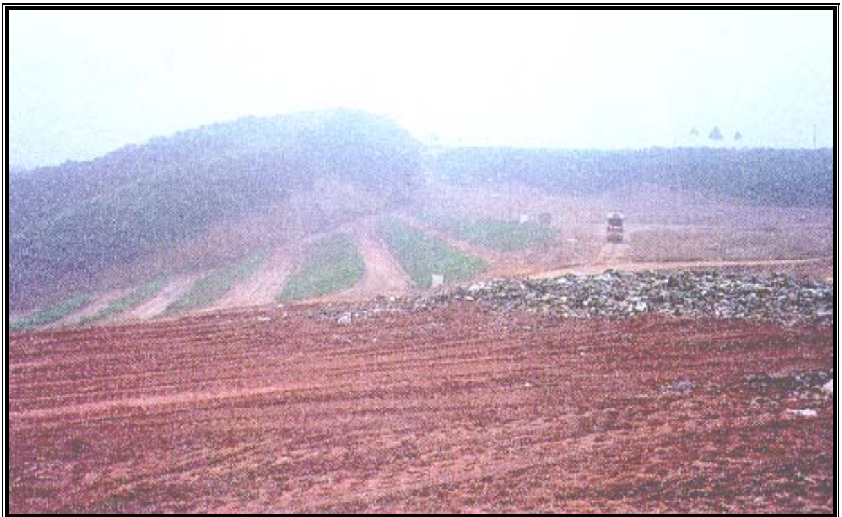
Figura 3.10: Trincheira preenchida pelos resíduos e terminada. Fonte: Bidone, Povinelli, (1999).
