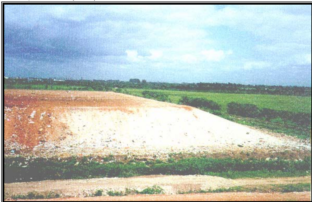
Figura 3.12: Célula de aterro sanitário tronco-piramidada executada em área (DMLU/PMPA).
