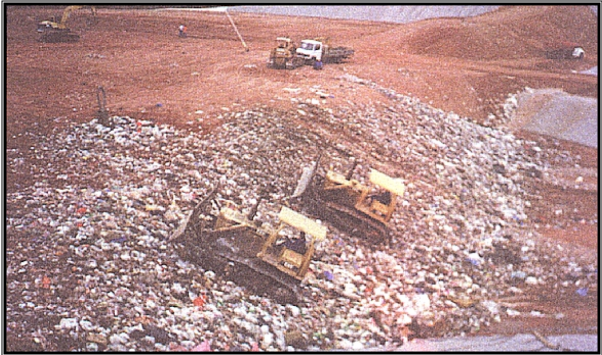
Figura 3.14: Compactação de resíduos contra uma encosta. Fonte: Bidone, Povinelli, (1999).
