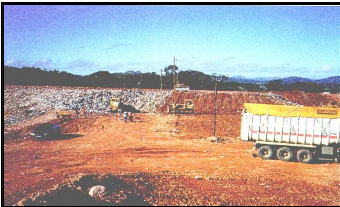
Figura 3.13: Execução de uma célula de aterro sanitário aproveitando-se a encosta como elemento de contenção Fonte: Bidone, Povinelli, (1999).
