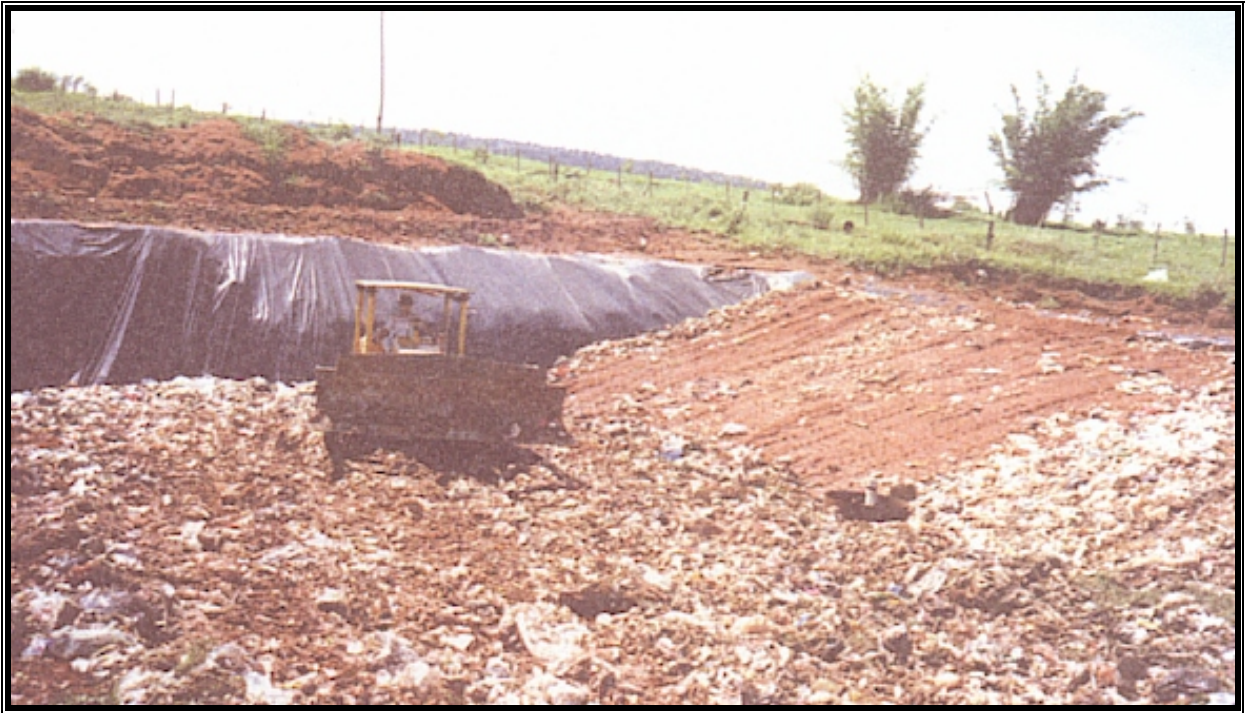
Figura 3.9: Compactação dos resíduos a partir de uma das extremidades da trincheira Fonte: Bidone, Povinelli (1999).
