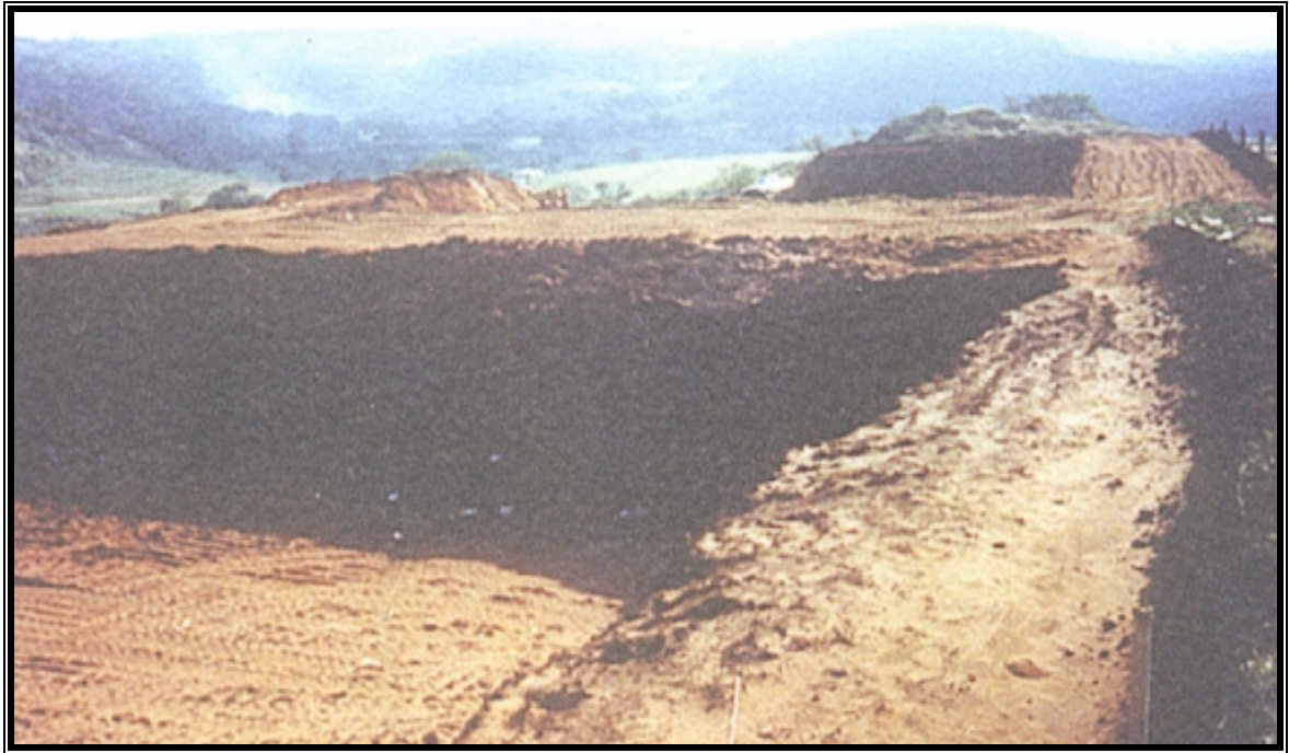
Figura 3.7: Abertura de uma trincheira de grande porte. Fonte: Bidone, Povinelli (1999).
