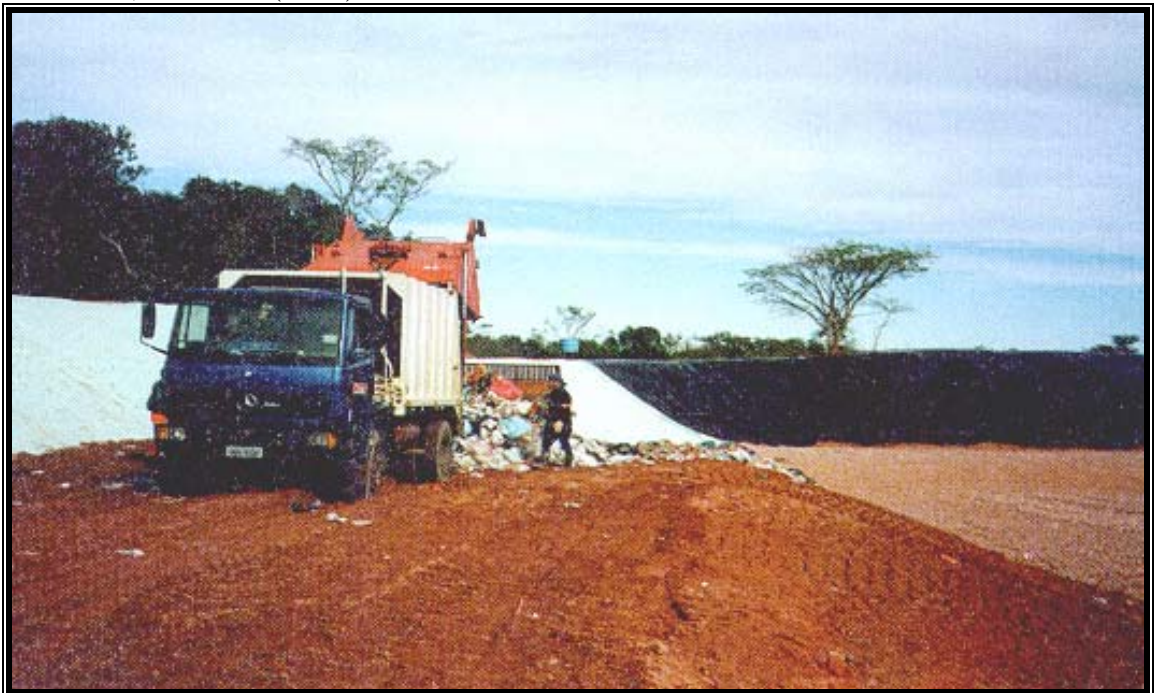
Figura 3.8: Descarga de resíduos no interior da trincheira. Fonte: Bidone, Povinelli (1999).
