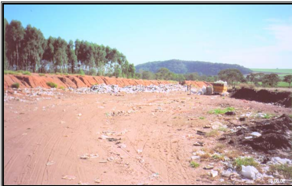
Figura2.4 Ao fundo outro talude com feições erosivas mais a presença de catadores. Fonte: Autor.
