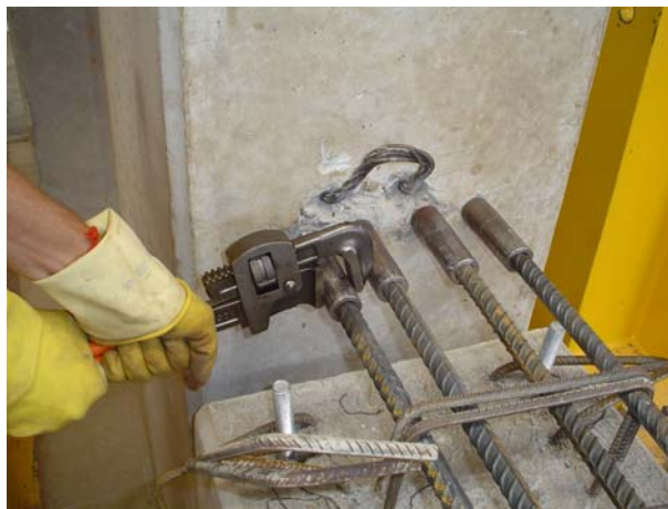
Figura 3-10 - Detalhe das luvas prensadas rosqueadas.
