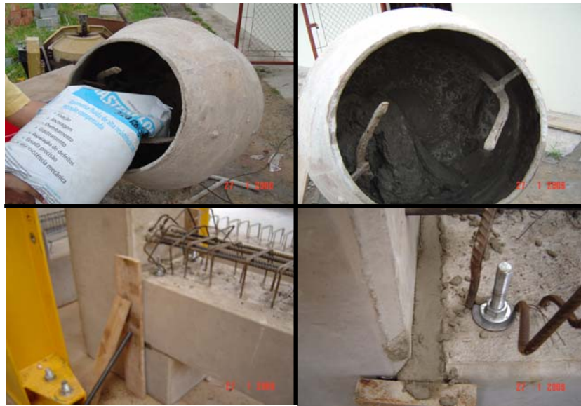
Figura 3-12 – Amassamento e aplicação do graute.
