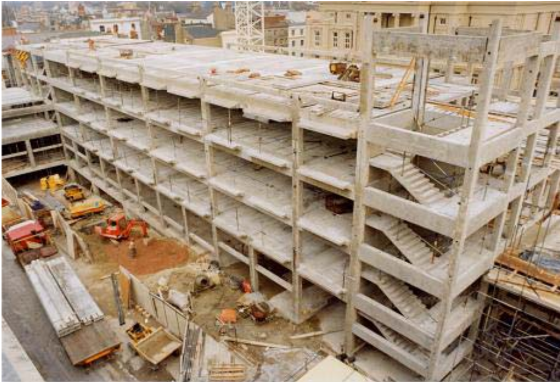
Figura 2-2 - Exemplo de estrutura pré-moldada em esqueleto para múltiplos pavimentos [FIB (2003)].
