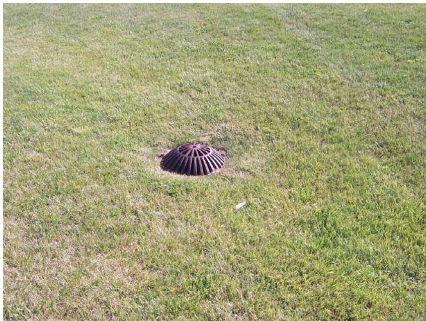
Figura 4.66 – Dreno de fundo da área de acumulação
