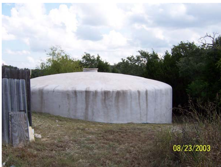
Figura 4.54 – Reservatório em concreto armado
