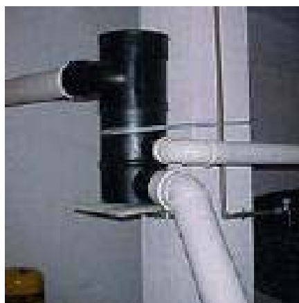
Figura 4.70 – Filtro de retenção
