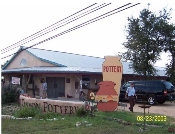
Figura 4.53 – Área de captação da edificação
