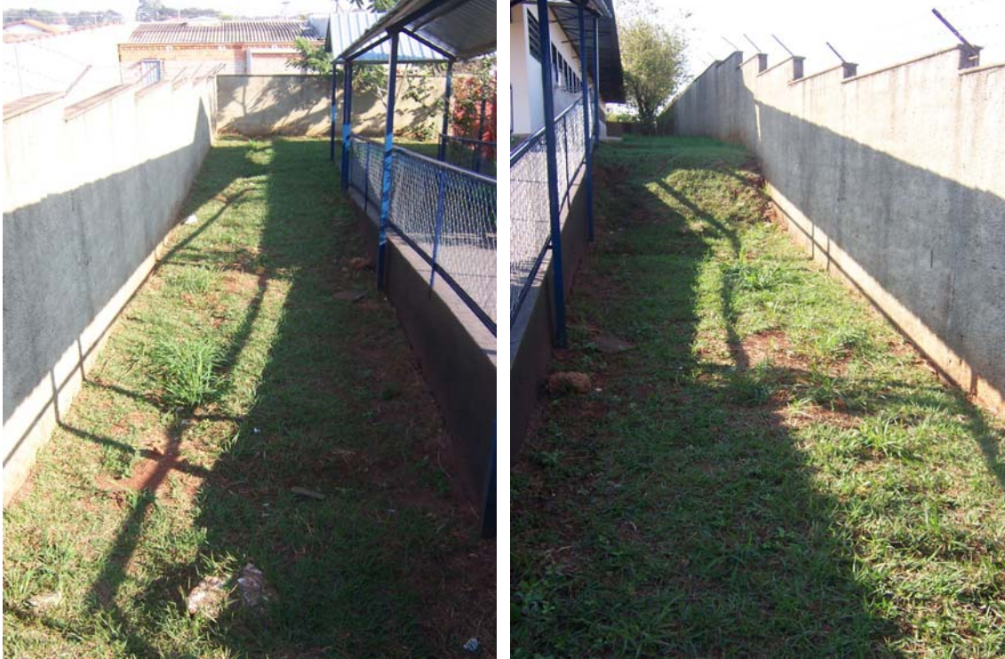
Figura 6.18 – Erosão e remoção do solo no corredor lateral na parte posterior do lote
