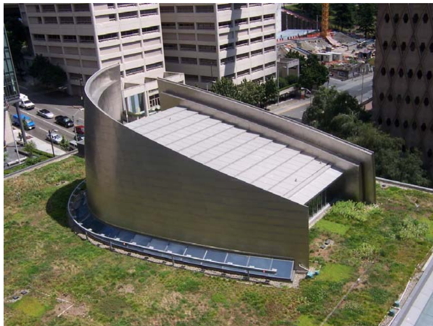
Figura 4.16 – Cobertura verde do bloco menor do edifício
