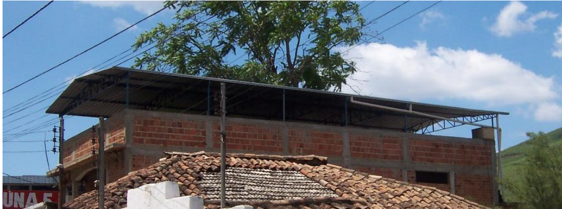
Figura 4.89 – Galpão comercial com telhado elevado
