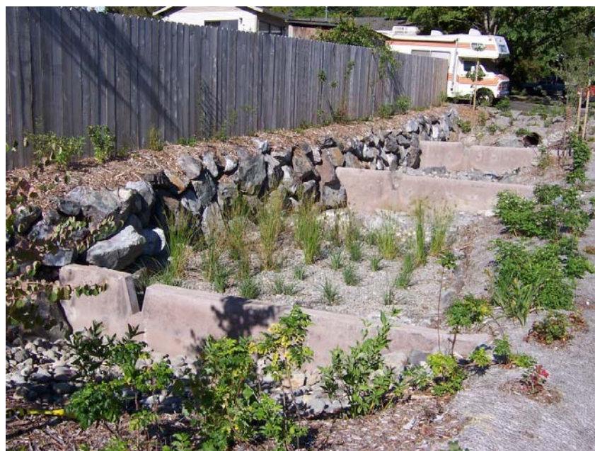
Figura 4.43 – Dispositivo de retenção em via transversal descendente
