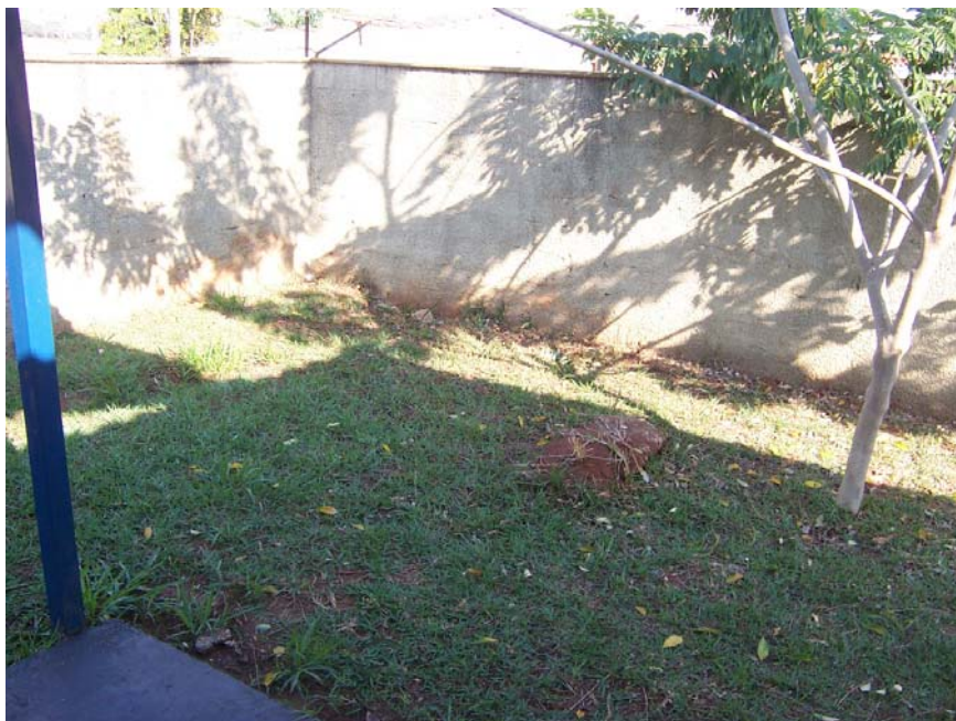
Figura 6.19 – Erosão e remoção do solo no corredor lateral na parte posterior do lote
