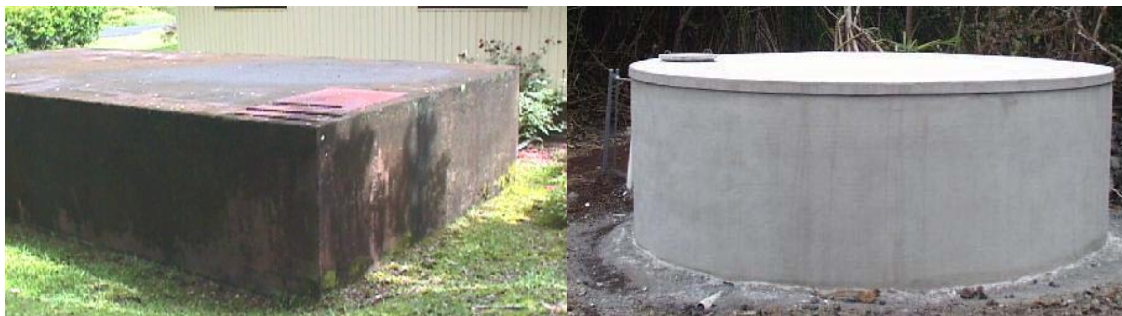
Figura 4.51 – Reservatório construído em concreto (Havaí)
