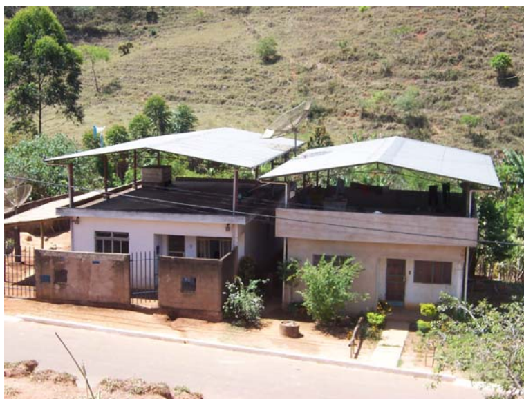
Figura 4.88 – Residências com telhado elevado
