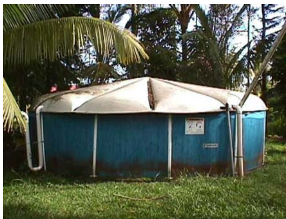
Figura 4.45 – Reservatório construído em fibra de vidro (Havaí)
