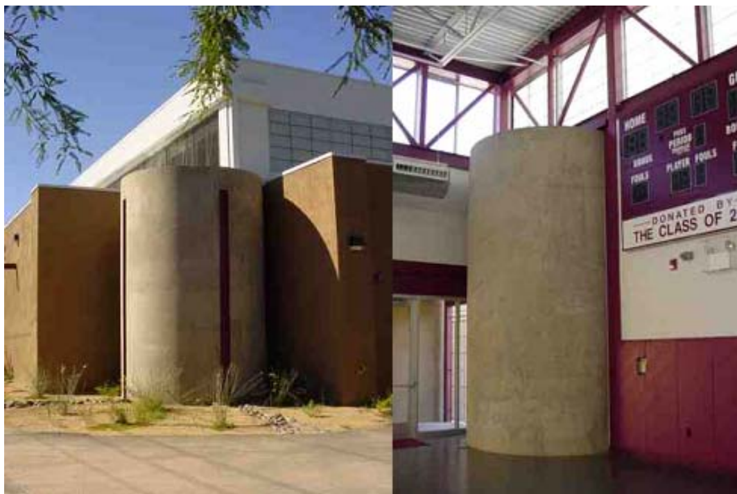
Figura 5.5 - Vista externa e interna de reservatório em quadra esportiva
