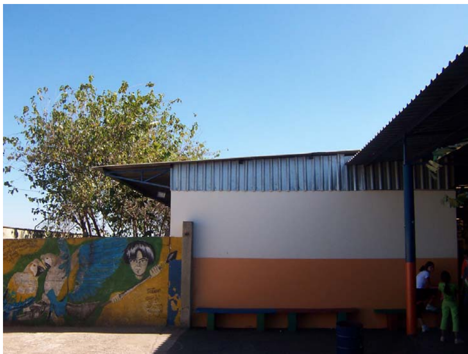
Figura 6.8 – Cobertura do bloco de salas de aula
