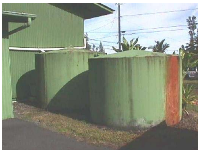
Figura 4.50 – Reservatório construído em ferrocimento (Havai)
