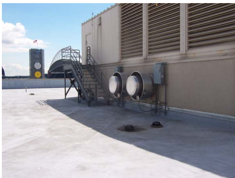
Figura 4.28 – Vista da área de captação (cobertura)
