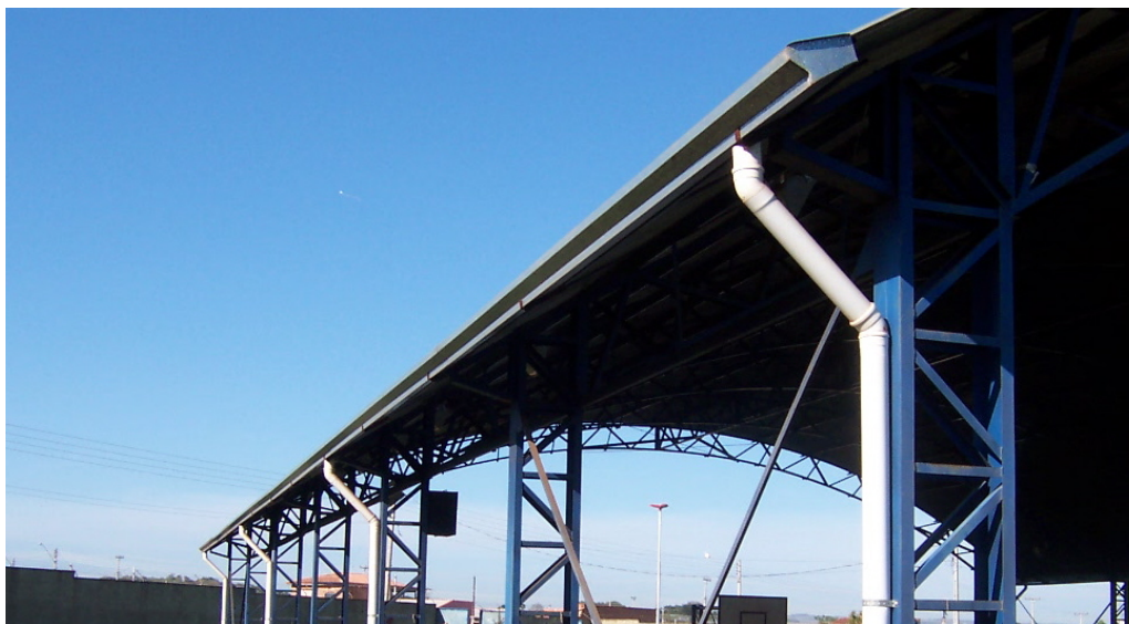
Figura 6.11 – Calha e condutores verticais em quadra poliesportiva
