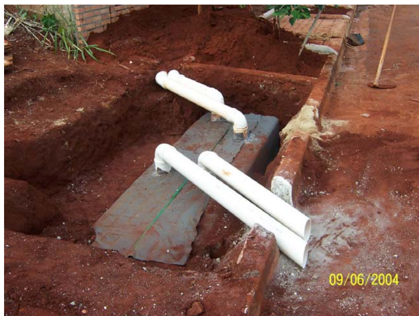
Figura 4.80 - Reservatório instalado
