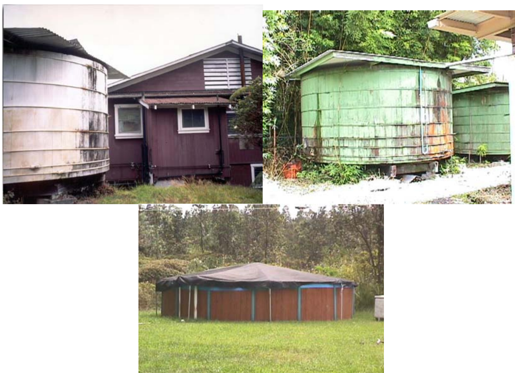
Figura 4.44 – Reservatórios construídos em madeira (Havaí)
