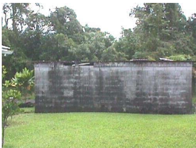
Figura 4.49 – Reservatório construído em blocos de concreto (Havai)
