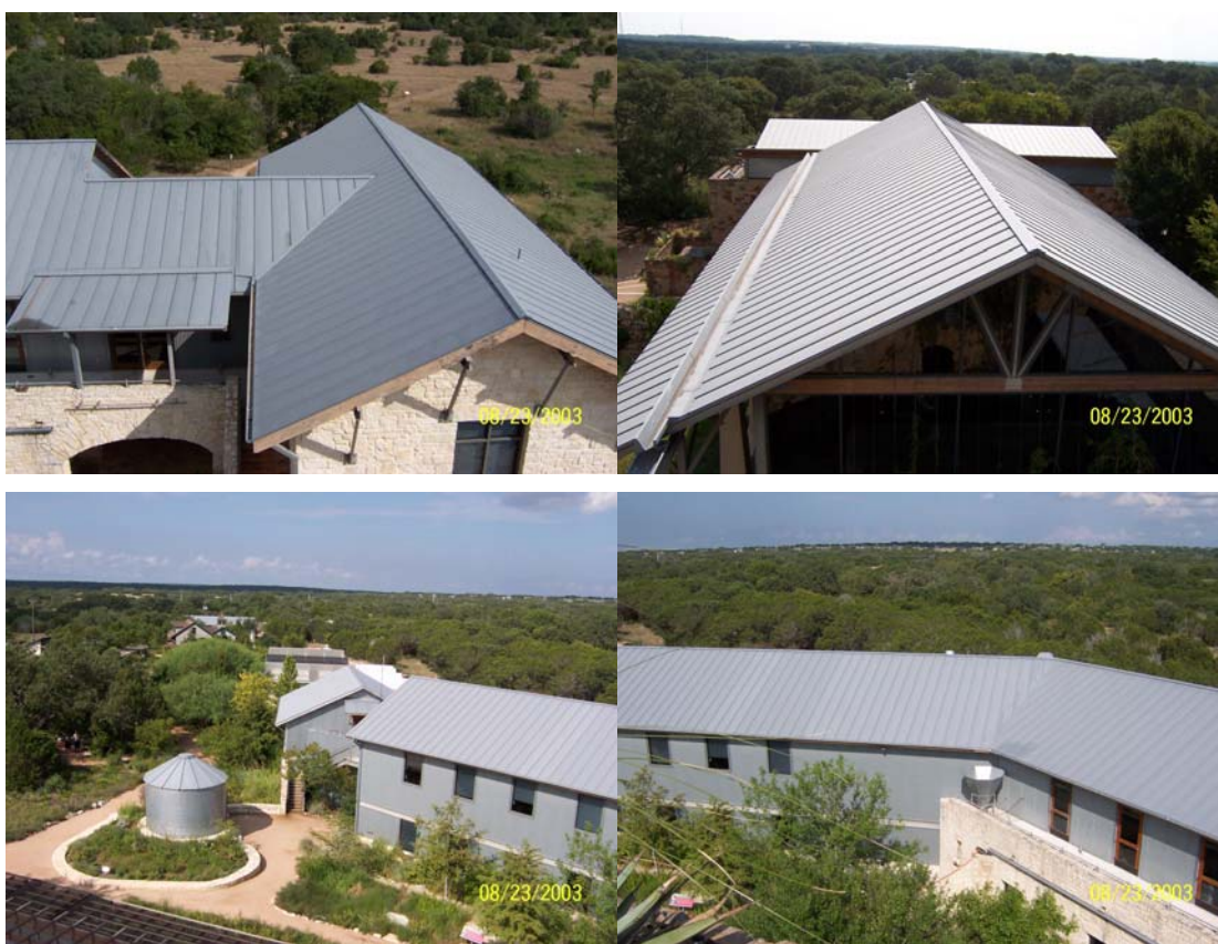
Figura 4.57 – Vista da área da captação (cobertura)
