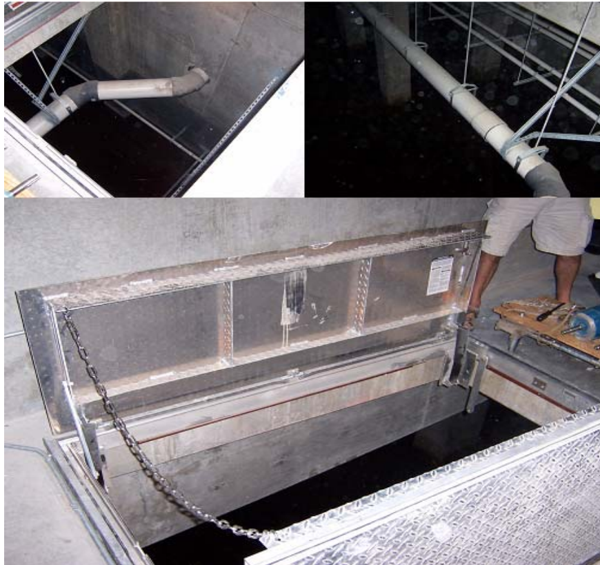
Figura 4.19 – Cisterna e passagem de acesso ao seu interior
