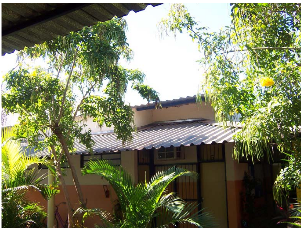
Figura 6.10 – Cobertura do setor administrativo
