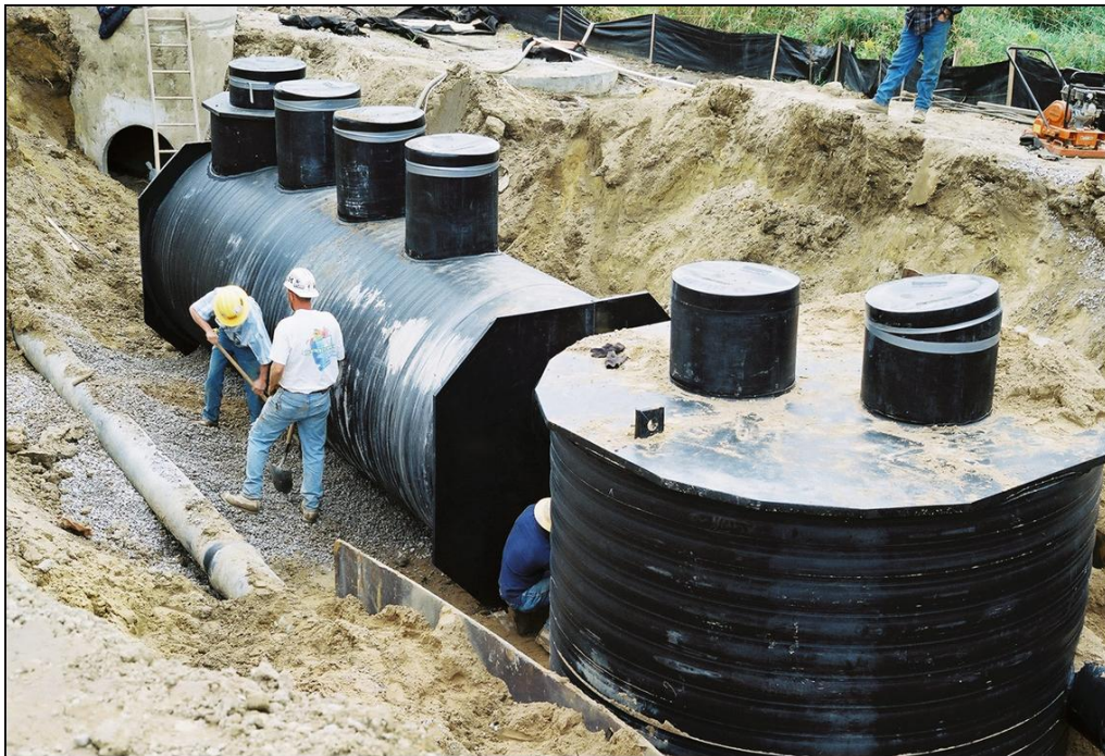
Figura 4.8 – Conjunto separador de sólidos/filtro de óleo
