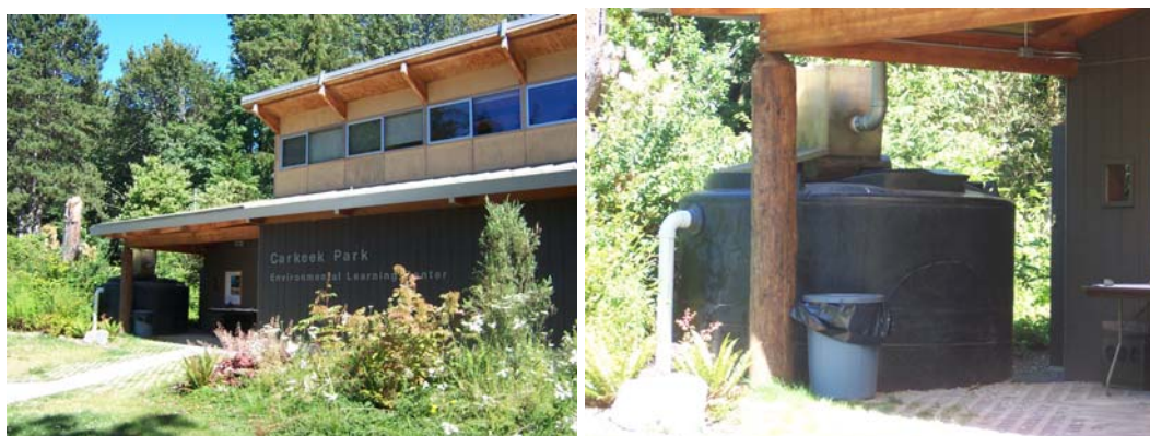
Figura 4.29 – Vista da fachada do edifício e do reservatório de água pluvial
