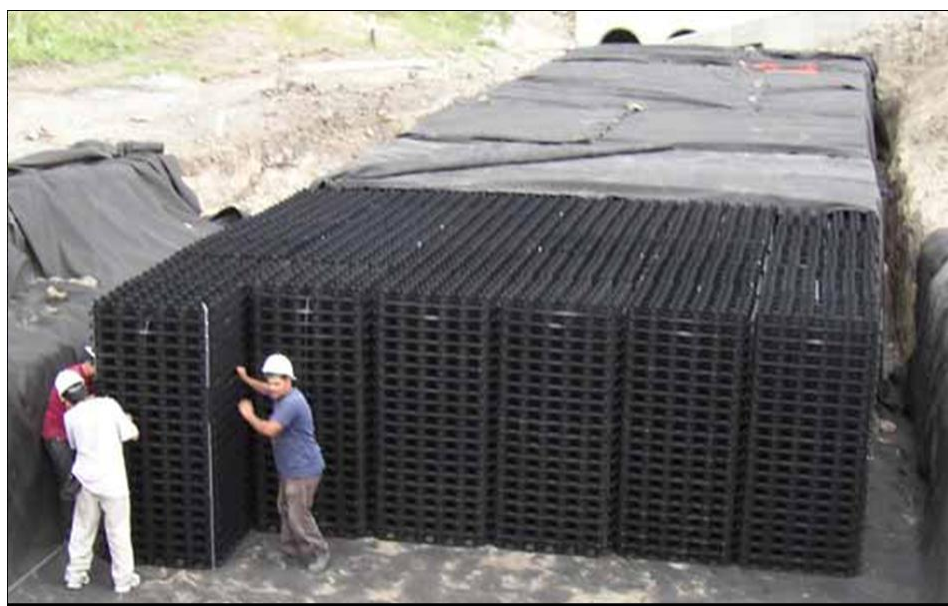
Figura 4.96 – Montagem de um reservatório de infiltração de grandes dimensões
