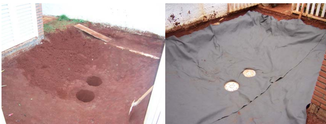
Figura 4.85 - Remoção do solo e colocação de drenos verticais
