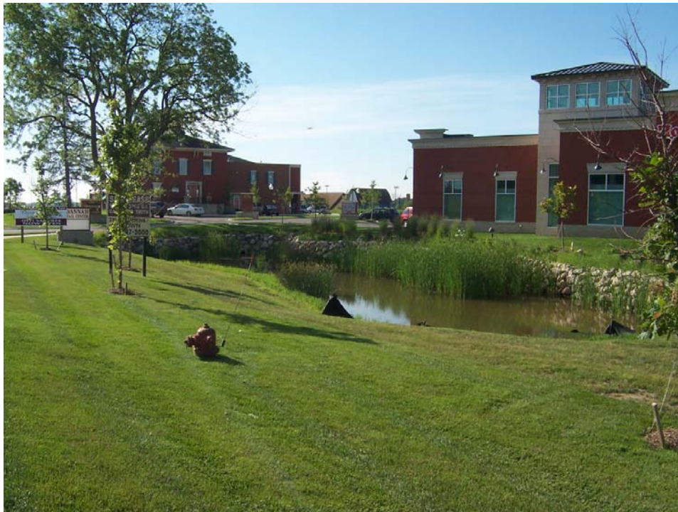
Figura 4.64 – Reservatório para detenção da água superficial
