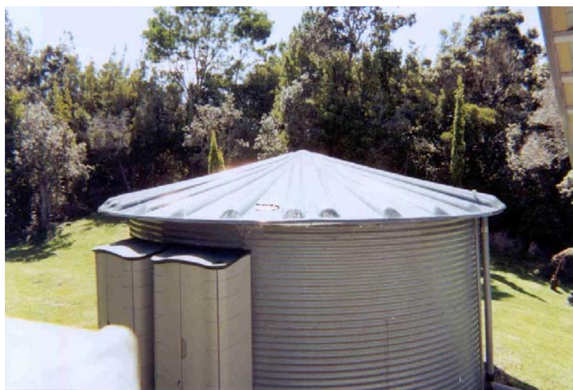
Figura 4.47 – Reservatório construído em chapa galvanizada e recoberto com o mesmo material (Havaí)
