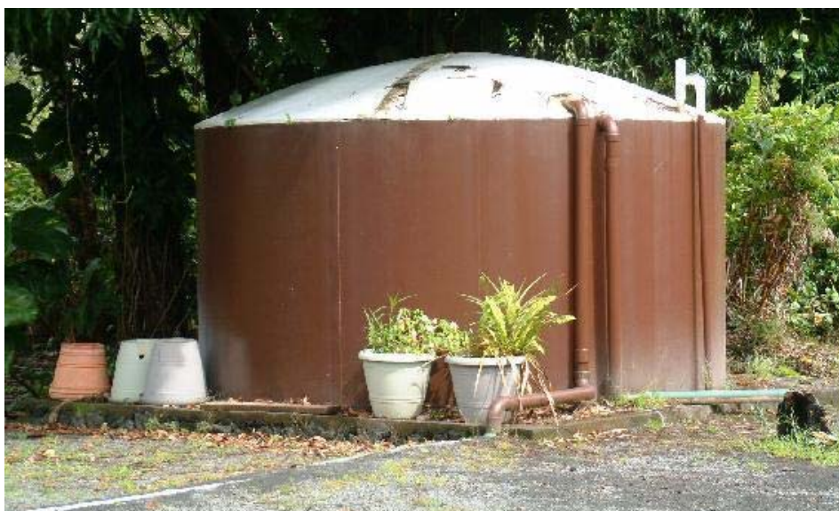
Figura 4.48 – Reservatório construído em chapa lisa de aço (Havaí)
