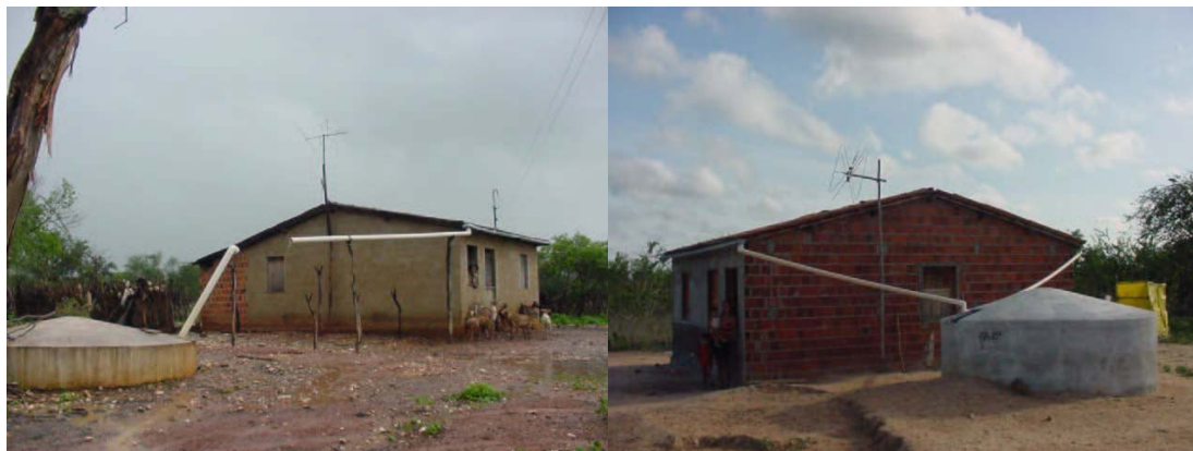
Figura 4.67 – Cisterna de placa
