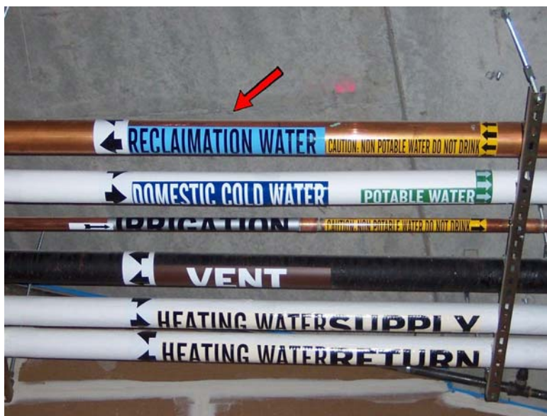
Figura 4.21 – Identificação da rede de água pluvial aproveitada
