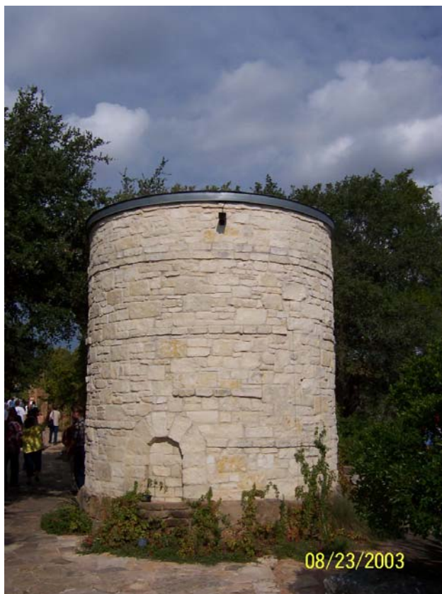
Figura 4.60 – Vista do reservatório da entrada do complexo
