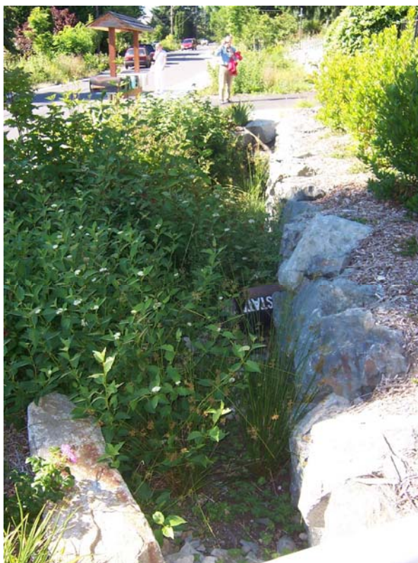
Figura 4.42 – Detalhe da vegetação plantada na vala de infiltração
