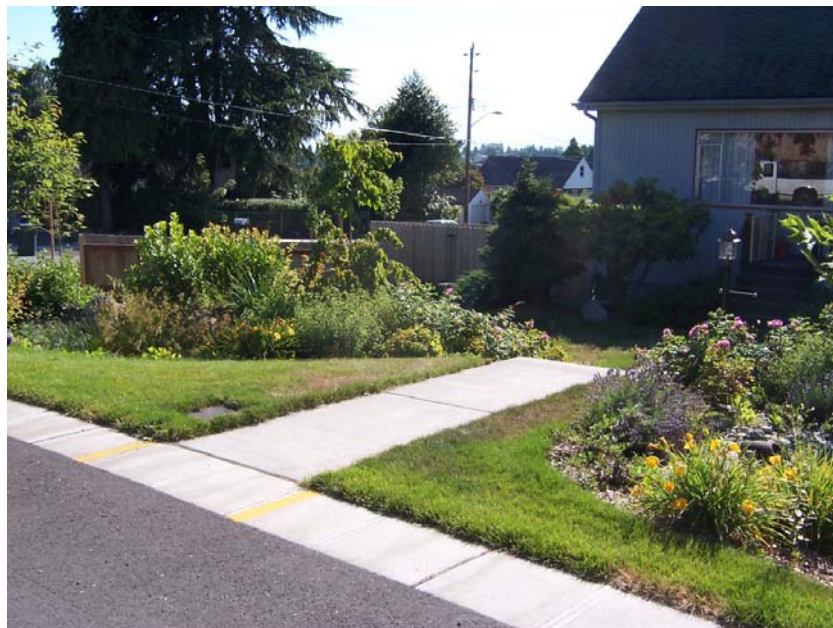
Figura 4.41 – Valas de infiltração na testada do lote
