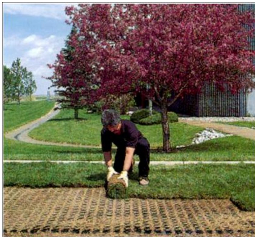
Figura 4.97 – Plantio de grama utilizando a placa de suporte
