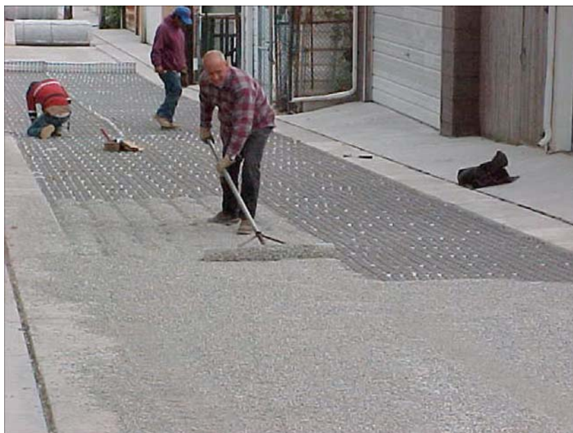
Figura 4.98 – Execução de pavimentação permeável com a utilização da placa de suporte
