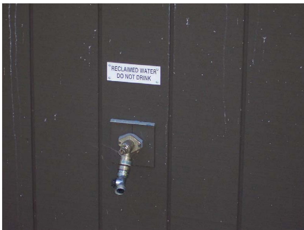
Figura 4.38 – Sinalização de alerta
