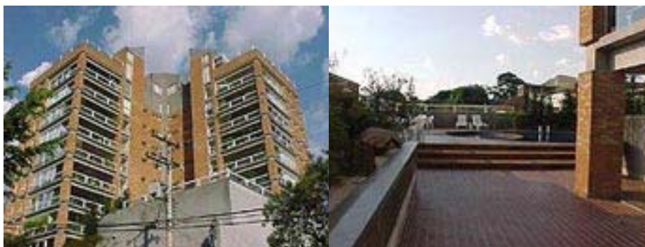
Figura 4.69 – Vista do edifício e da área externa
