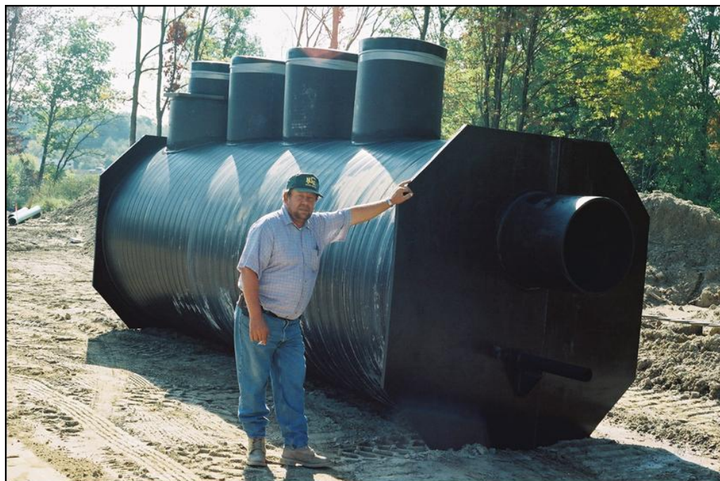
Figura 4.7 – Conjunto filtrante de óleo
