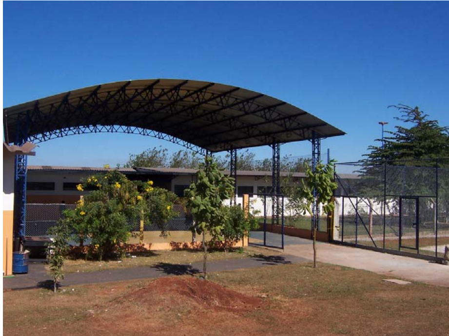
Figura 6.7 – Cobertura da quadra de apoio
