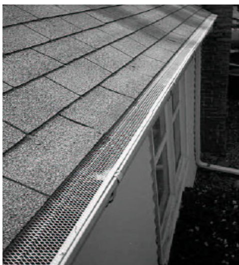
Figura 6.20 – Tela protetora instalada na calha
