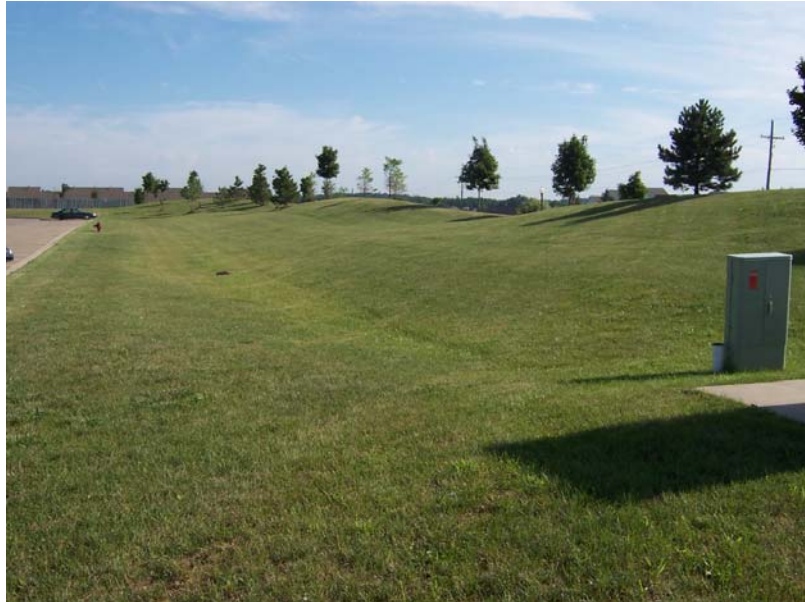
Figura 4.65 – Área de acumulação da água captada pelo estacionamento
