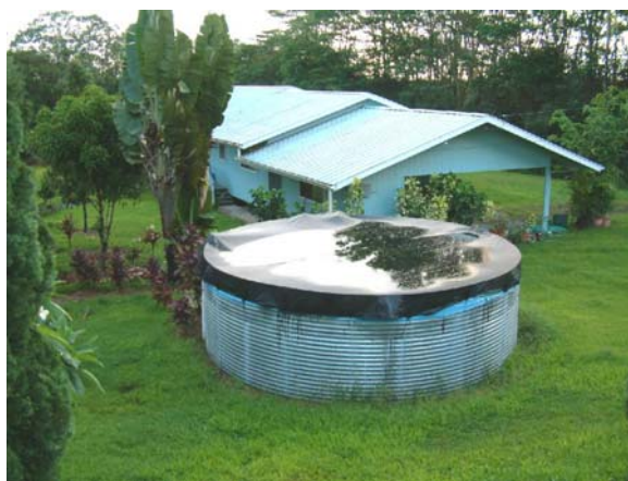
Figura 4.46 – Reservatório construído em chapa galvanizada e recoberto com tela em tecido sintético (Havaí)
