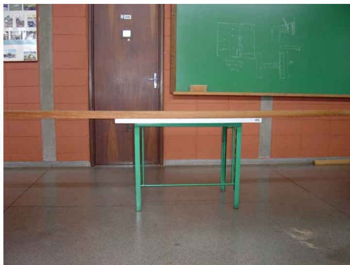
Figura 4.18. Viga empenada (encurvamento).
