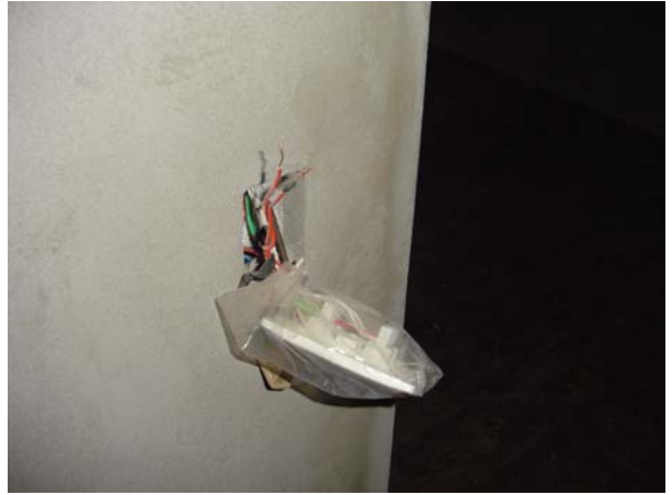
Figura 4.12 - Condutores expostos.
