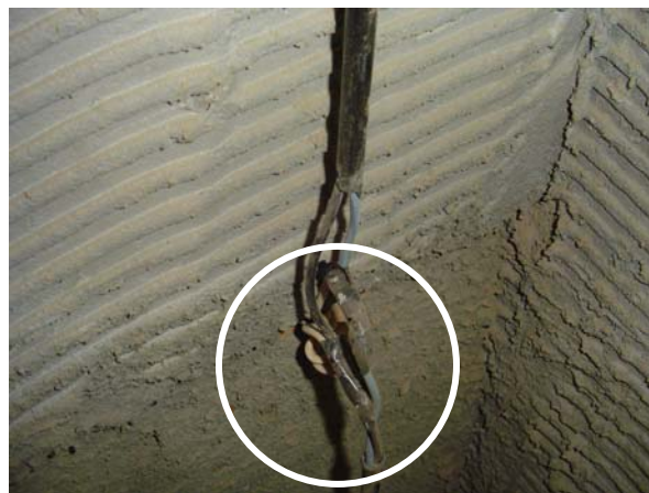
Figura 5.32 - Isolação em emenda de condutores.
