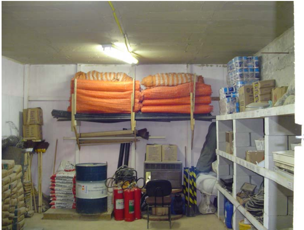
Figura 5.5 - Almoxarifado da obra em boas condições de limpeza, iluminação, ventilação e organização.
