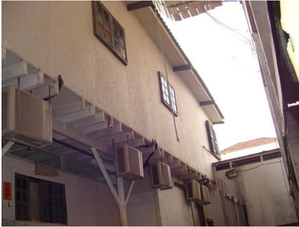
Figura 5.1 - Edificação provisória destinada a alojamento (pavimento superior) e escritórios e almoxarifados (pavimento inferior) dos trabalhadores terceirizados.
