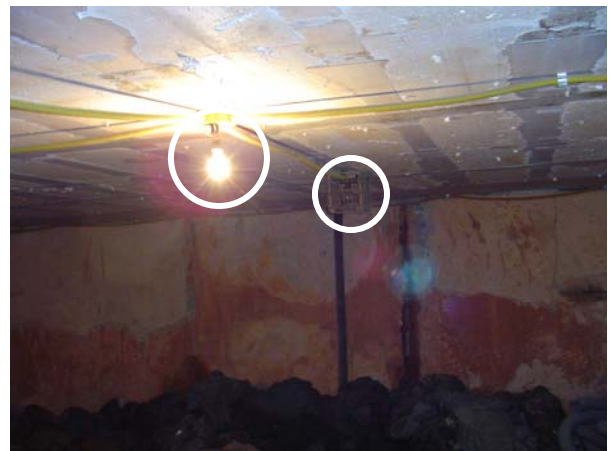
Figura 5.20 – Lâmpadas em área de circulação sem e com proteção contra impactos mecânicos.
