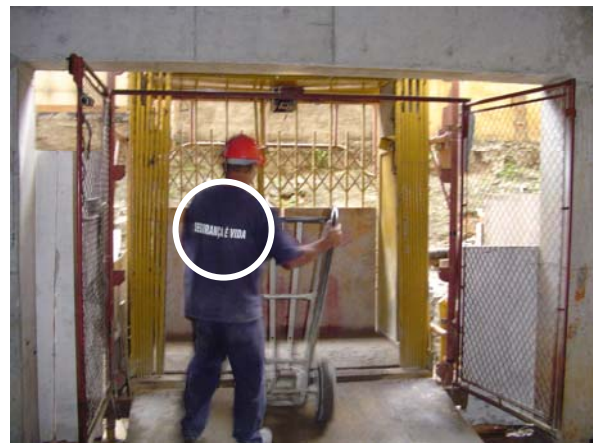
Figura 5.9 - Utilização de indumentária na sinalização de segurança.
