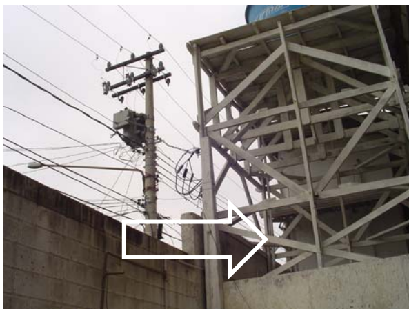
Figura 5.31 - Obstáculo localizado na entrada de energia do canteiro de obras.
