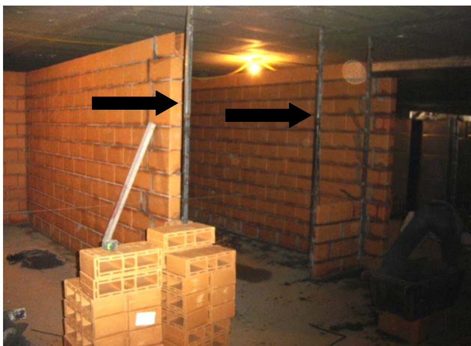
FIGURA 3.10 – Utilização de escantilhões na elevação da alvenaria
