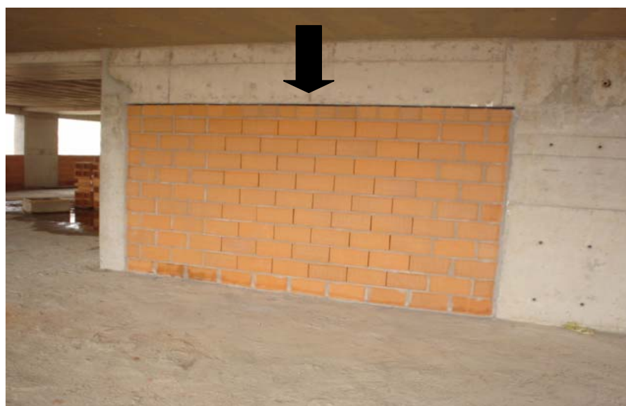
FIGURA 3.11 – Vão para fixação da alvenaria à estrutura Fonte: Arquivo pessoal do autor
