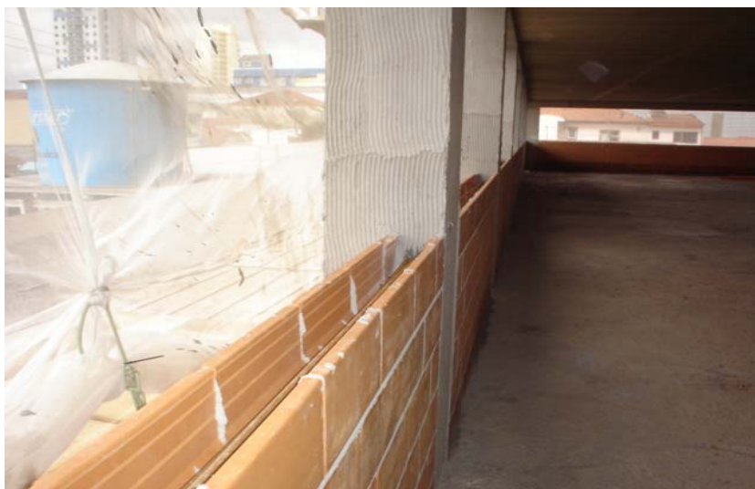
FIGURA 5.32 – Alvenaria de fachada pelo lado interno do pilar
