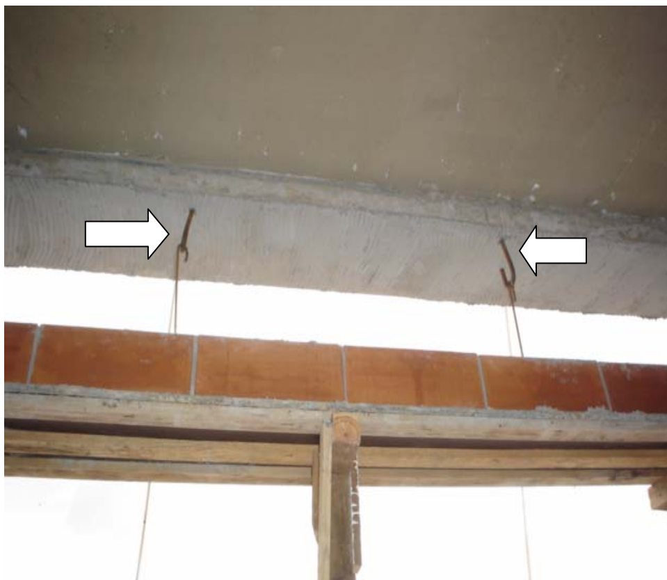
FIGURA 5.27 – Ganchos para sustentar ferragem das vergas dos caixilhos de fachada Fonte: Empresa pesquisada (Obra C)
