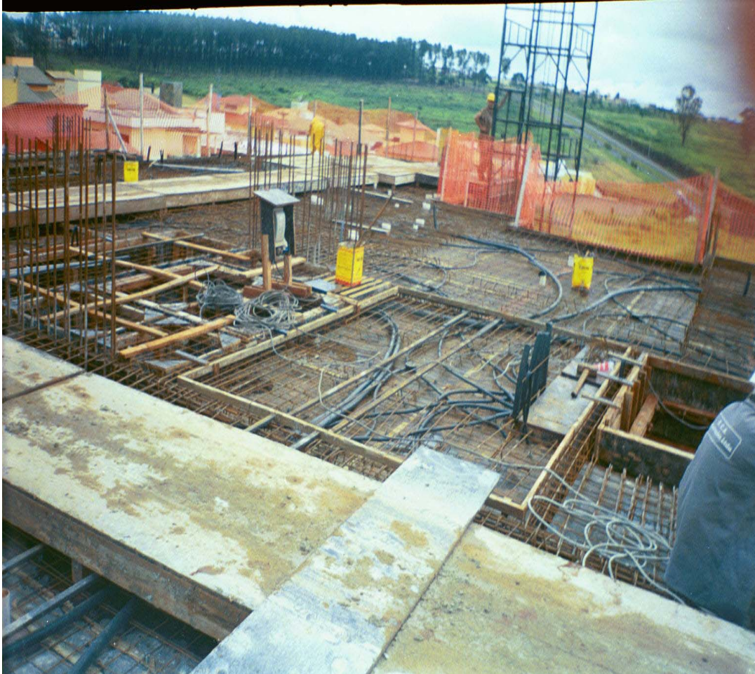
FIGURA 5.4 – Caminhos de concretagem Fonte: Empresa pesquisada (Obra A)
