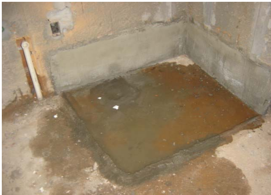
FIGURA 5.35 – Impermeabilização de box de banheiro com cimento polimérico estruturado Fonte: Empresa pesquisada (Obra C)
