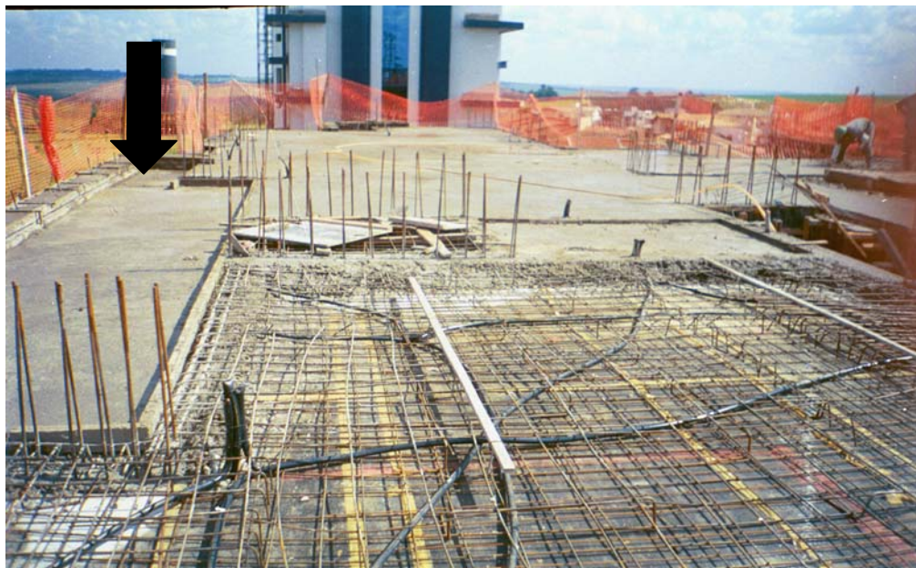
FIGURA 5.6 – Preparo para rebaixo da laje de sacada Fonte: Empresa pesquisada (Obra A)
