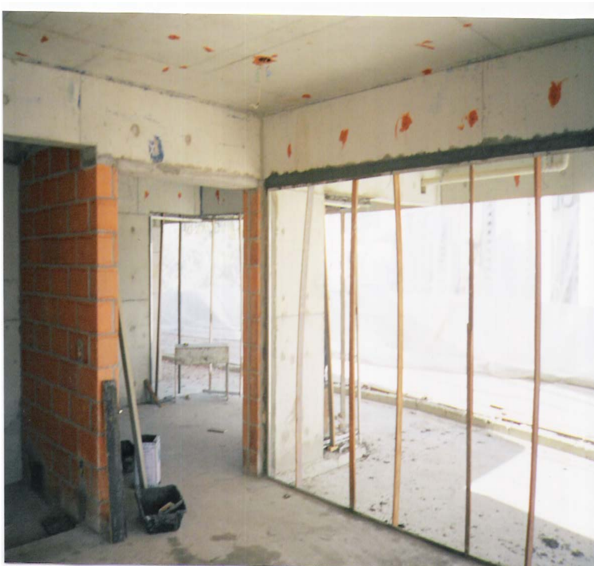
FIGURA 5.15 – Preenchimento com argamassa do vão entre viga e contramarco de alumínio Fonte: Empresa pesquisada (Obra B)
