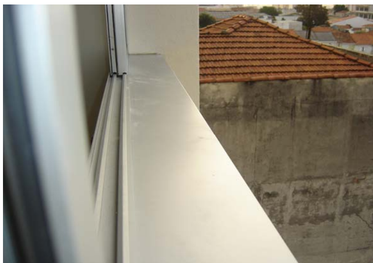
FIGURA 5.34 – Caixilho instalado com peitoril em chapa de alumínio Fonte: Empresa pesquisada (Obra C)
