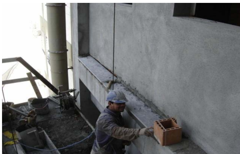
FIGURA 5.33 – Assentamento de peitoril de ardósia sobre viga da fachada
