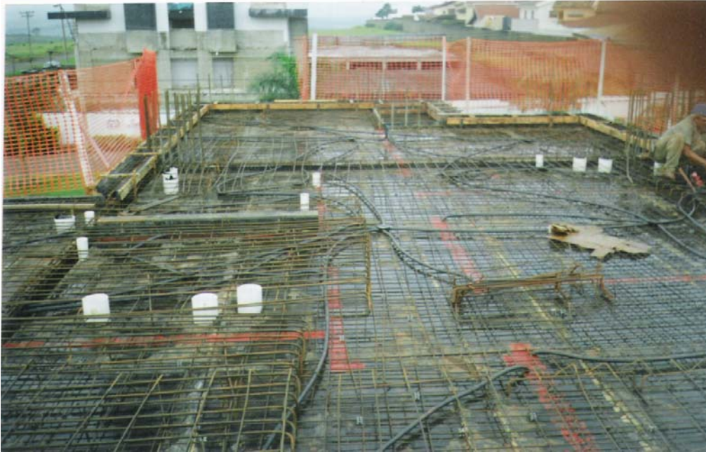
FIGURA 5.5 – Localização das paredes na fôrma Fonte: Empresa pesquisada (Obra A)
