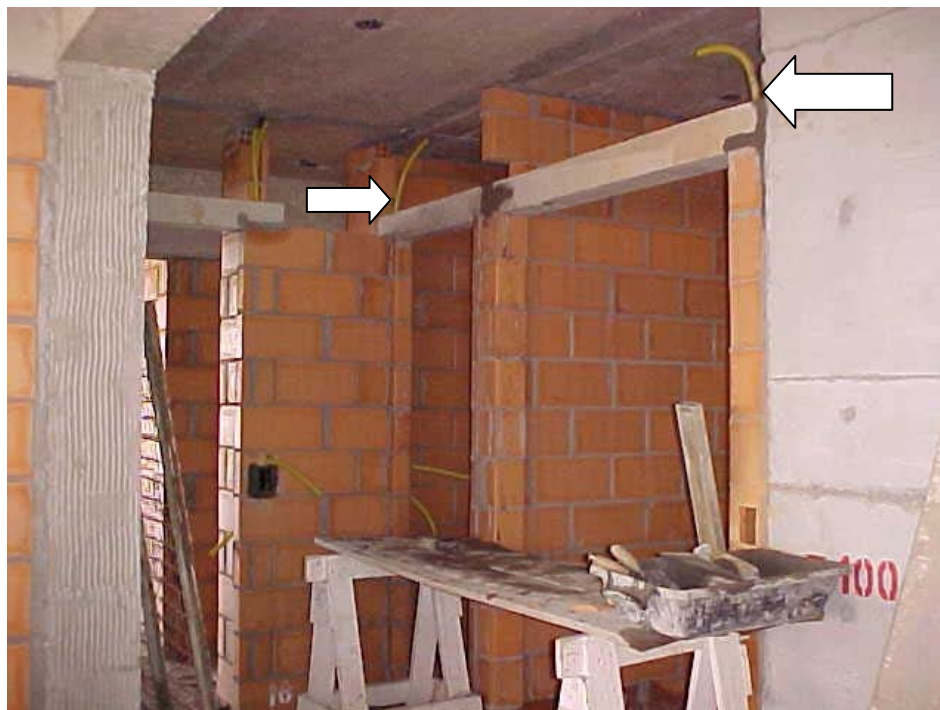
FIGURA 5.18 – Vergas pré-moldadas com previsão para passagem de eletrodutos Fonte: Empresa pesquisada (Obra B)
