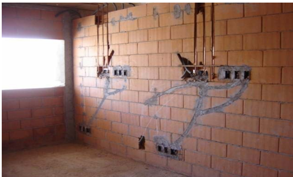
FIGURA 5.31 – Rasgos nas alvenarias para passagem de eletrodutos e tubulação de cobre de gases medicinais Fonte: Empresa pesquisada (Obra C)
