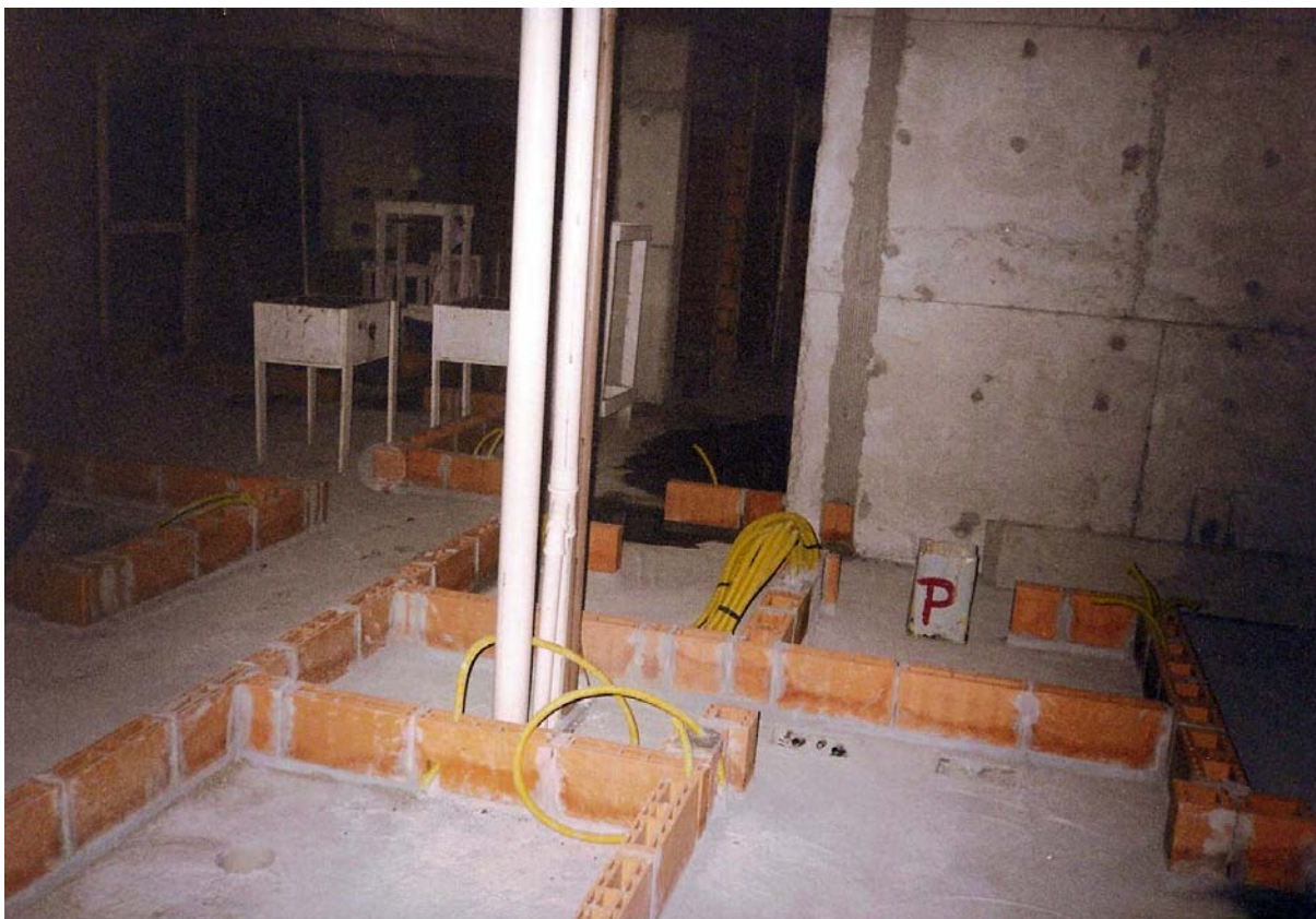
FIGURA 5.8 – Marcação da 1ª fiada sem numeração das paredes
