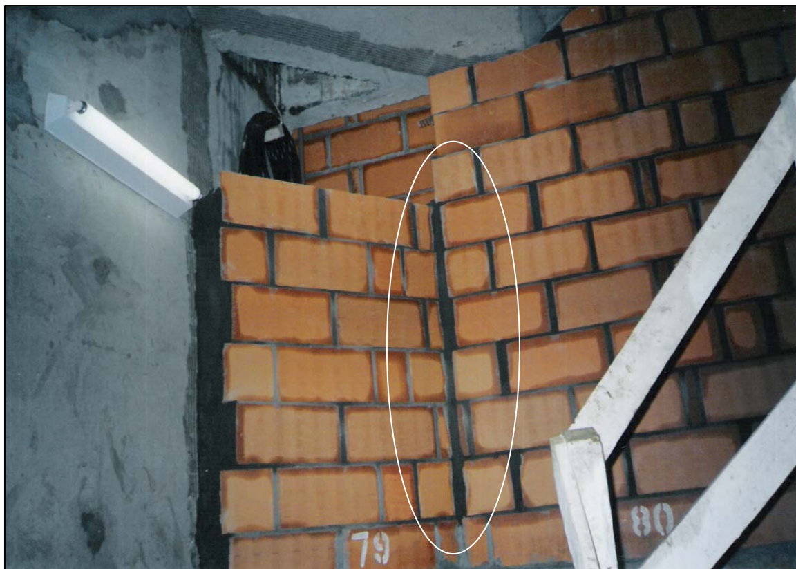
FIGURA 5.12 – Paredes 79 e 80 com utilização de submódulos e junta vertical espessa Fonte: Empresa pesquisada (Obra B)
