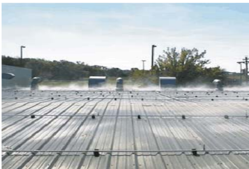
Figura 10: Aspersão de Água na Cobertura Fonte: Adesso, 2007
